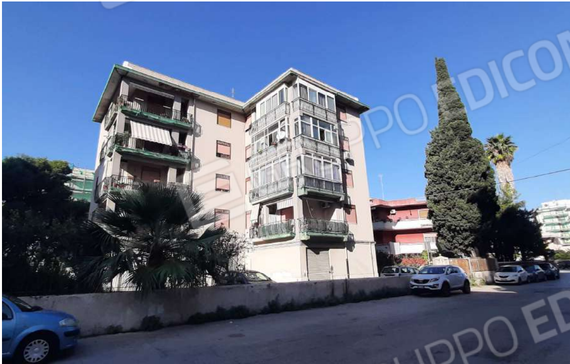
01: Vista Complesso Condominiale dalla Via Carlentini;
