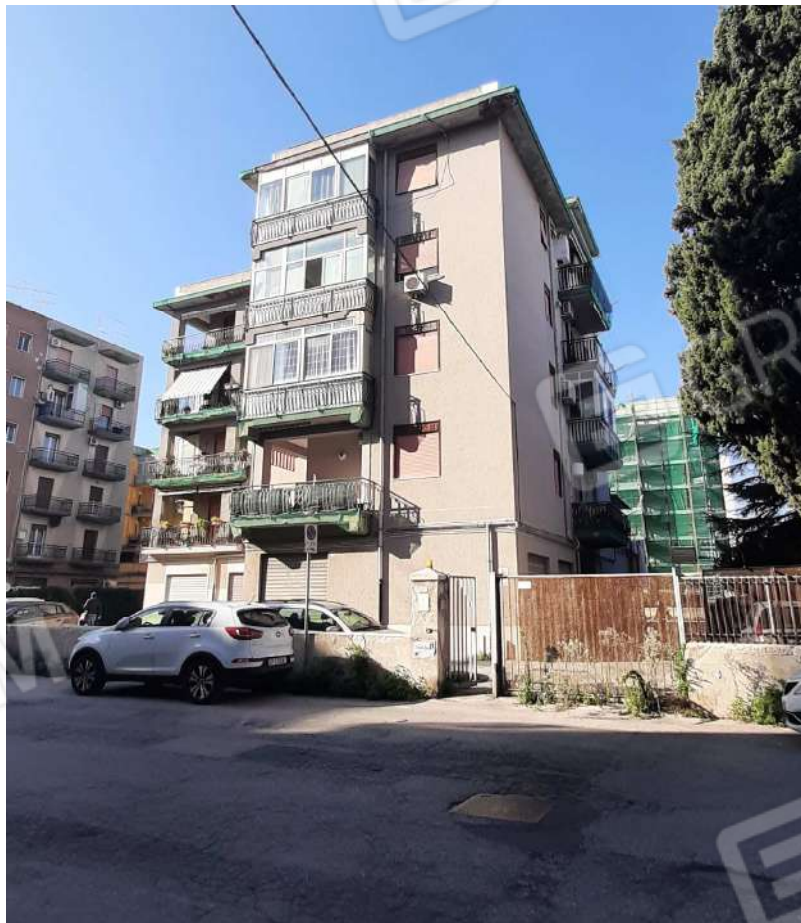
02: Vista Complesso Condominiale dalla Via Carlentini;
