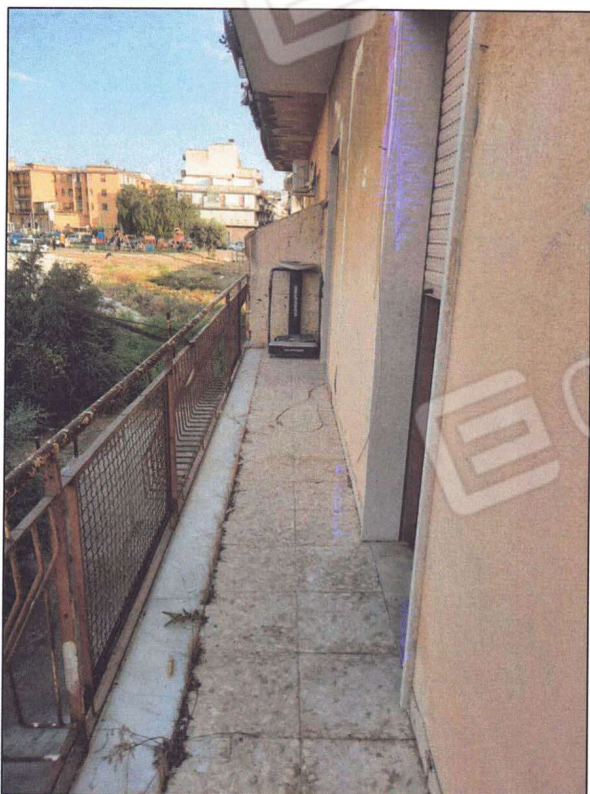
Foto 18-19 - Foto del balcone non in buono stato conservativo e di finitura. Sono necessari lavori di impermeabilizzazione e sostituzione di pavimentazione. Foto della camera 3 pavimentata in marmo e con rifiniture da capitolato anni sessanta.
