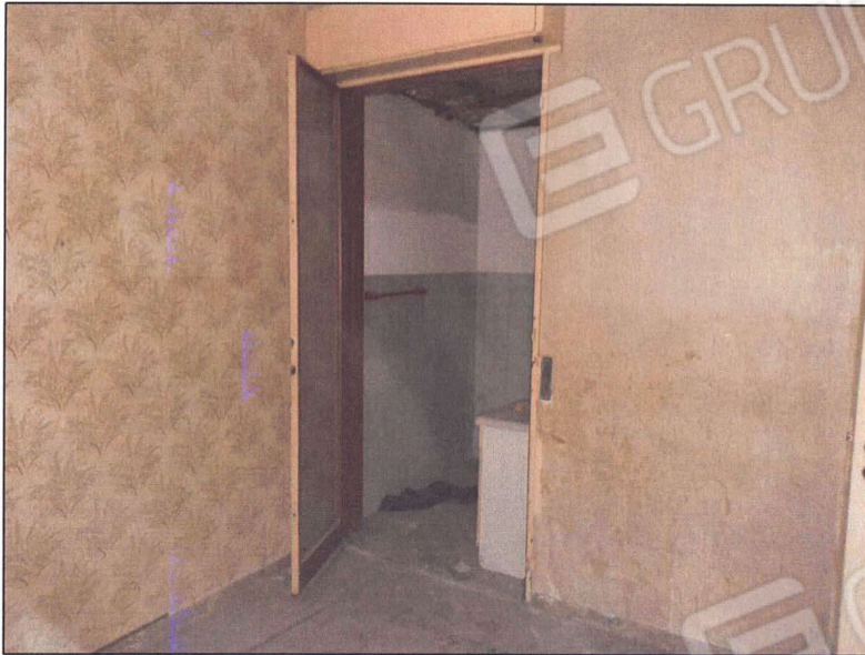
Foto 14-15 - Foto della camera 2 da cui si accede al wc 2, quest'ultimo ricavato abusivamente all'interno del cavedio. Occorre ripristinare la superficie del cavedio e l'apertura finestrata.
