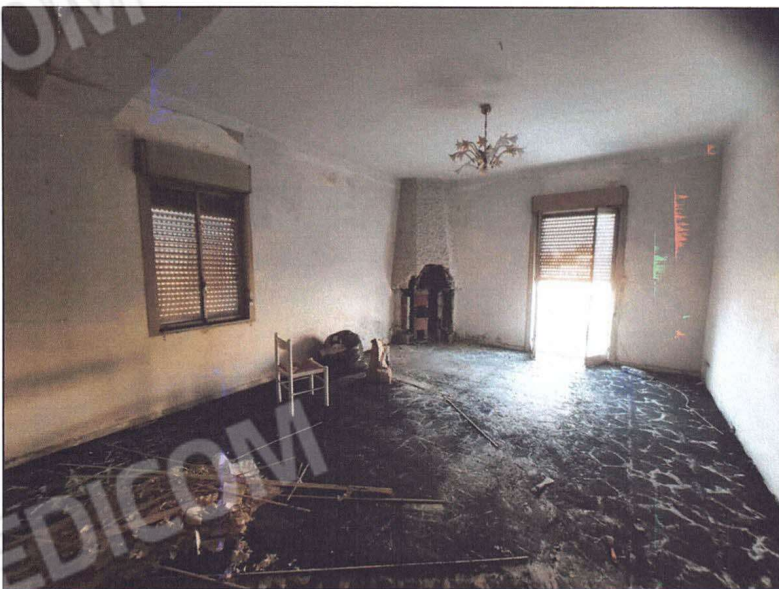
Foto 16 - 17 - Vista del soggiorno dal lato cucina e dal lato finestrato. L'ambiente ha pavimentazione in marmo, è rifinito con intonaco che in alcune parti è mancante e presenta macchie e umido.
