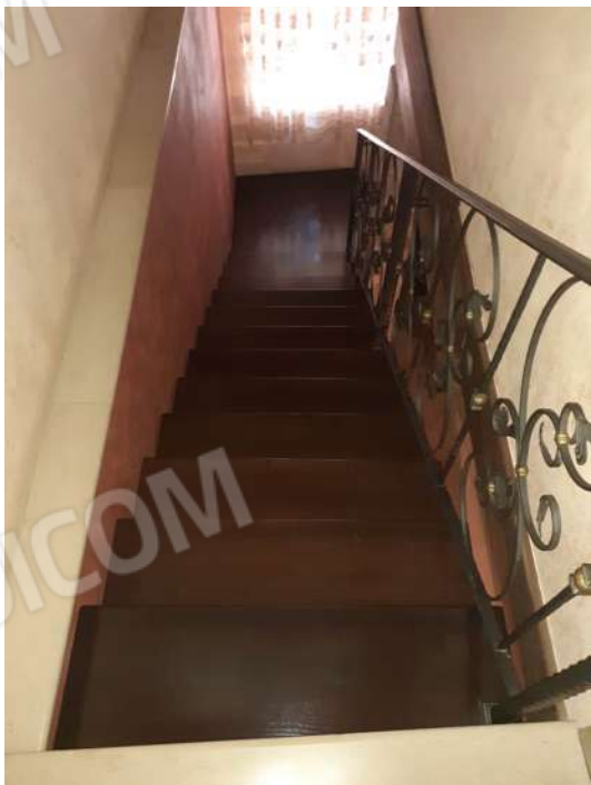
N. 13 – PIANO PRIMO: VANO SCALA
