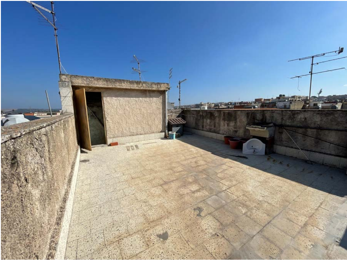
Vista del lastrico solare
