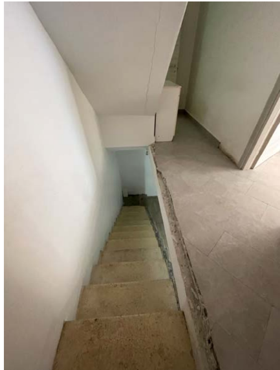
Vista del vano scala tra piano secondo e piano terzo
