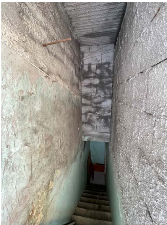
Vista del vano scala tra il piano terzo e il lastrico
