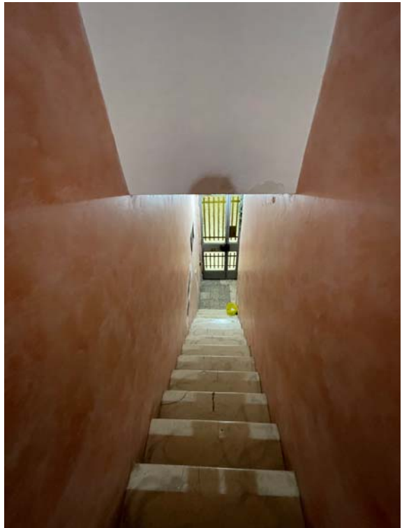
Vista del vano scala dal piano terra al piano primo
