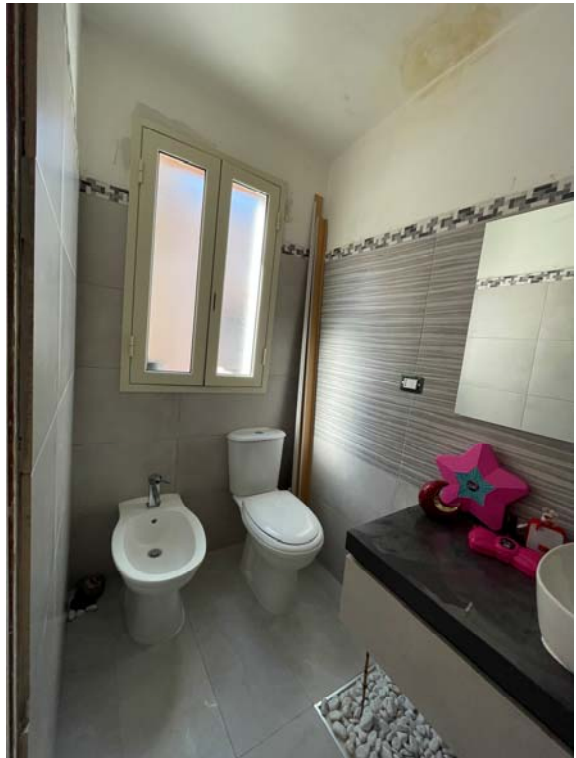
Vista del Wc al piano terzo
