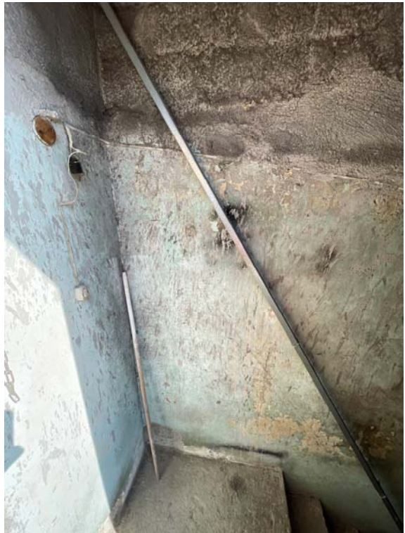
Vista del vano scala tra il piano terzo e il lastrico
