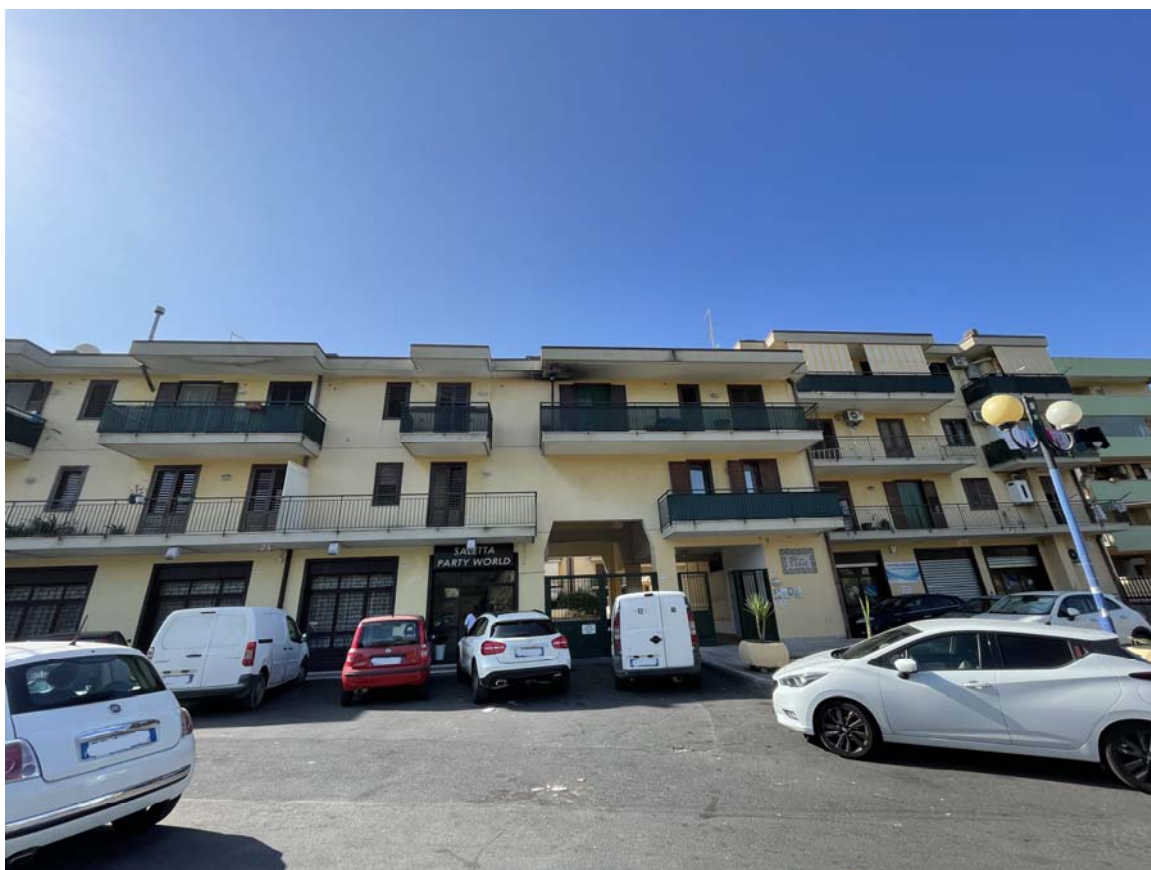
Vista esterna del complesso residenziale
