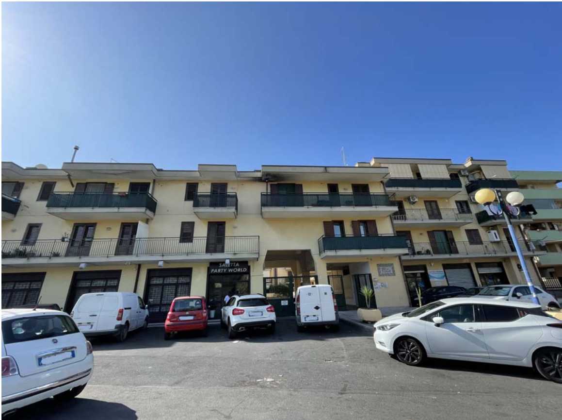
Vista esterna del complesso residenziale
