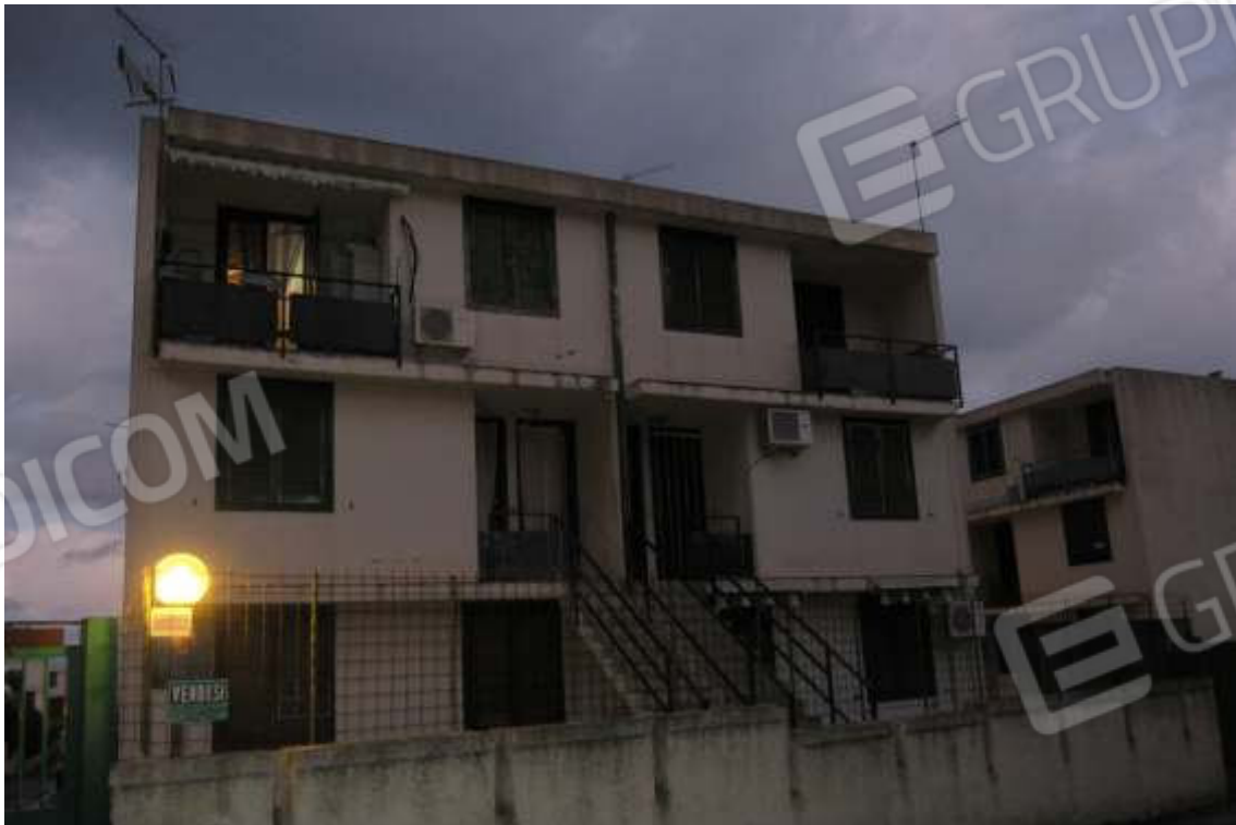
2_l'edificio al secondo piano del quale è collocato l'appartamento oggetto di pignoramento
