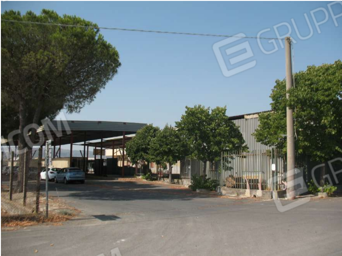
Foto 2 - Varco di accesso alla strada privata interna al lotto di terreno parte integrante del compendio oggetto di stima
