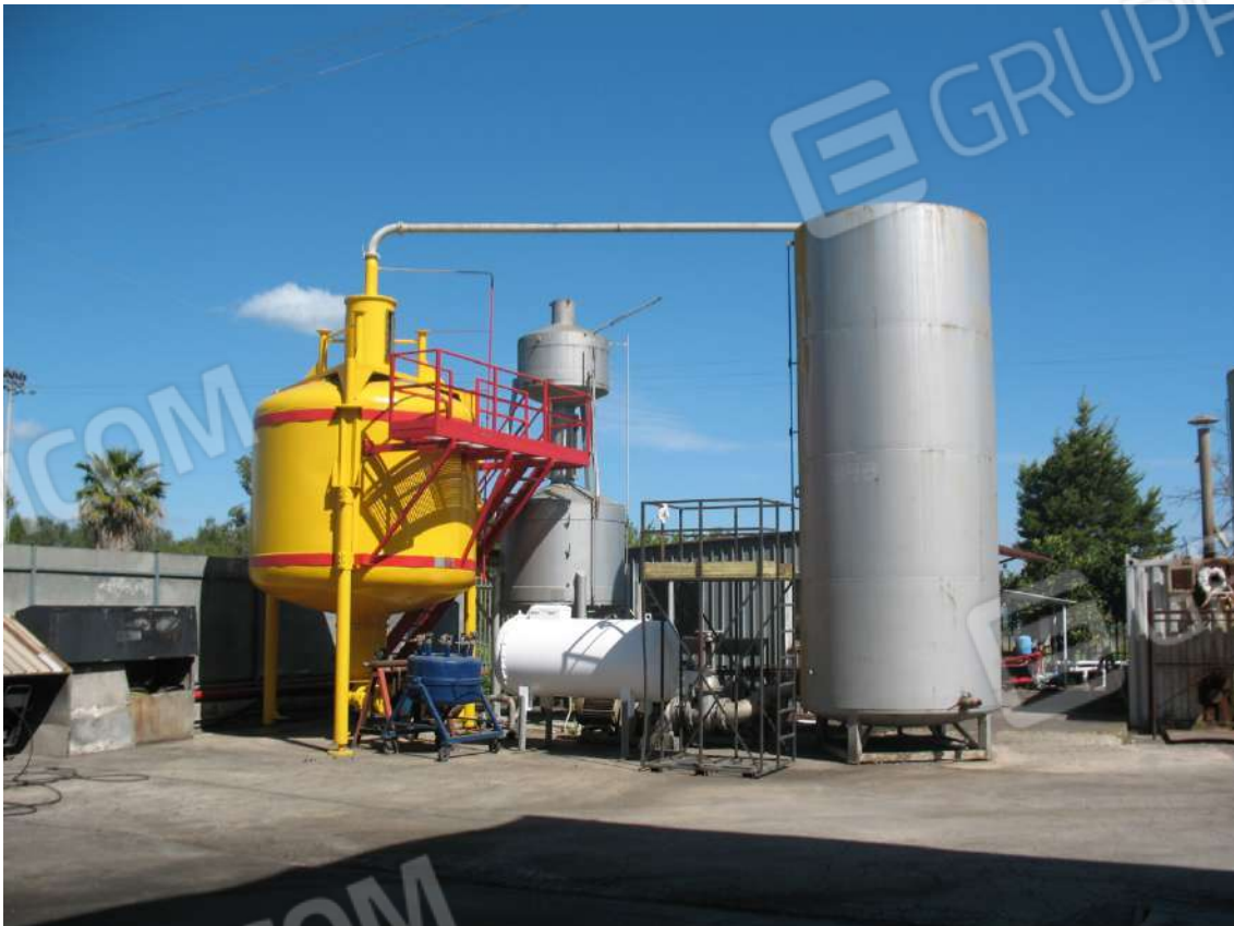
Foto 28 - Stazione metrologica (C): Serbatoi campione per la gestione metrologica
