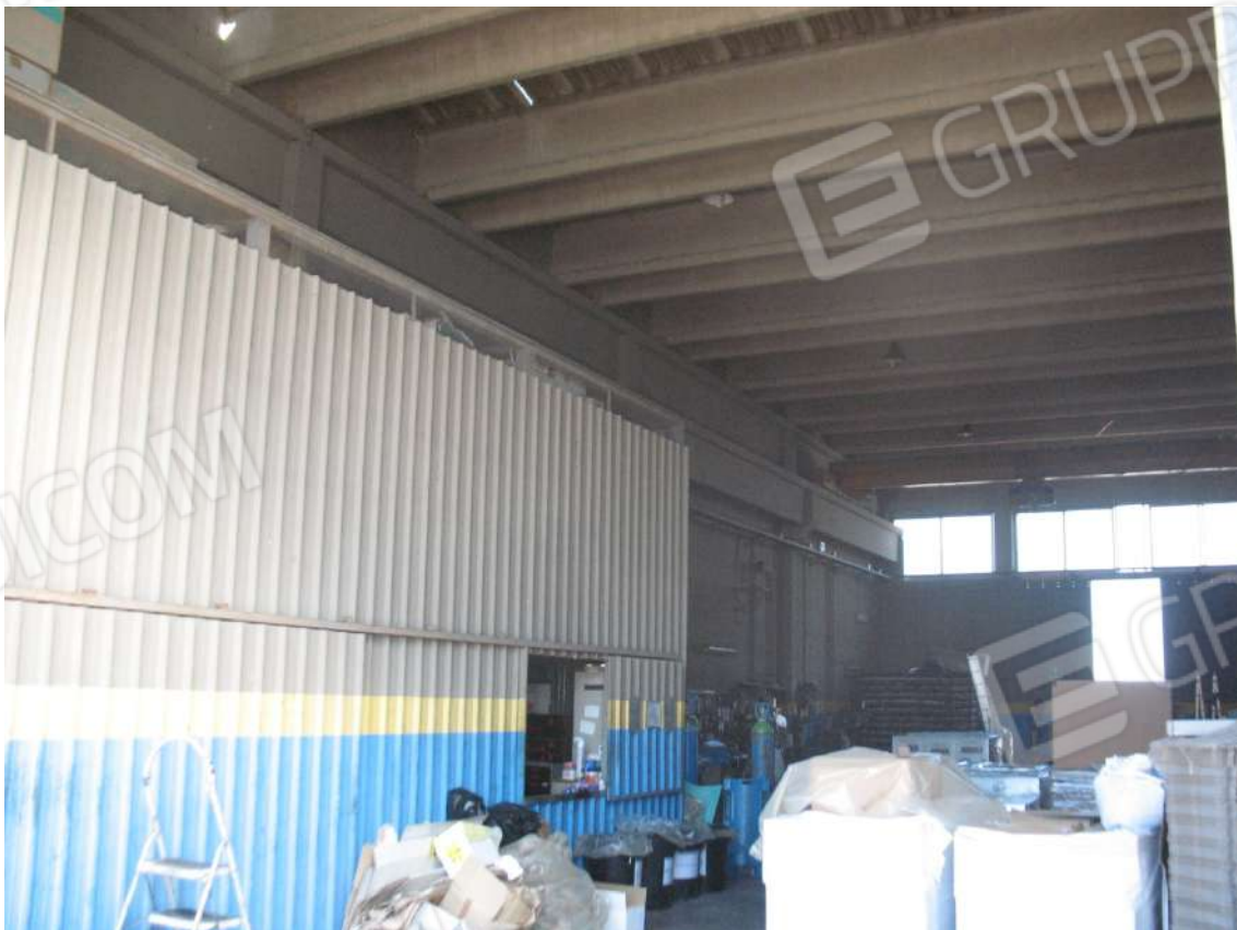
Foto 8 - Interno Capannone (A): In evidenza superfetazione A1
