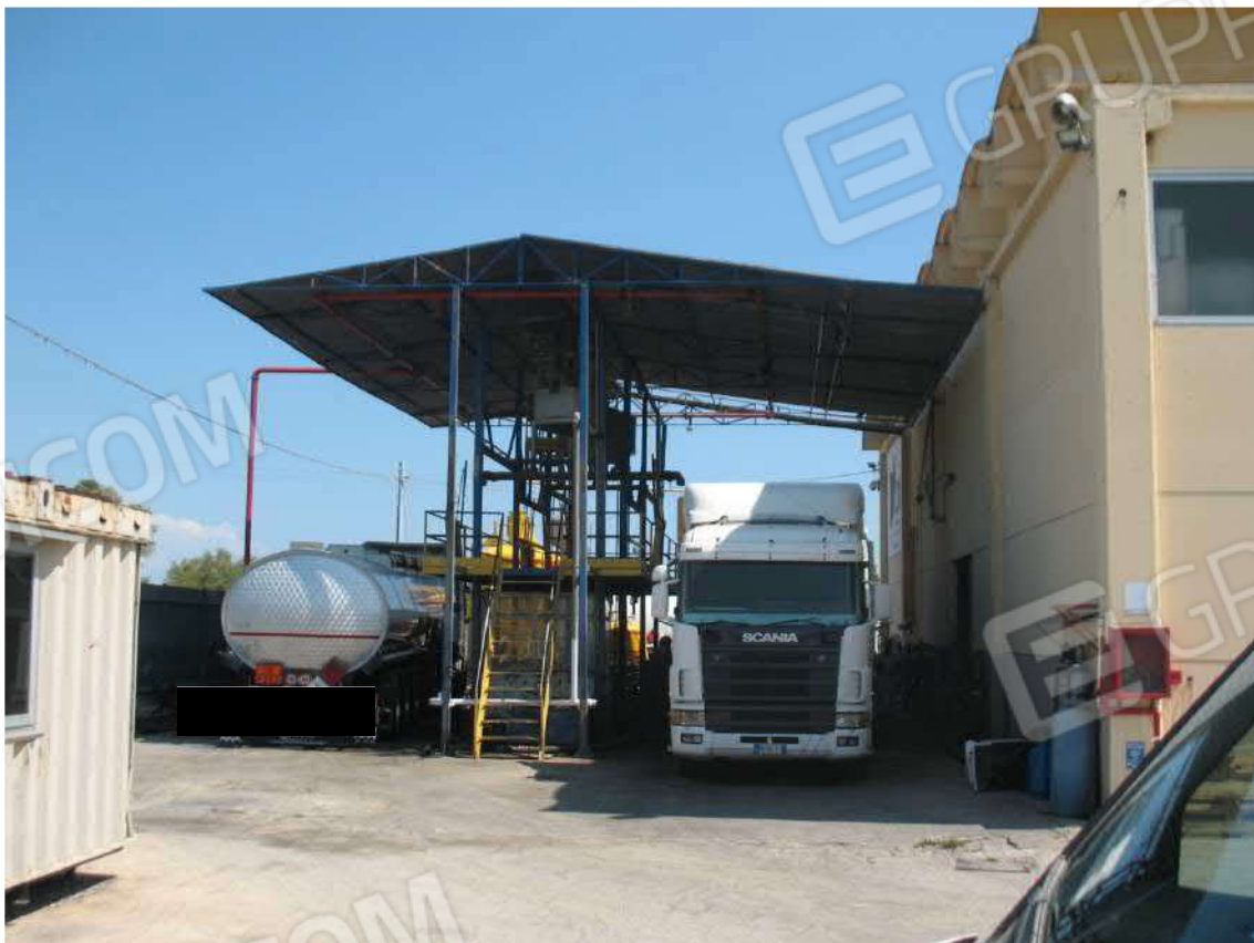
Foto 26 - Stazione metrologica (C) (Lato Sud)
