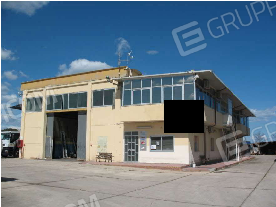
Foto 4 - Prospetto Sud: Capannone (A) + Corpo uffici e servizi (B)
