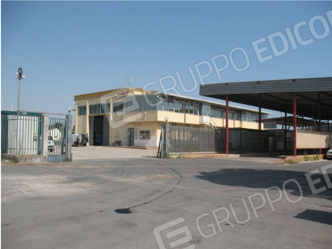
Foto 3 - Accesso carrabile e pedonale insistente sul lato Est dell'area recintata del compendio oggetto di stima
