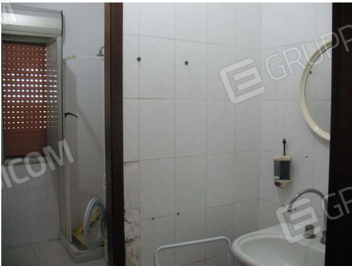
Foto 16 - Corpo uffici e servizi (B) piano terra (Sub 5): Antibagno + Bagno
