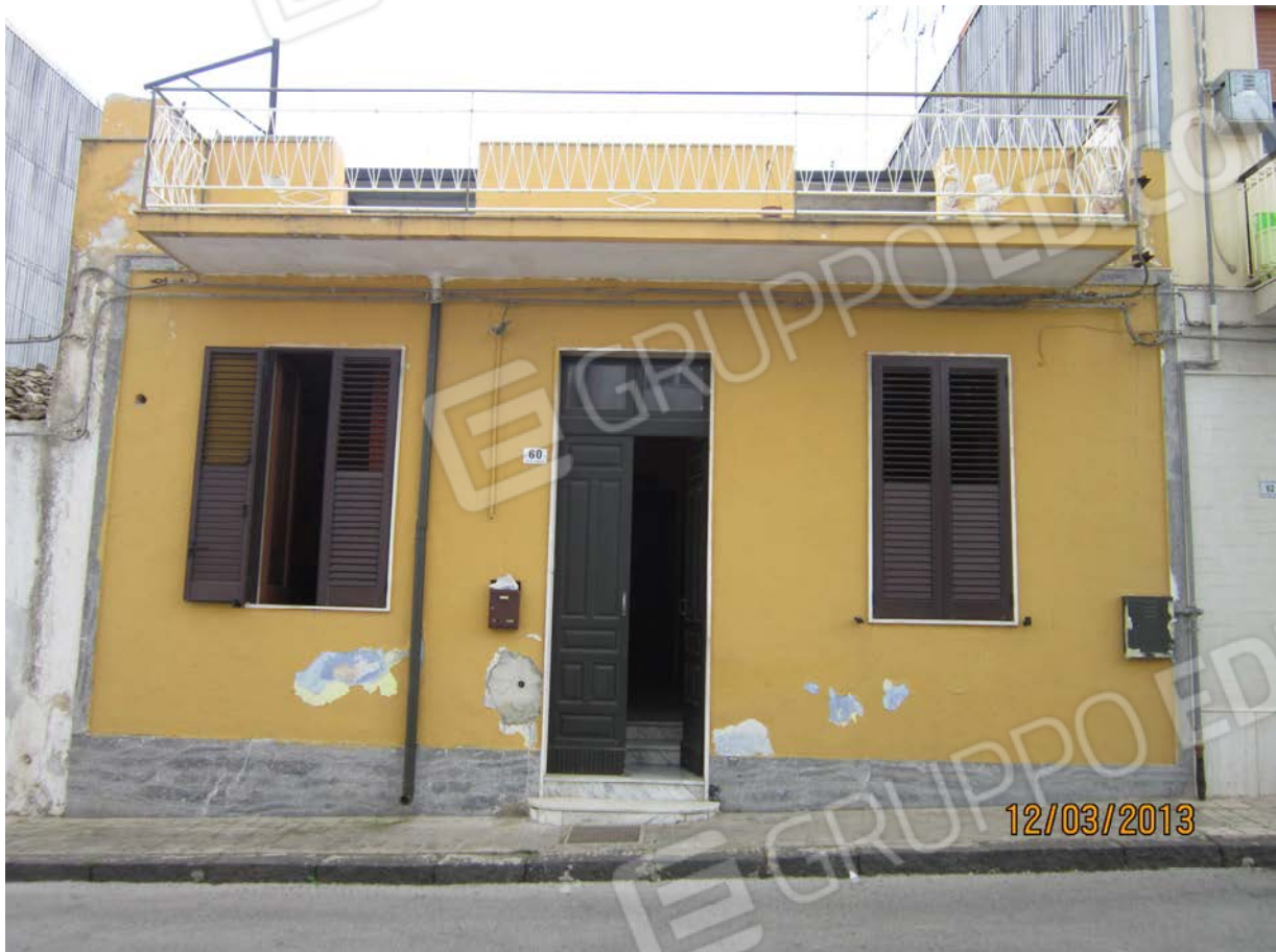
Foto n° 1 – Prospetto dell'edificio Via Principe Umberto n° 60
