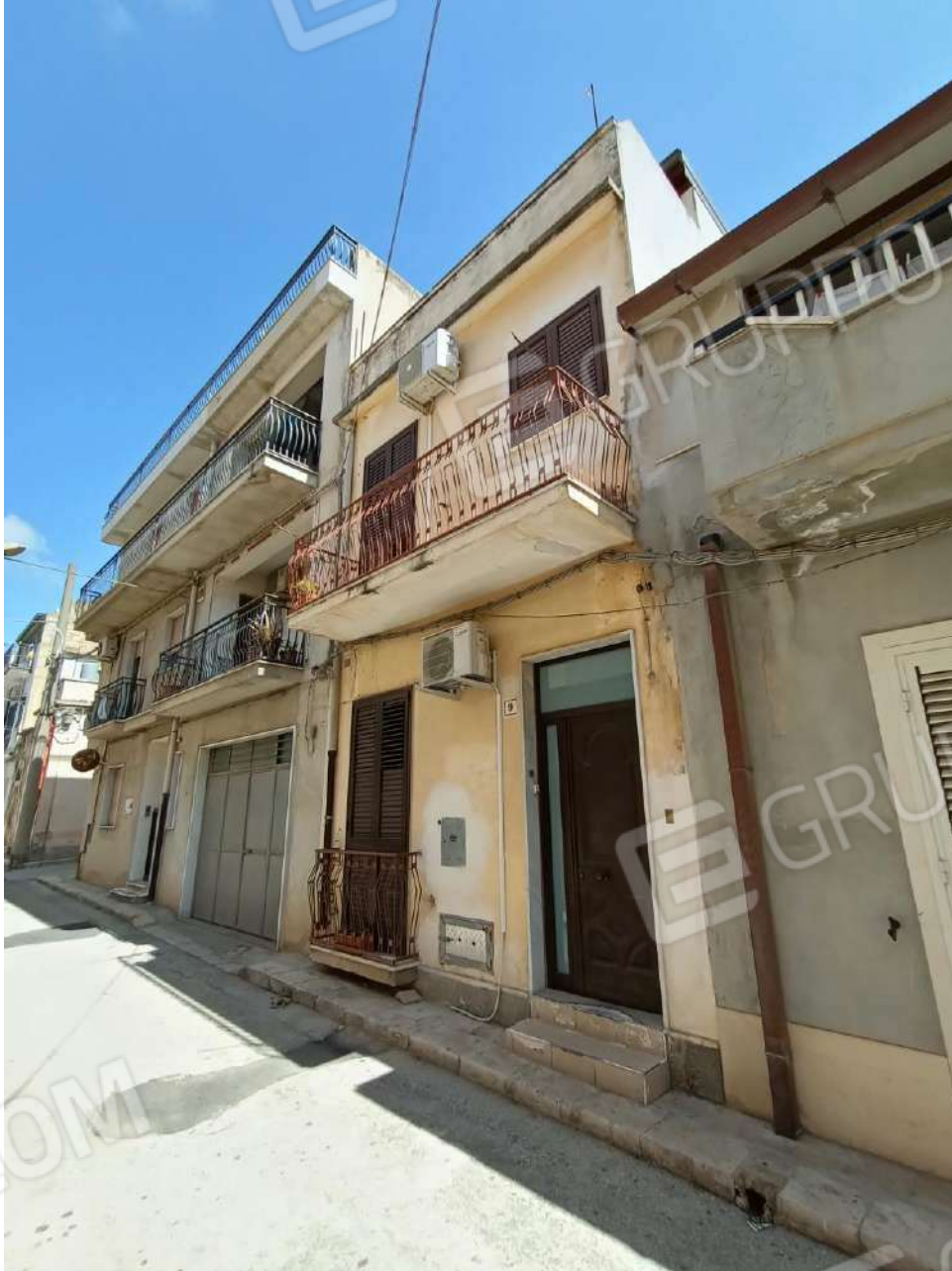
Foto 1. Vista esterna dell'edificio su via Savarino n. 9.
