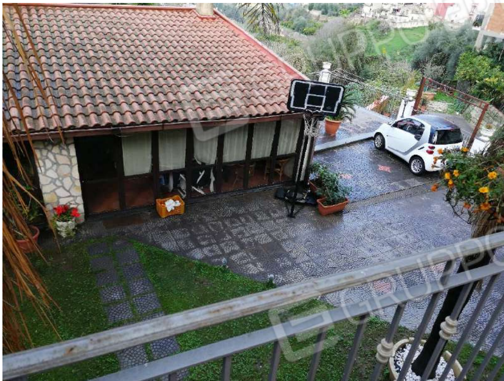
FOTO N.27 - Vista area di pertinenza piano seminterrato (p.la 326) e fabbricato abusivo sulla predetta particella
