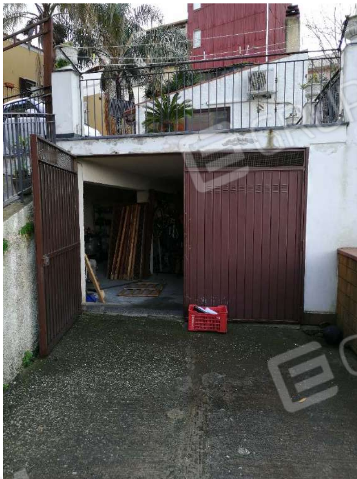
FOTO N.31 – Vista ingresso garage p.lla 326 sottostante fabbricato abusivo
