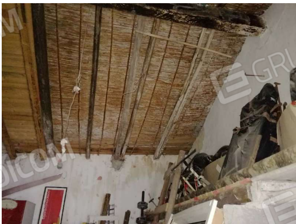
FOTO N.40 – Vista interni fabbricato p.lla 5887
