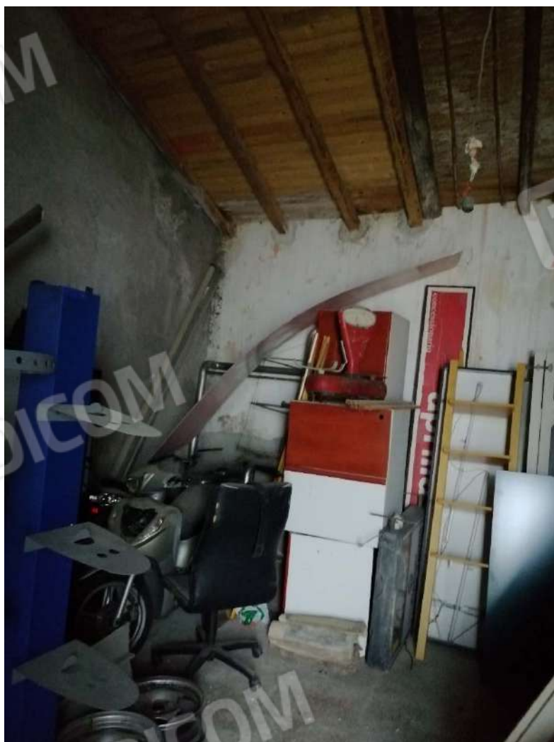
FOTO N.38 – Vista interni fabbricato p.lla 5887
