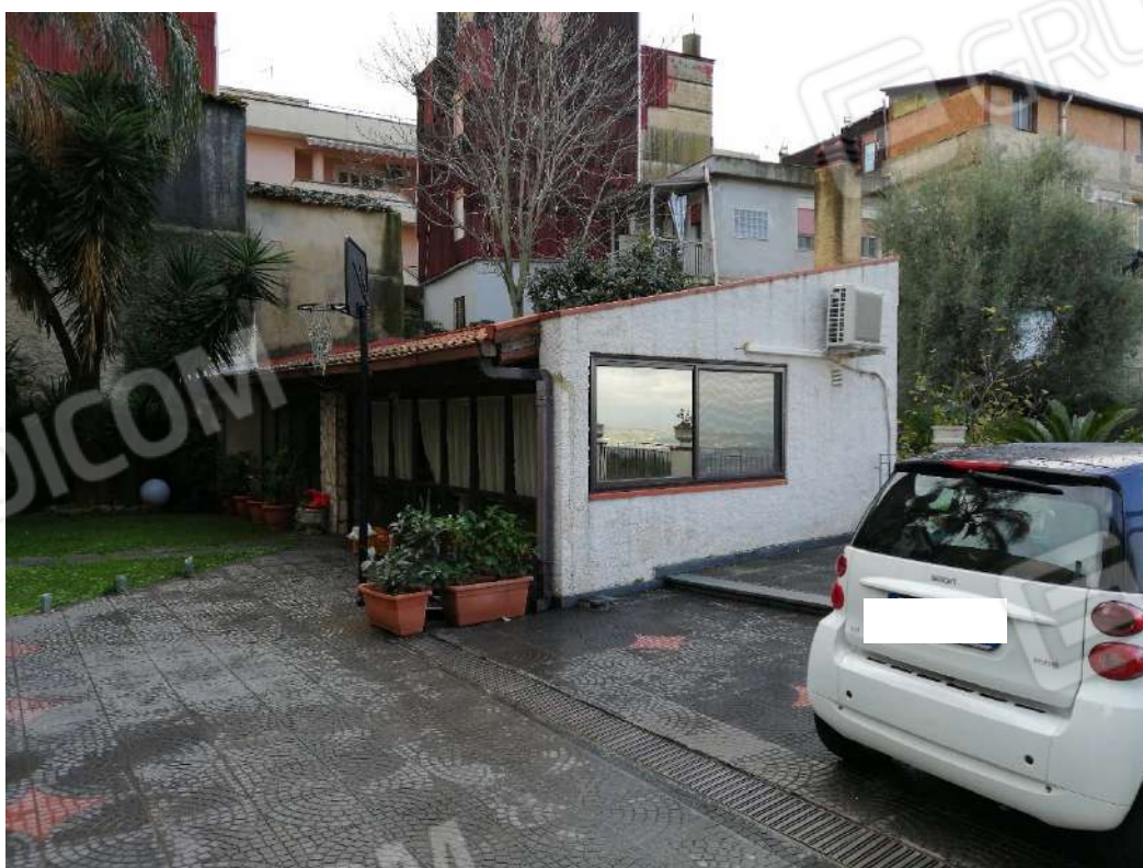
FOTO N.28 – Vista p.la 326 e fabbricato abusivo
