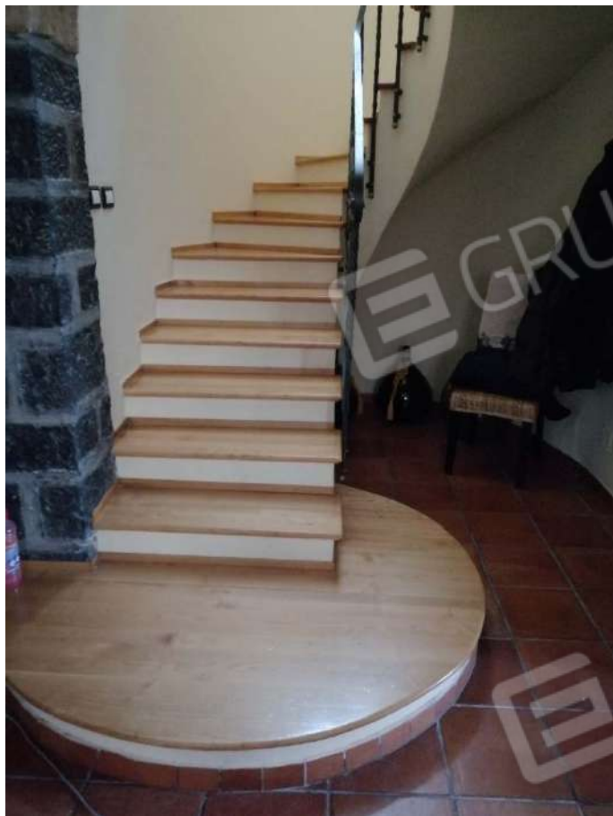
FOTO N.17 - Vista scala da piano seminterrato a piano terra
