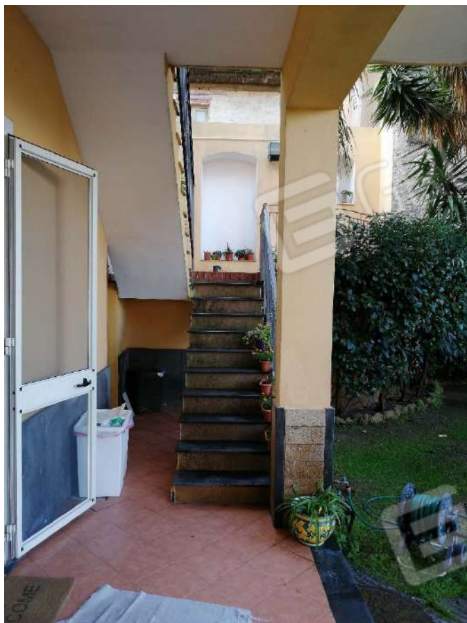
FOTO N.23 - Vista veranda coperta piano seminterrato
