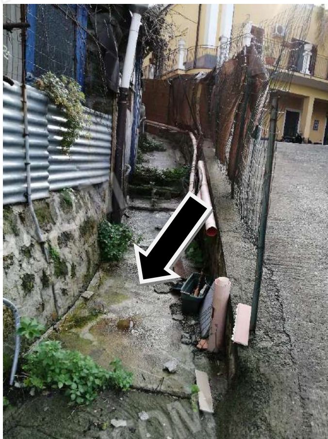
FOTO N.34 – Vista p.lla 325 dall'interno
