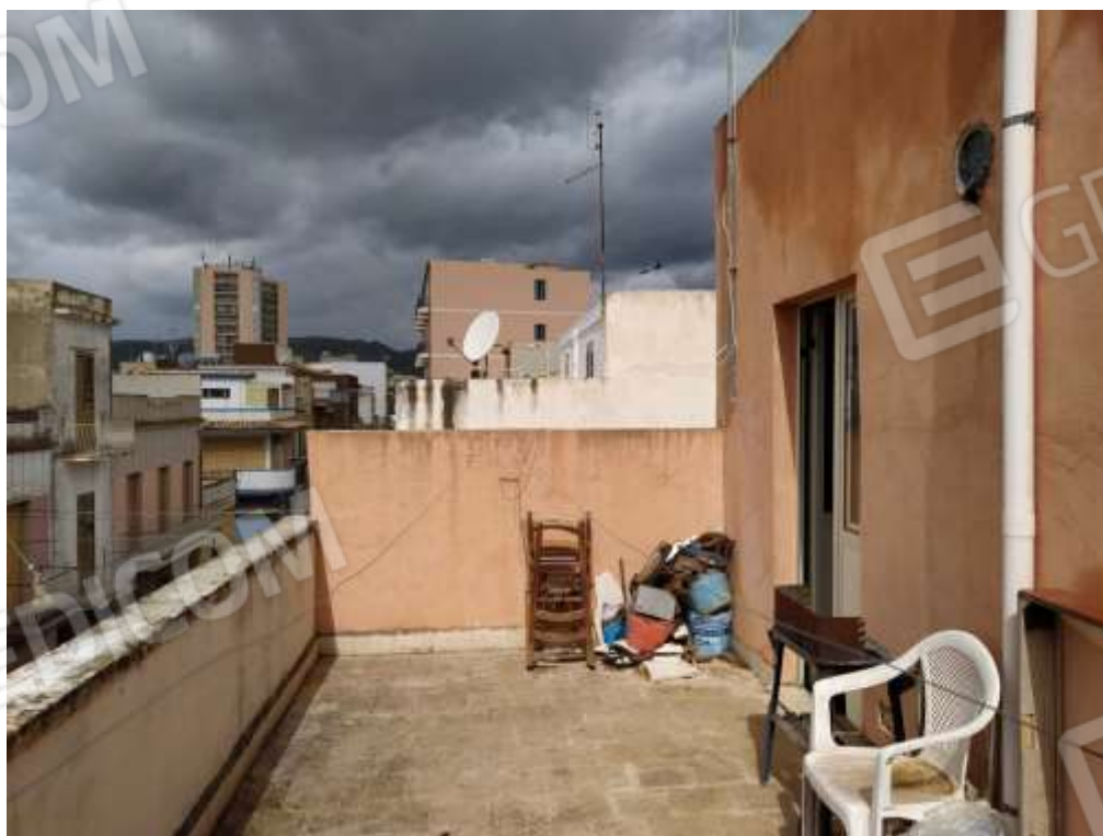
Fot. 14: terrazza esterna, piano secondo
