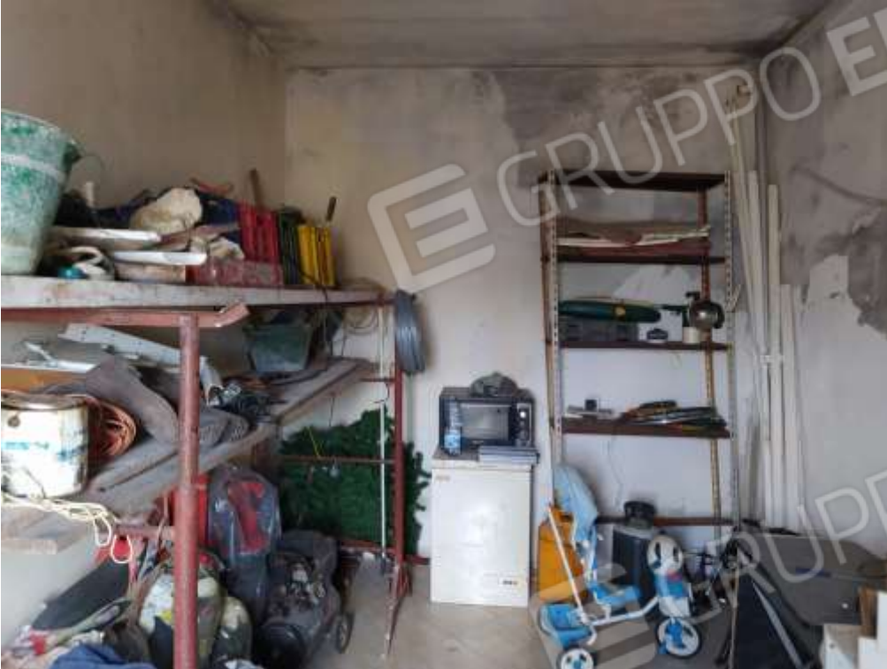
Fot. 11: vano, piano secondo
