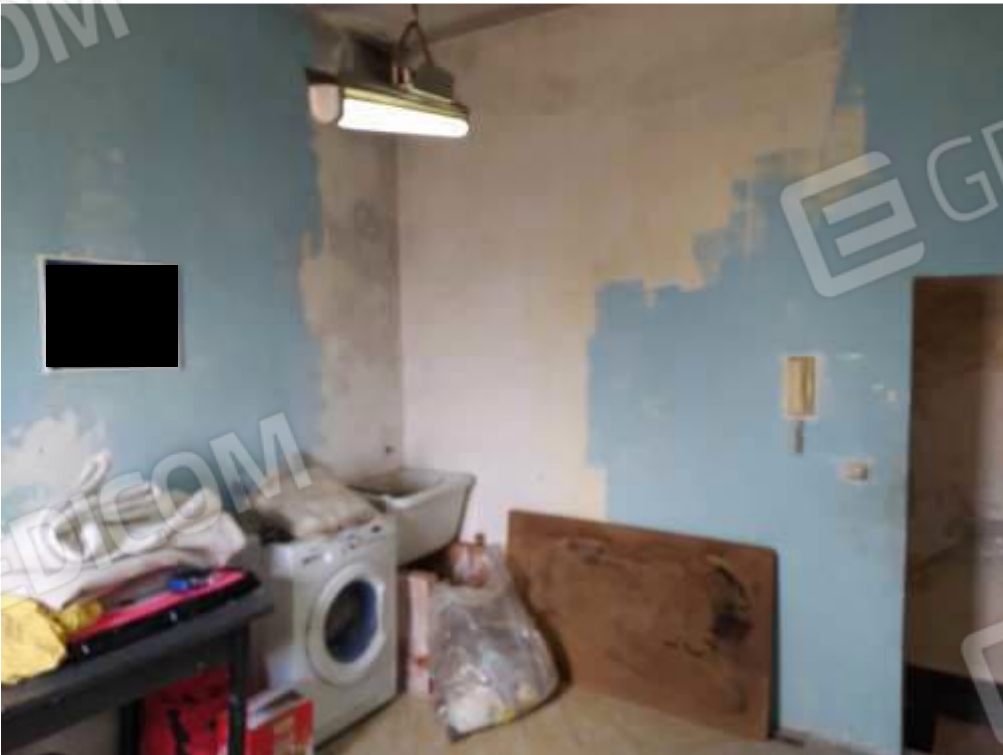
Fot. 12: vano, piano secondo
