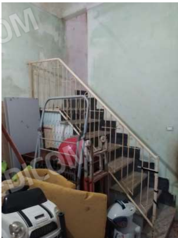
Fot. 10: rampa di scale che conduce al piano secondo
