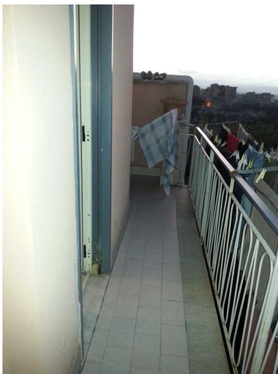
foto 10_ vista del terrazzino a livello del secondo piano
