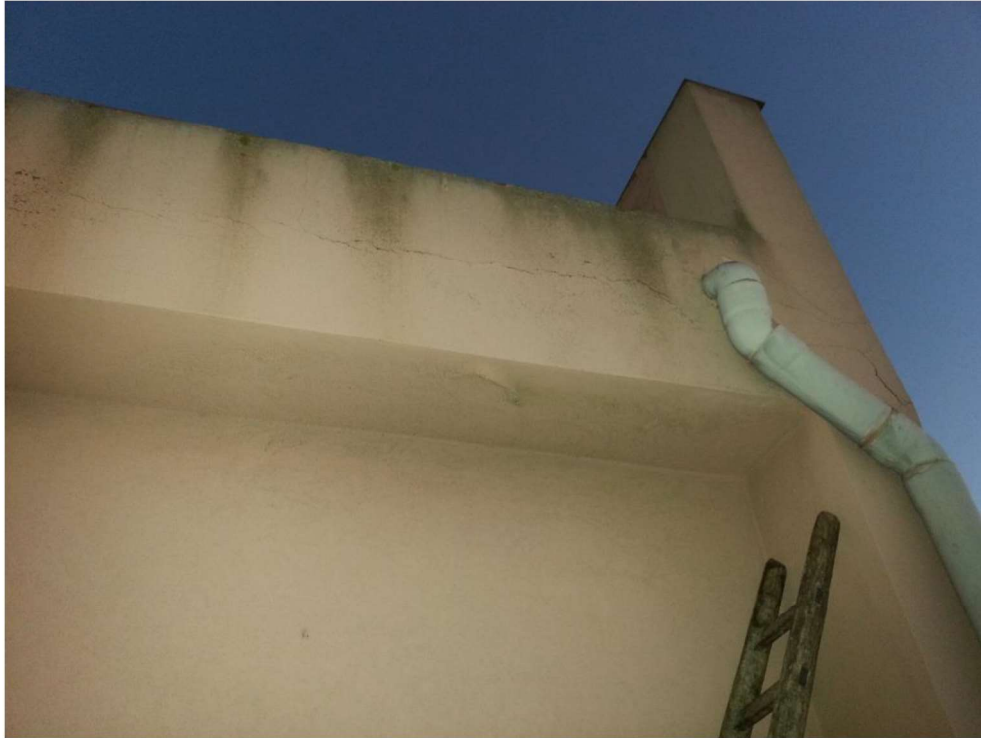
foto 11_ vista della trave esterna
