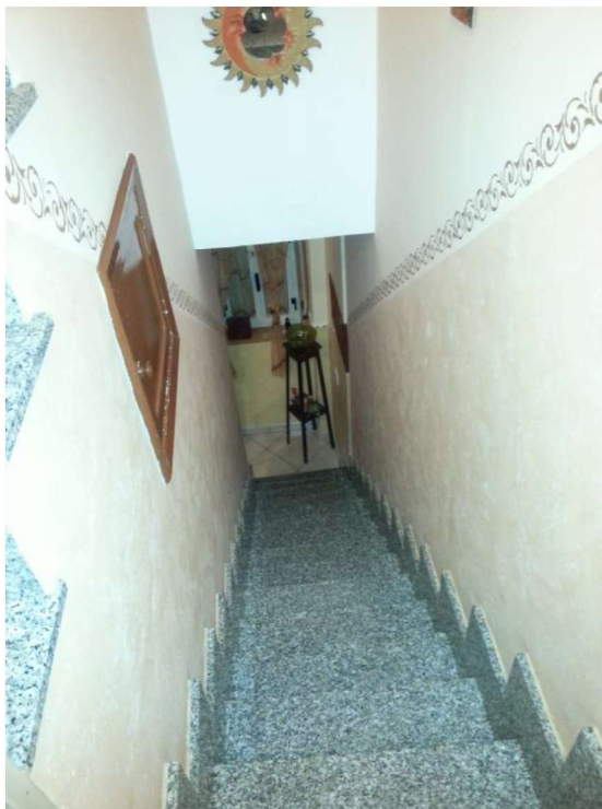
foto 5_ vista della scala interna
