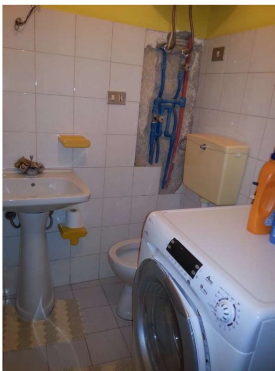
foto 9_ vista del bagno al secondo piano
