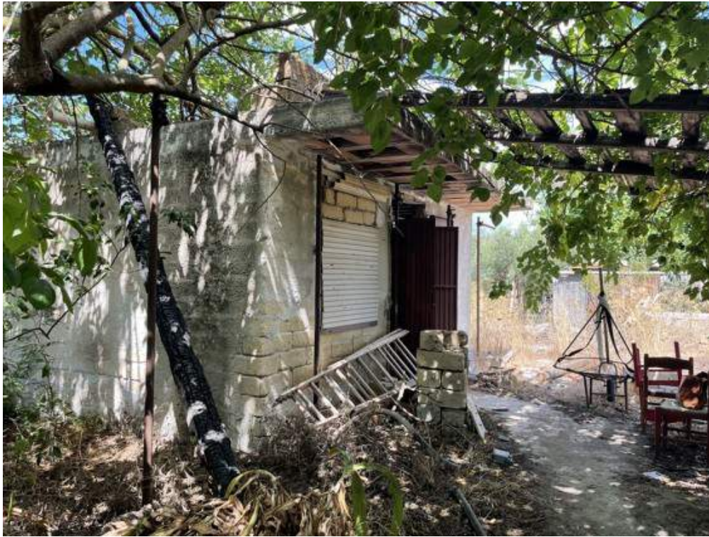
Fotografia D.63 - Magazzino: prospetto est
