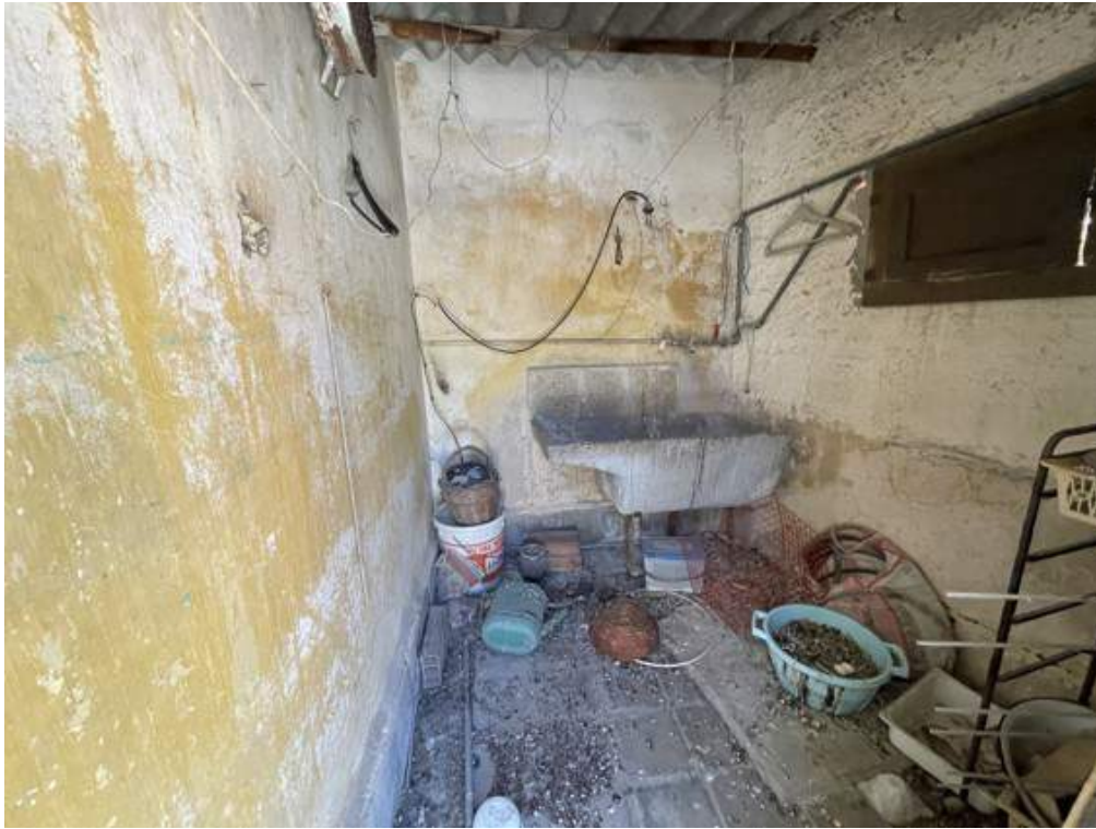
Fotografia D.25 - Piano secondo: interno del manufatto
