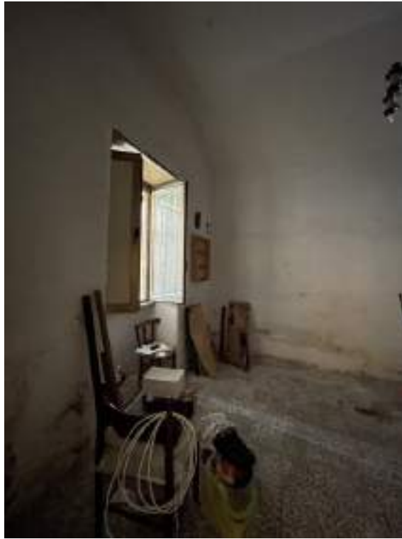
Fotografia D.5 - Piano terra: particolare della finestra
