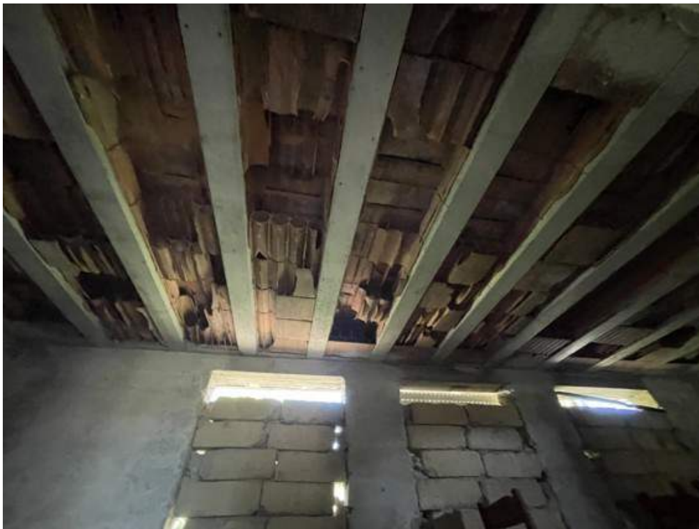
Fotografia D.46 - Magazzino: entrata
