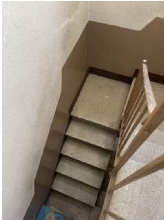
Fotografia D.37 - Scala che collega il piano primo con il piano secondo
