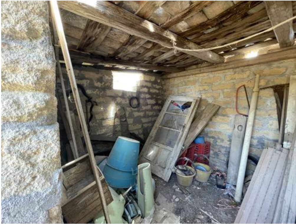
Fotografia D.57 - Copertura
