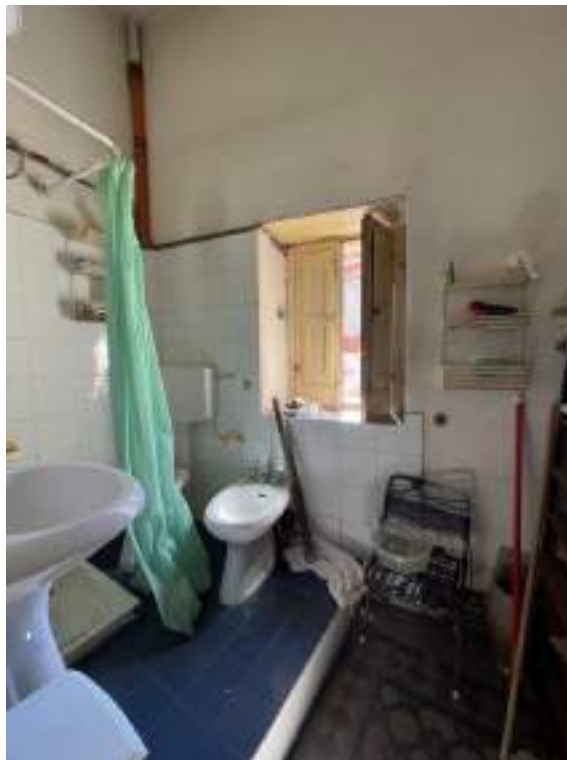
Fotografia D.20 - Piano primo: bagno
