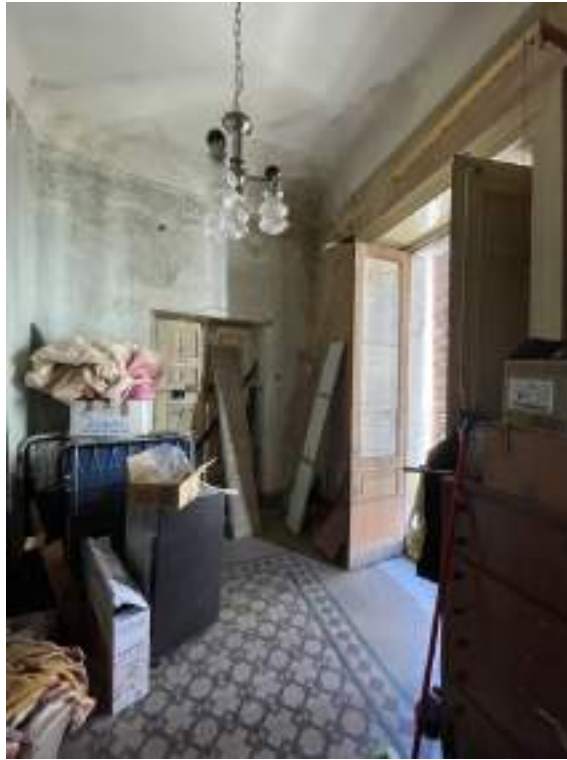
Fotografia D.17 - Piano primo: porta che da sulla scalinata esterna-lato via E. Marchiafava
