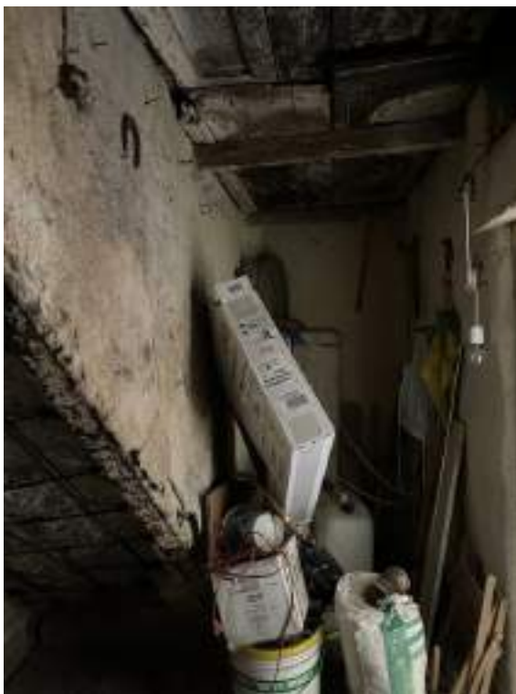
Fotografia D.8 - Scala e locale sotto-scala
