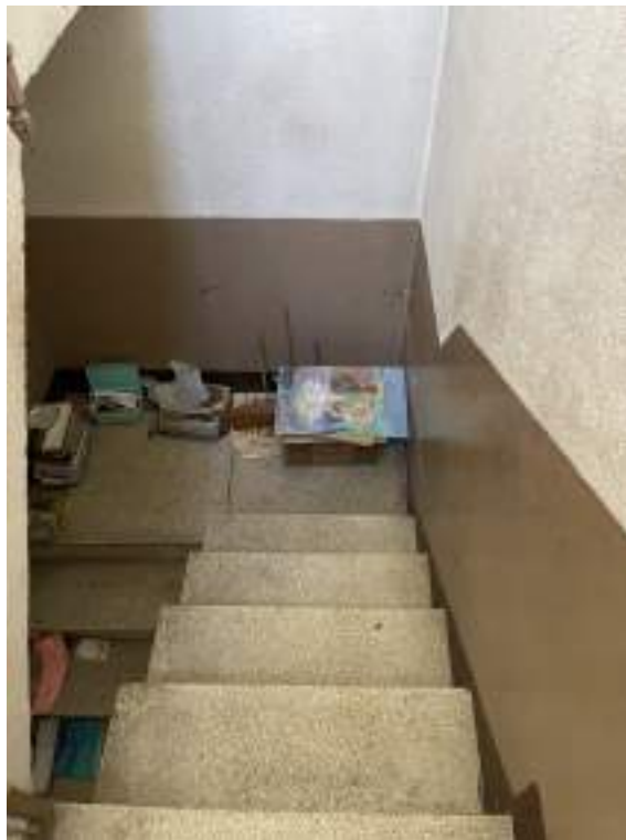
Fotografia D.38 - Scala che collega il piano primo con il piano secondo
