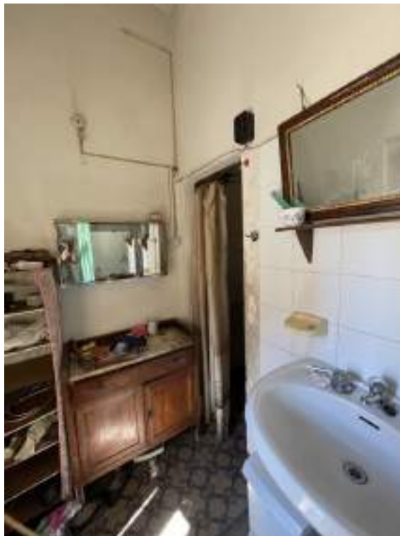
Fotografia D.18 - Piano primo: bagno
