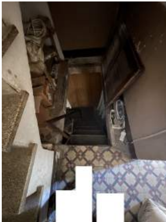
Fotografia D.22 - Scala che porta al piano terra e che attraversa il soppalco
