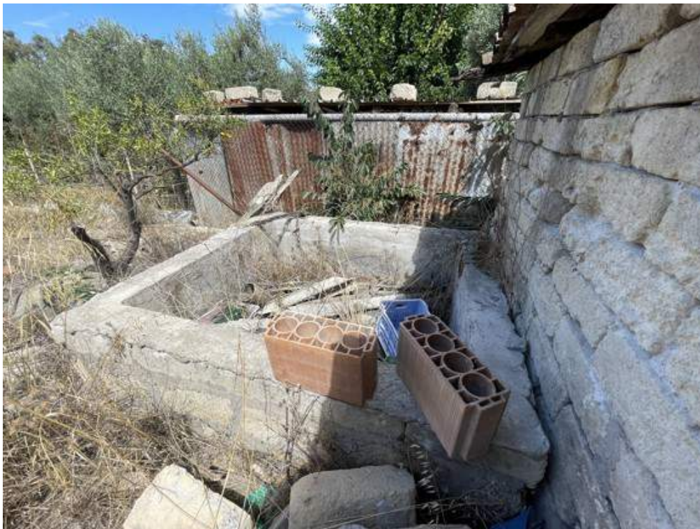
Fotografia D.54 - Vasca e confine nord
