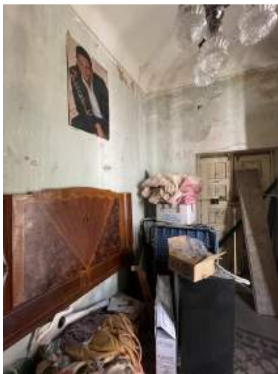
Fotografia D.15 - Piano primo: lato ovest
