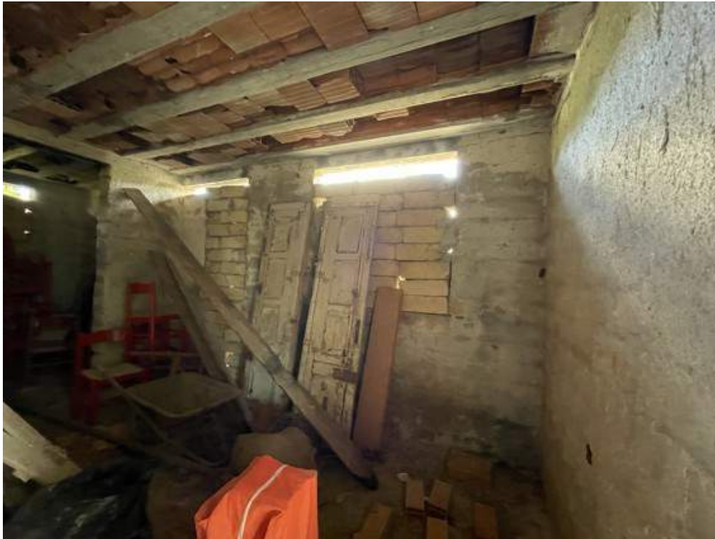
Fotografia D.49 - Magazzino: interno
