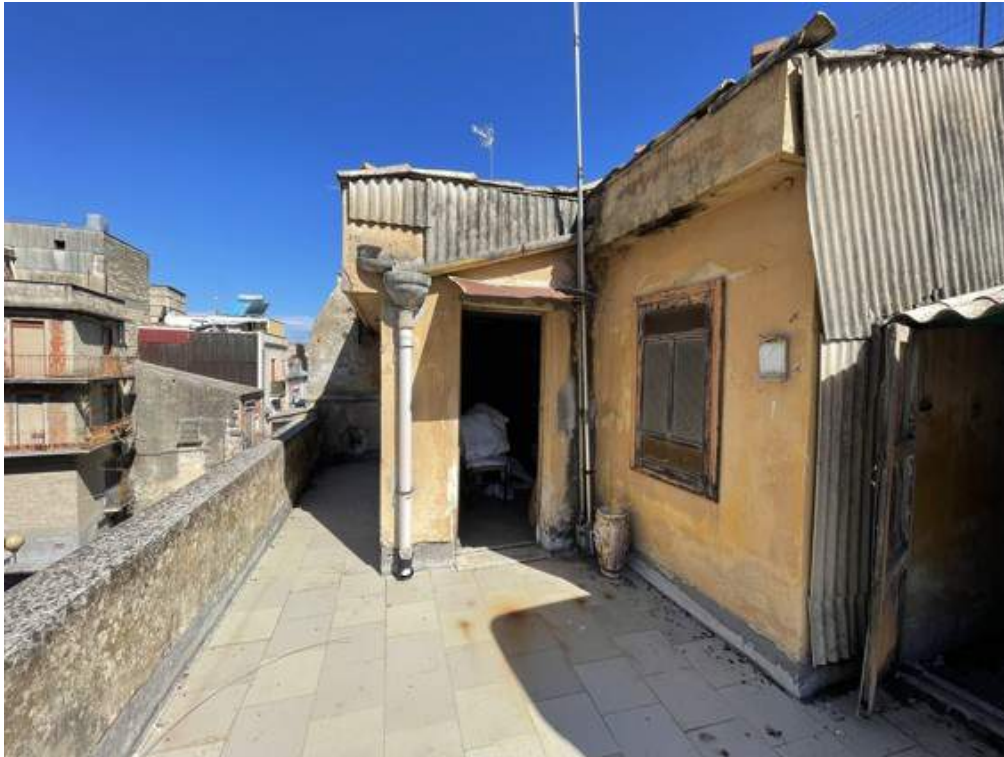
Fotografia D.27 - Piano secondo: locale e vano scala
