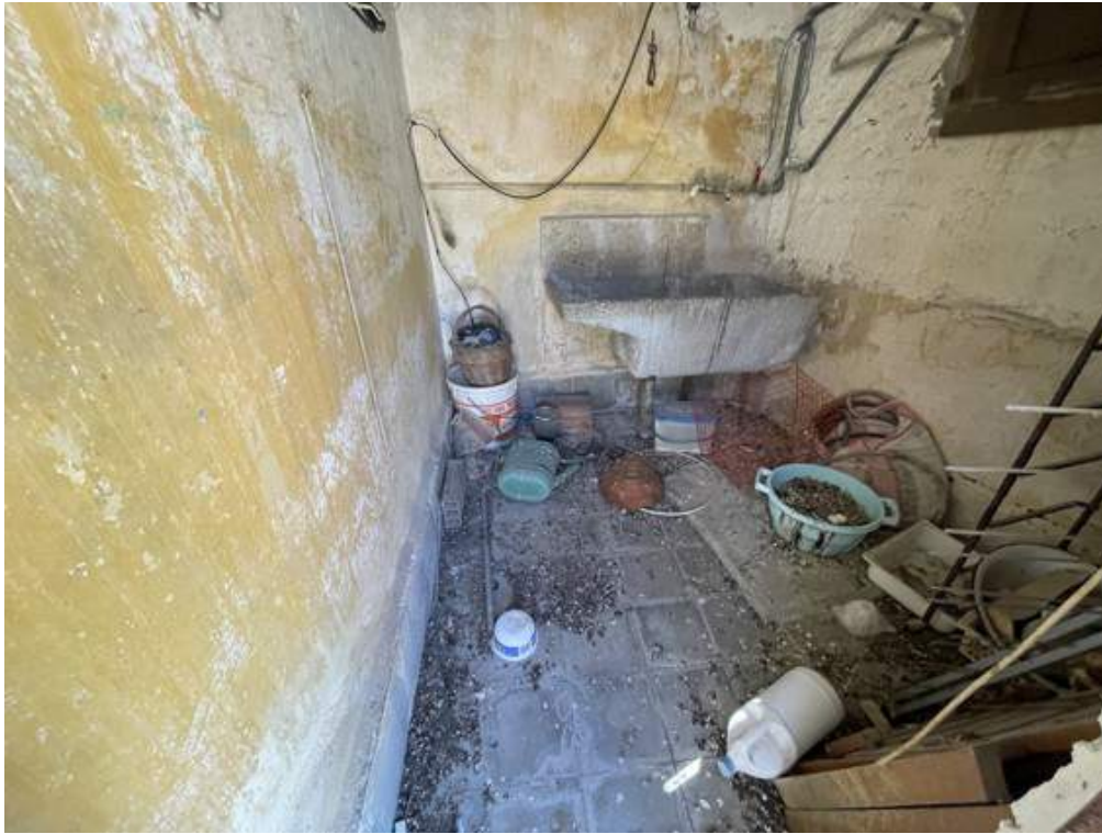
Fotografia D.29 - Piano secondo: interni del manufatto
