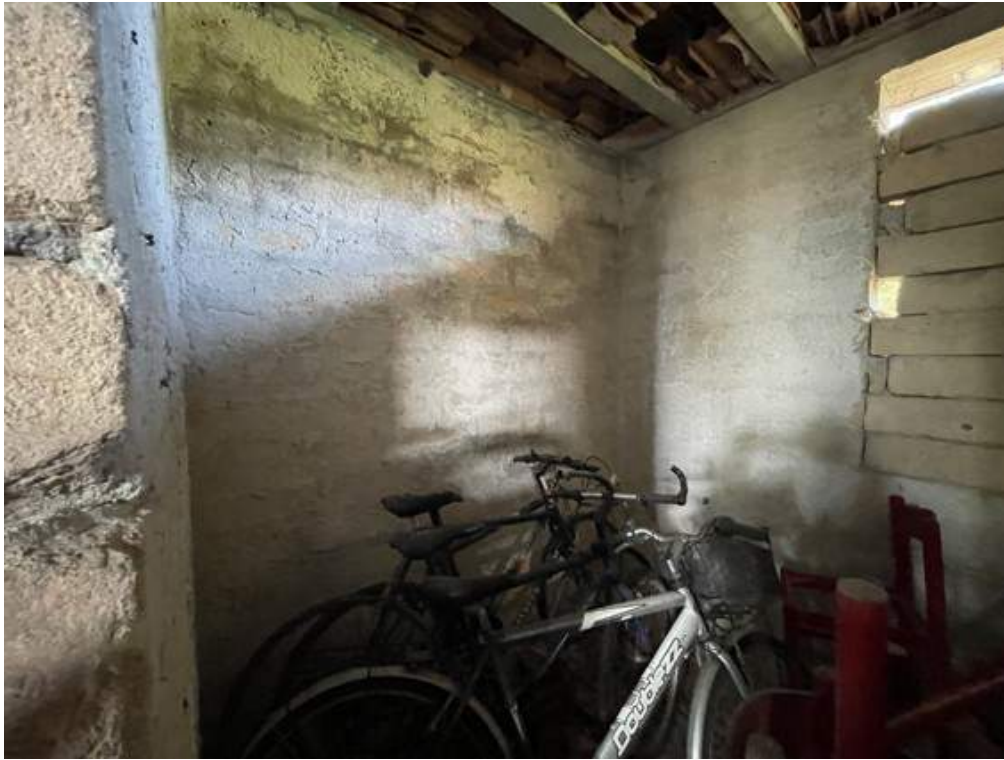
Fotografia D.45 - Magazzino: Interno
