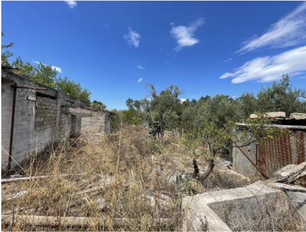
Fotografia D.53 - Esterno: lato nord del magazzino
