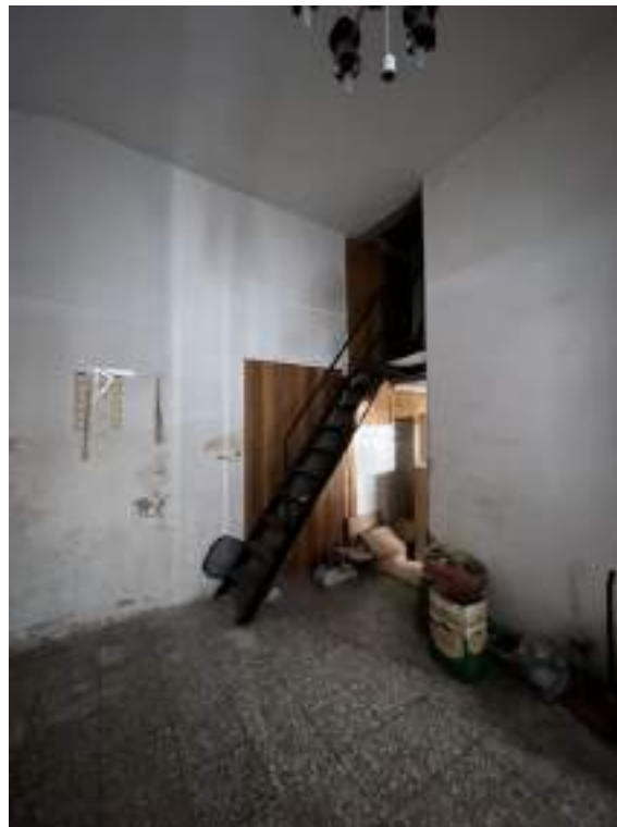
Fotografia D.2 - Piano terra: scala interna che portano al piano primo
