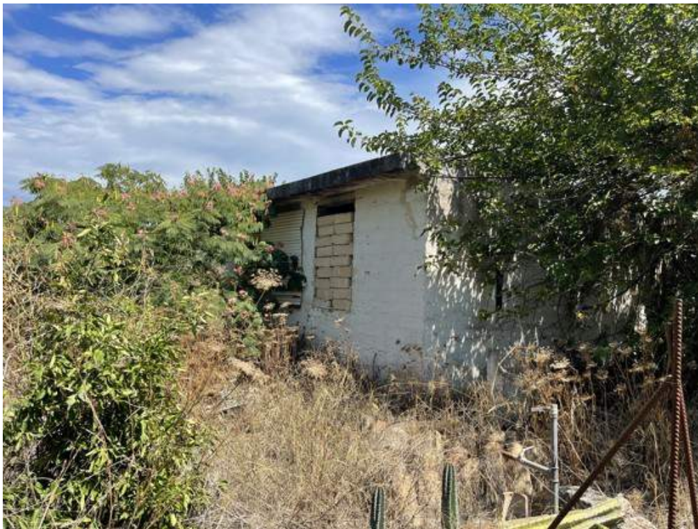
Fotografia D.66 - Magazzino: prospetto sud
