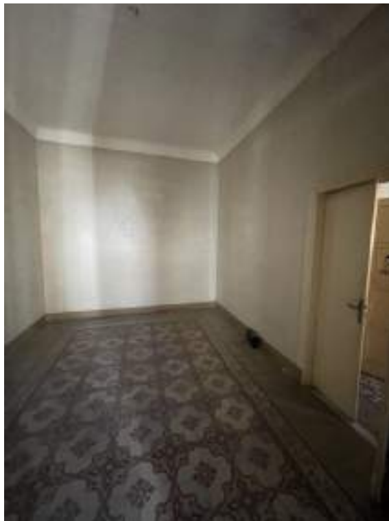
Fotografia D.12 - Satnza piano primo
