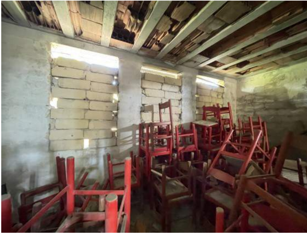
Fotografia D.43 - Magazzino: particolare del soffitto in latero-cemento
