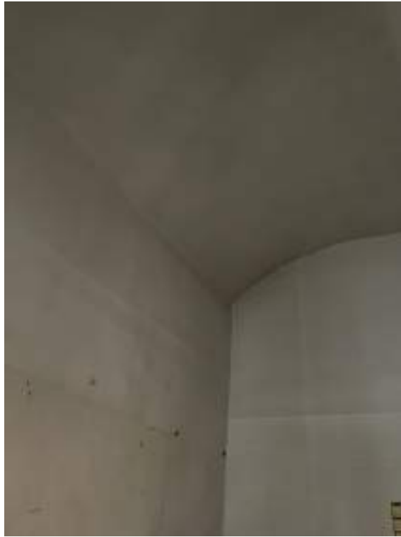
Fotografia D.9 - Piano primo lato ovest
