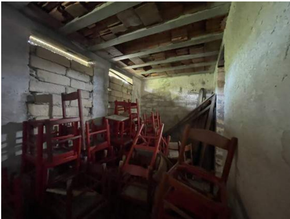
Fotografia D.48 - Interno: locale ovest del magazzino diviso da muro con apertura
