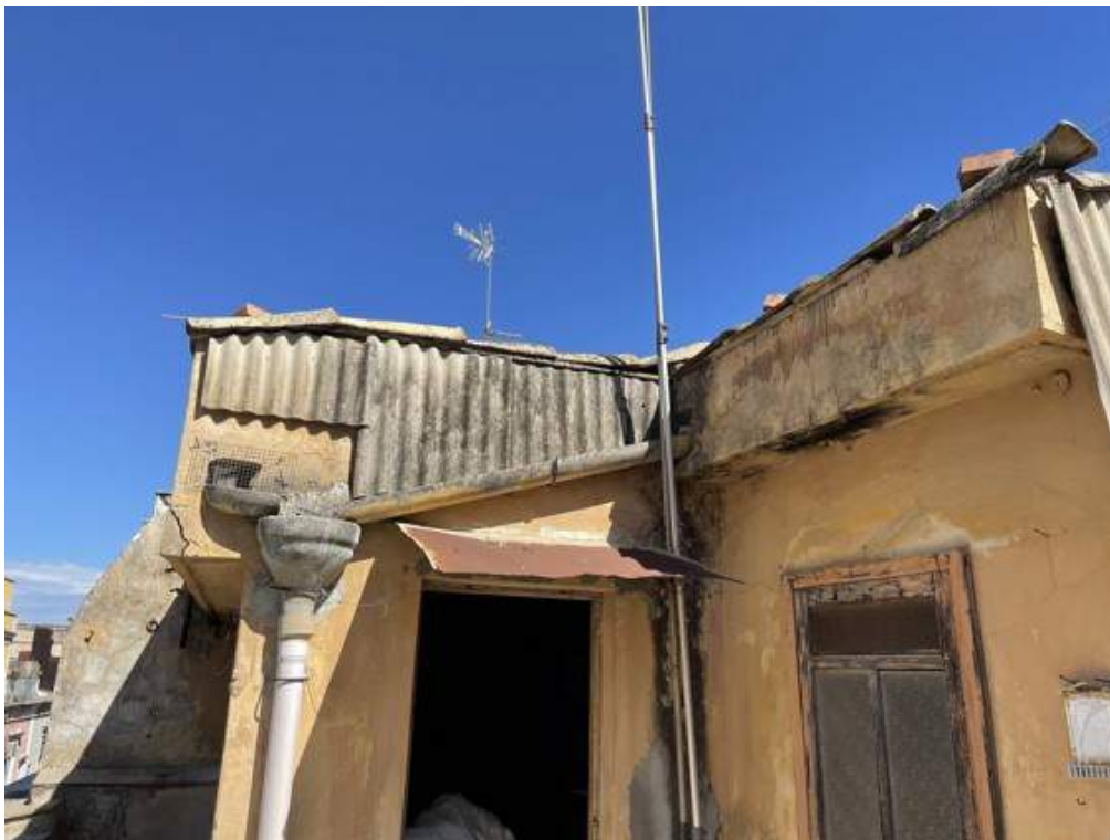
Fotografia D.26 - Copertura
