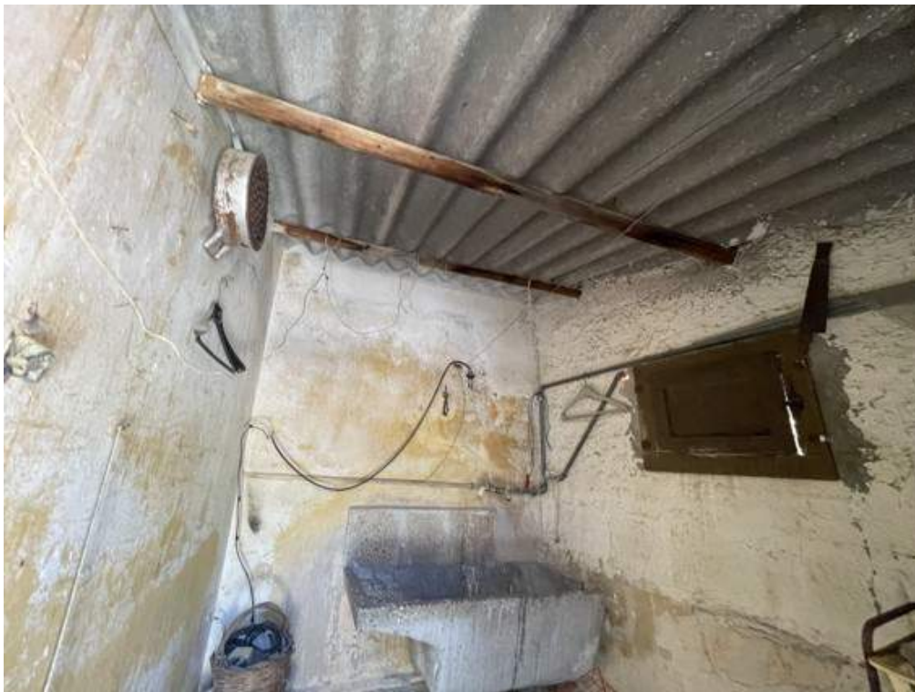
Fotografia D.30 - Piano secondo: interni del manufatto
