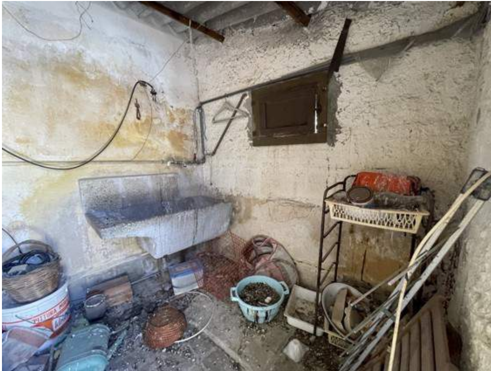
Fotografia D.31 - Piano secondo: interni del manufatto
