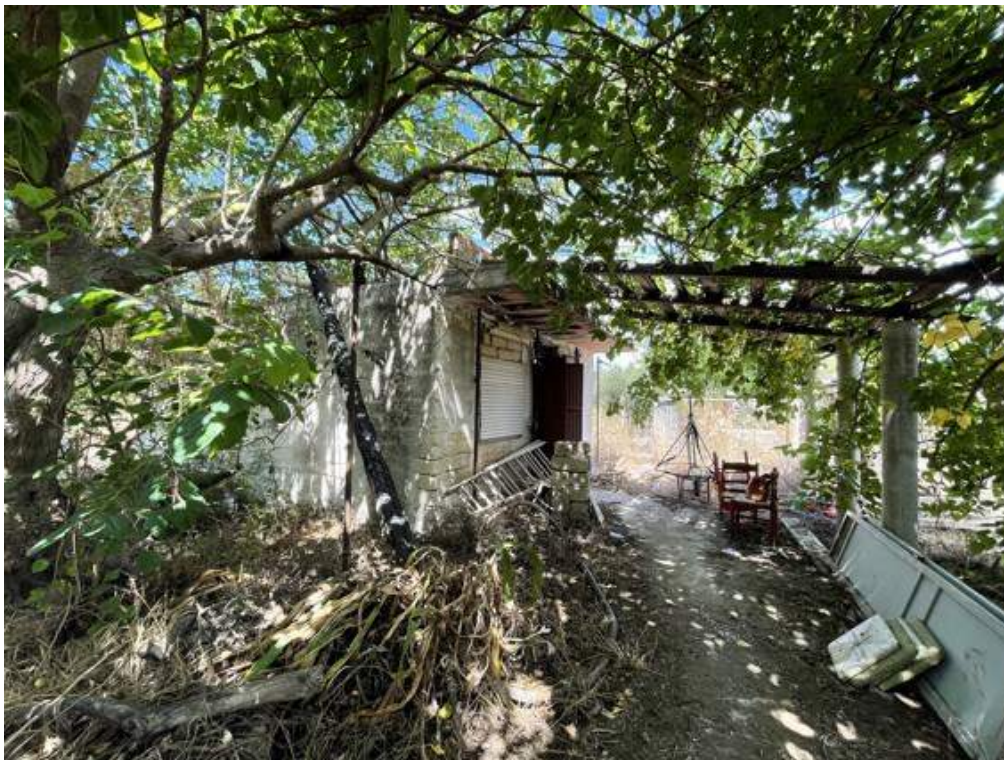
Fotografia D.64 - Magazzino: prospetto est
