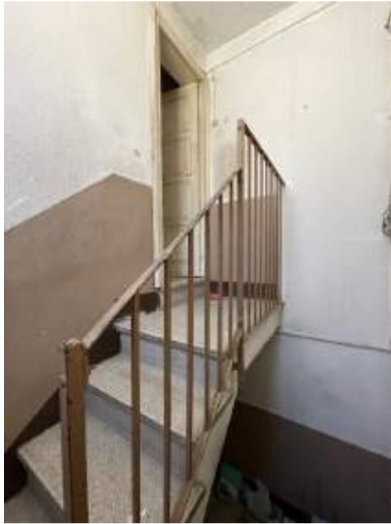
Fotografia D.39 - Scala che porta all'ingresso del locale al piano secondo
