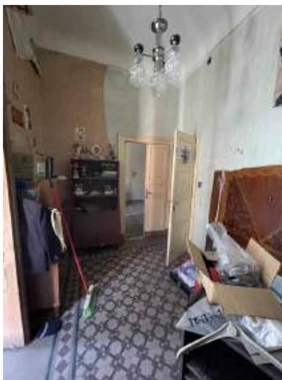
Fotografia D.16 - Piano primo: lato ovest-porta che da sulle scale e sul bagno retrostante
