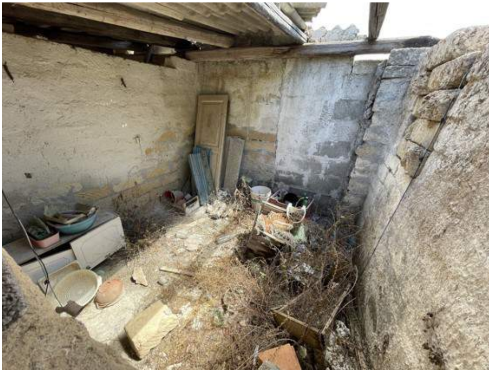
Fotografia D.58 - Manufatto: Interno pareti e copertura
