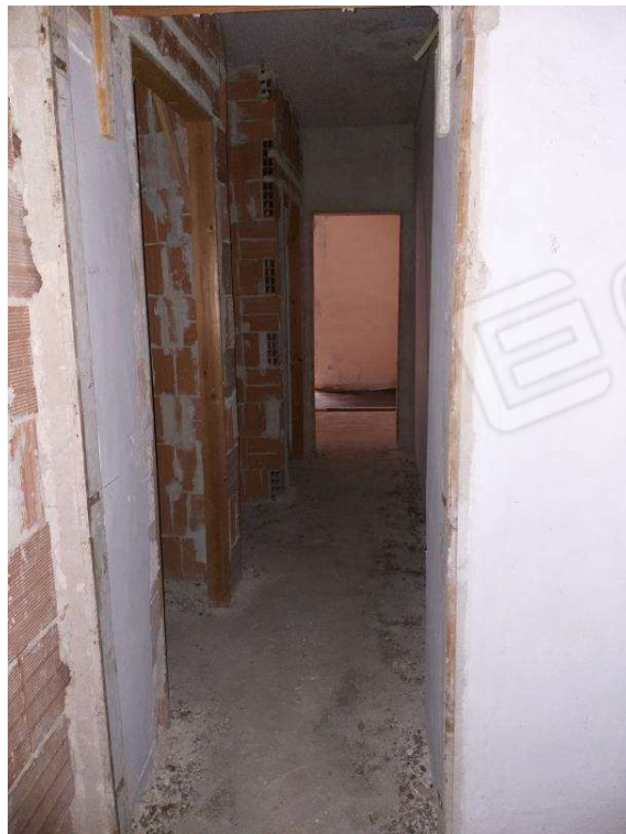
Foto 6_U.I. in ristrutturazione
