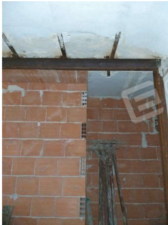
Foto 12_ particolare della trave IPE
