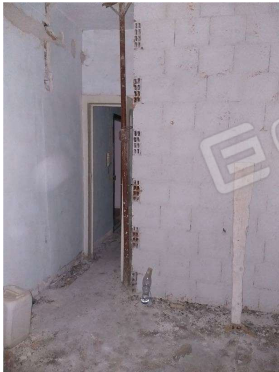
Foto 8_U.I. in ristrutturazione
