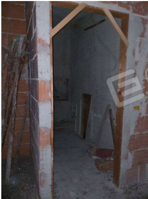
Foto 10_ U.I. in ristrutturazione
