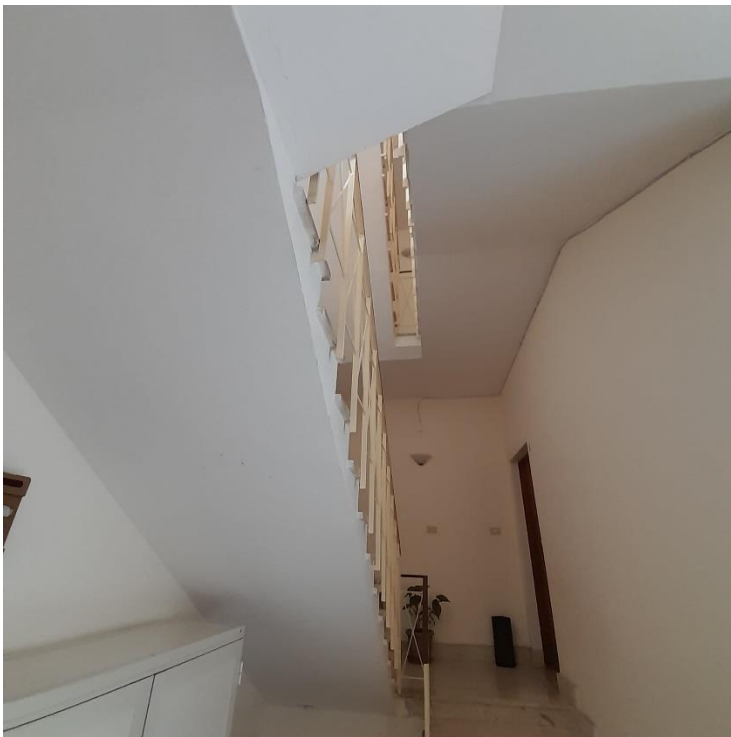
Vista ingresso al vano scala
