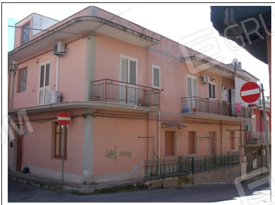
02. Vista prospettica delle unità immobiliari (sub. 2 al primo piano e sub. 3 al piano terrazza), esposizione a nord-ovest, con accesso attraverso marciapiede su strada urbana. Posizione ad angolo tra via Vittorio Alfieri e via Giovanni Boccaccio.
