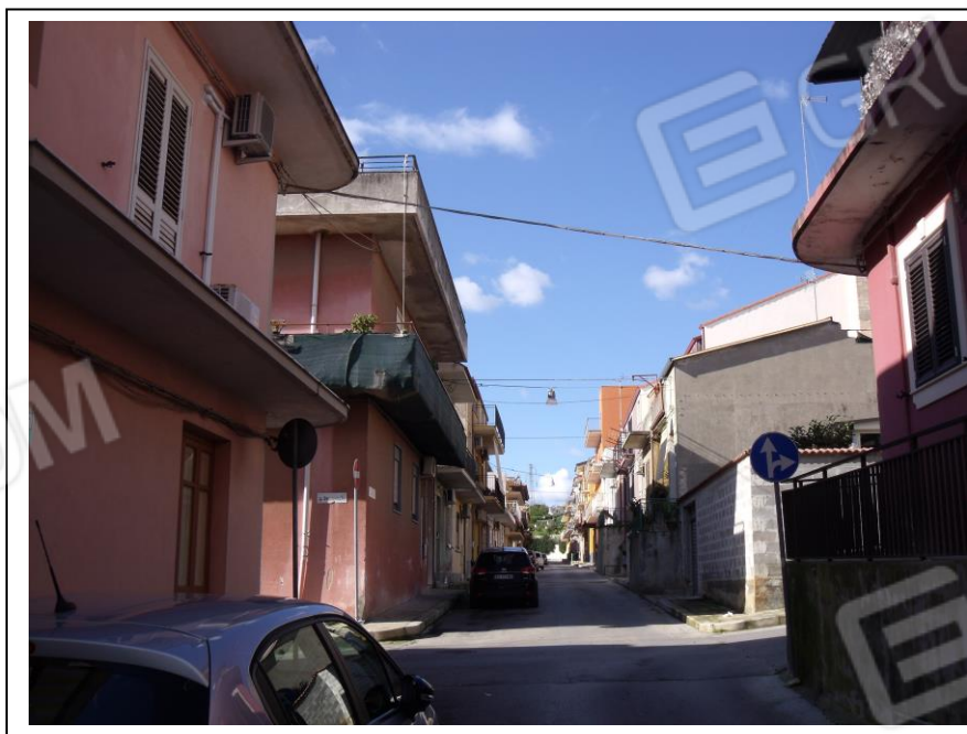
04. Vista su via Vittorio Alfieri con immobile in oggetto sul lato sinistro della foto.
