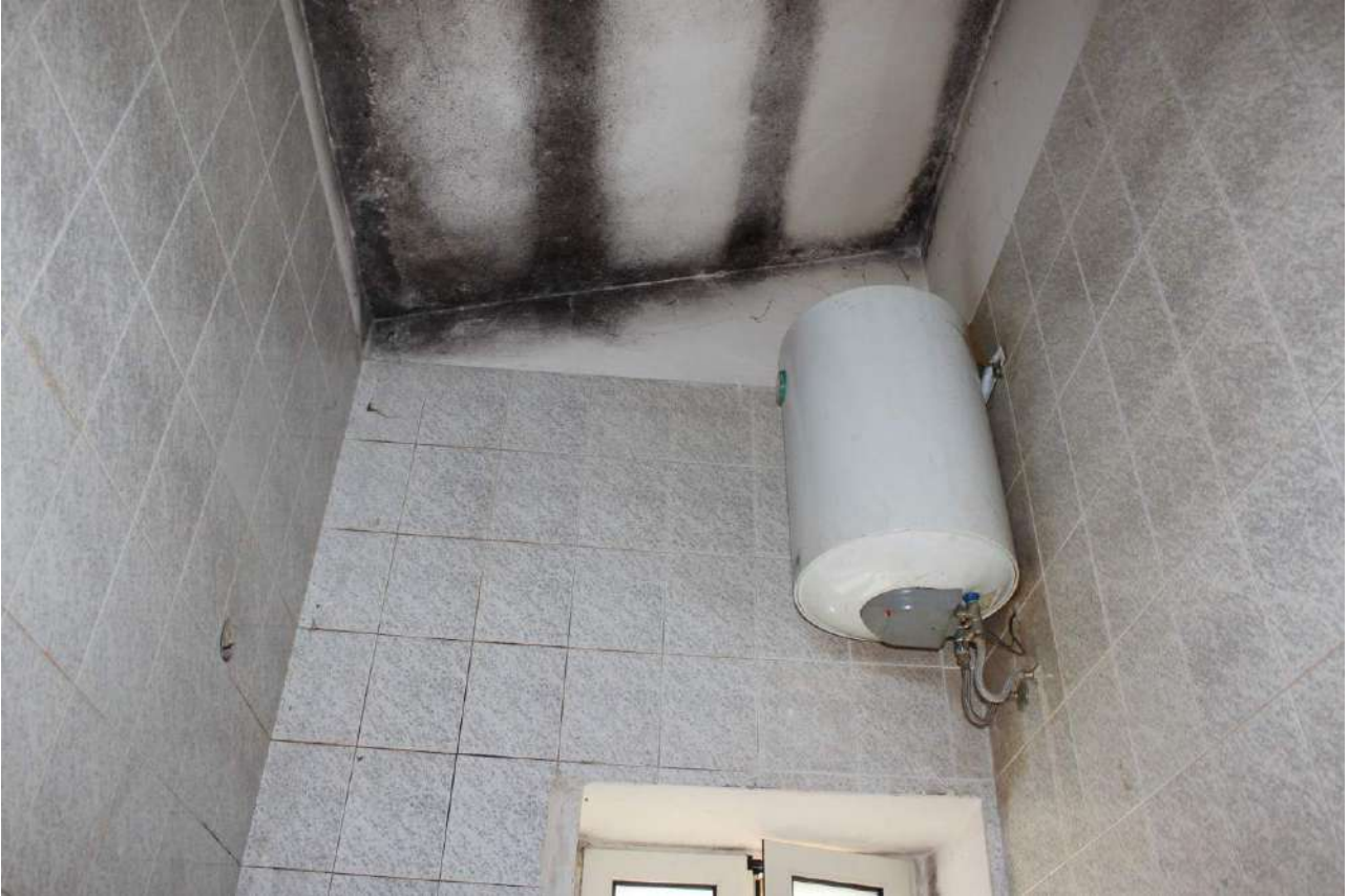
13) Servizio Igienico della casa a civile abitazione (P.Illa 124 – Lotto “A”)
