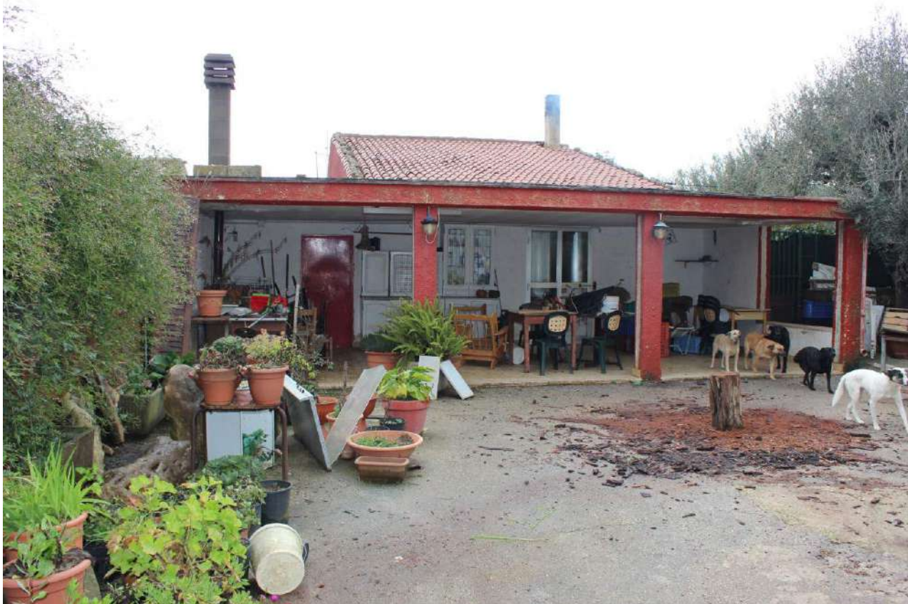
2) Portico (in difformità) in aderenza al prospetto est della casa a civile abitazione (P.lla 124 – Lotto "A")
