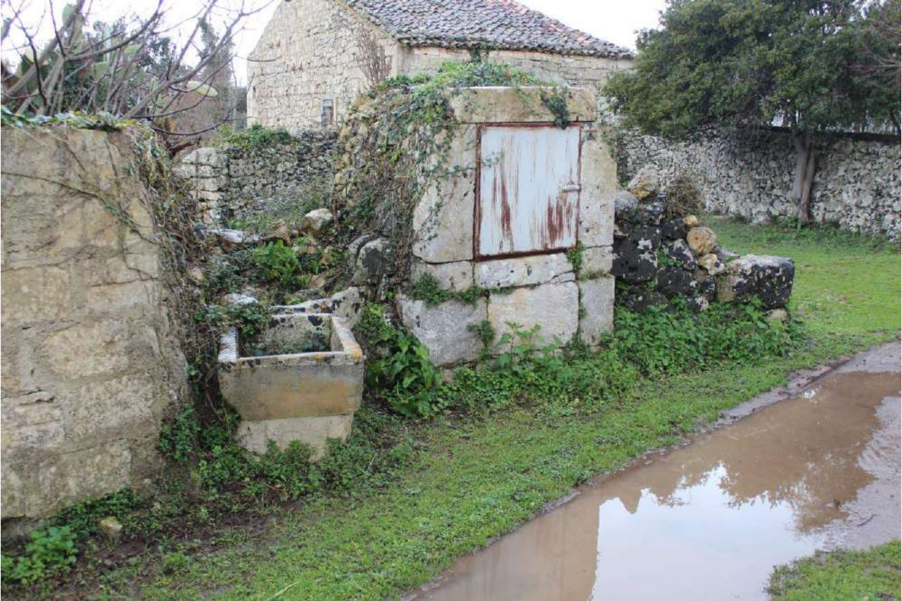
31) Pozzo Comune n.2, allocato all'interno di trazzera privata.
