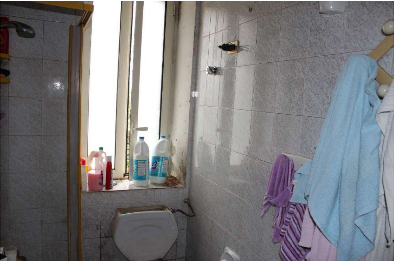
14) Servizio Igienico della casa a civile abitazione (P.Illa 124 – Lotto “A”)
