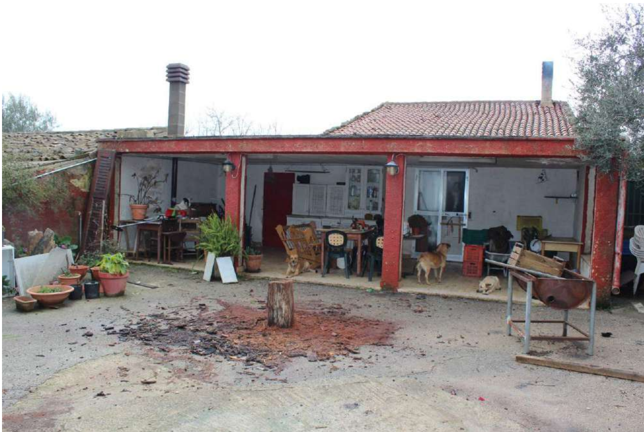
1) Portico (costruito su area di corte comune P.lla 125 non oggetto di pignoramento) in aderenza al prospetto est della casa a civile abitazione oggetto di pignoramento (P.lla 124 - Lotto "A")
