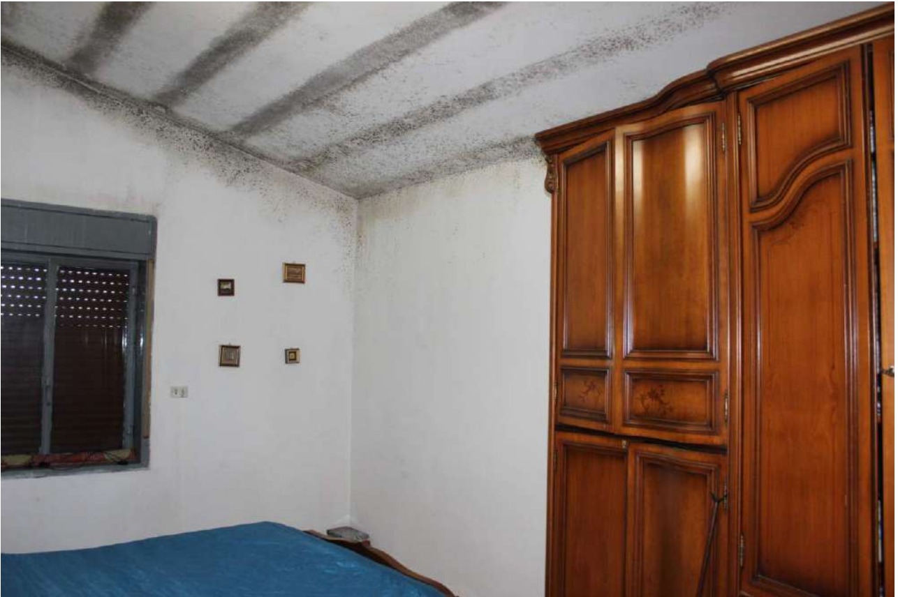
7) Stanza da Letto 1 della casa a civile abitazione (P.lla 124 – Lotto “A”)
