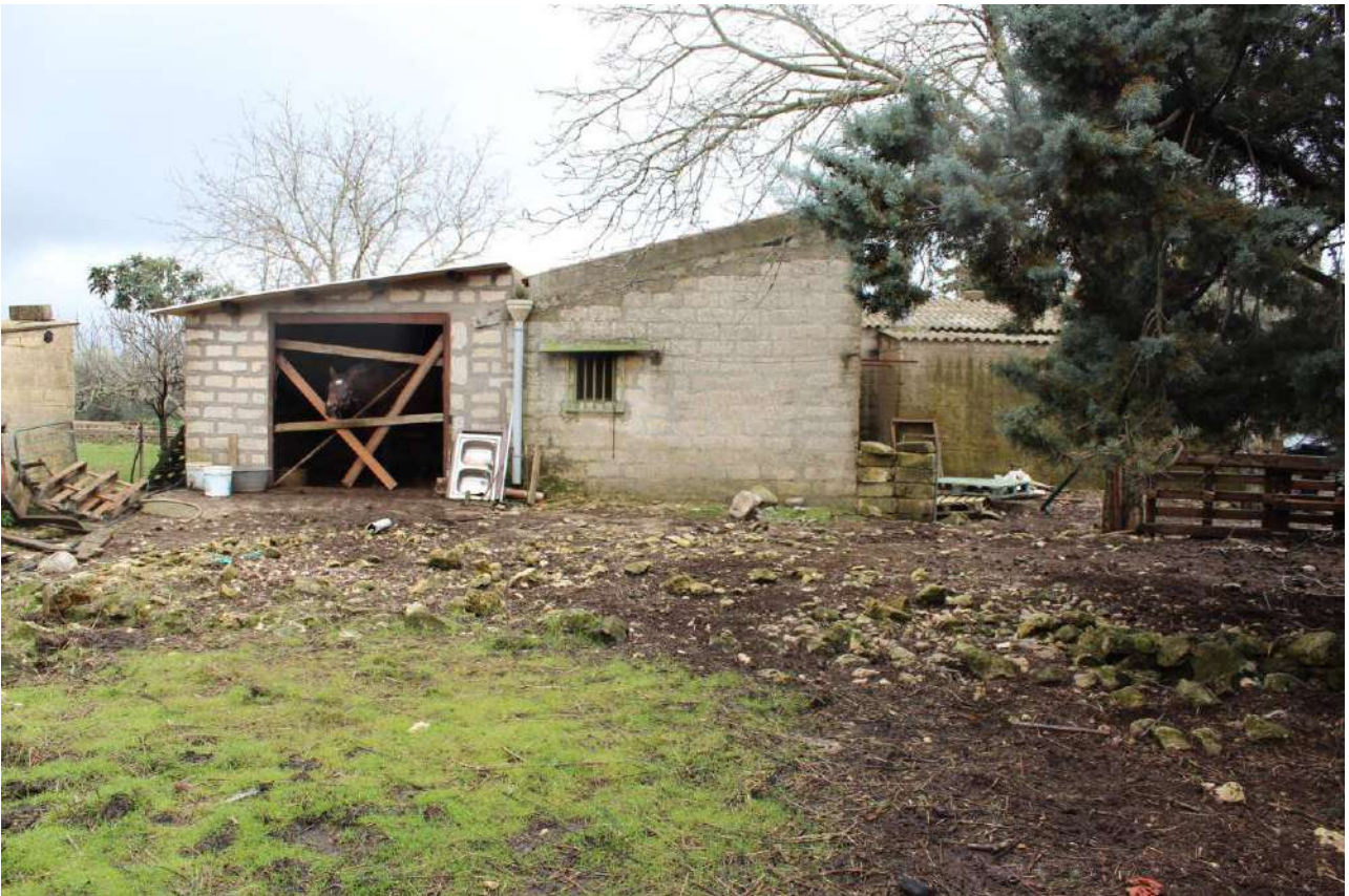
18) Fabbricato rurale adibito a depositi, lato Nord (P.lla 302 sub.1-2-3 – Lotto “B”)
