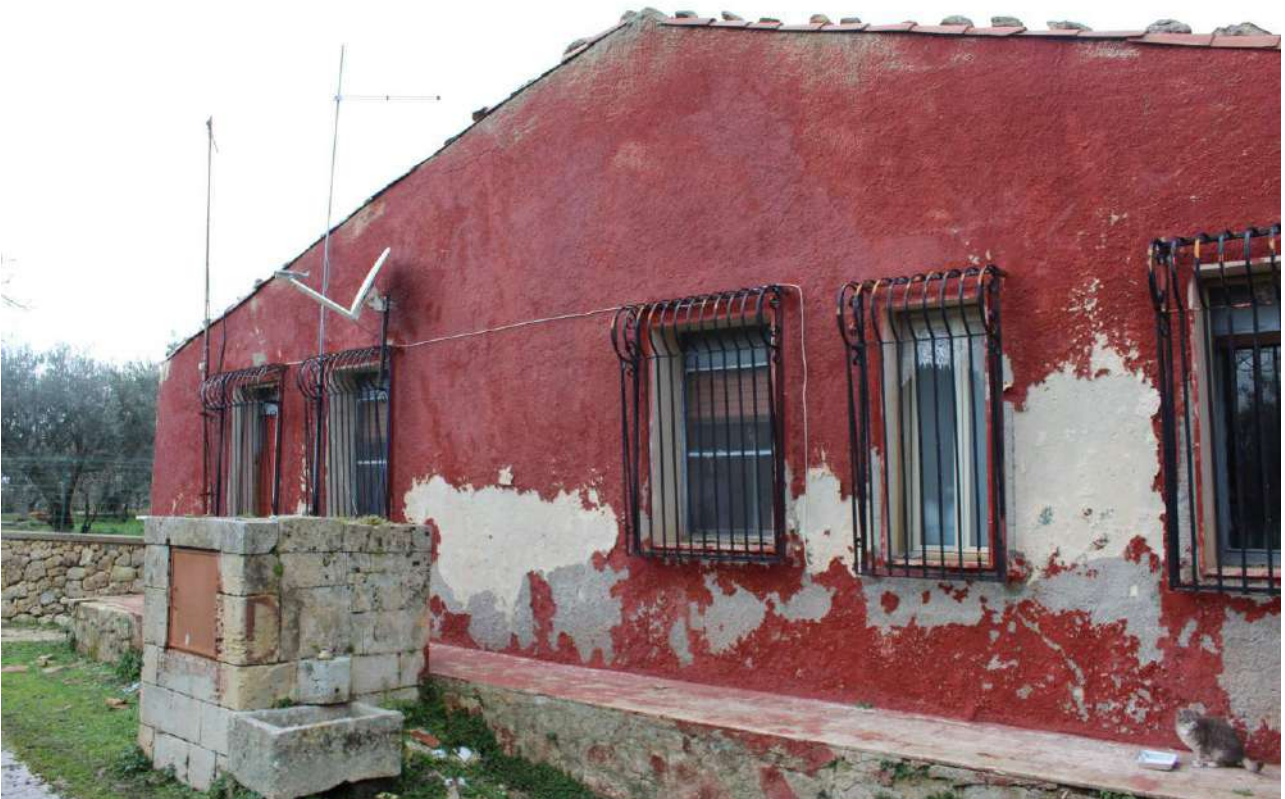
4) Prospetto Sud della casa a civile abitazione (P.lla 124 – Lotto “A”) e vista su area di corte comune dove è ubicato il pozzo comune n.1.
