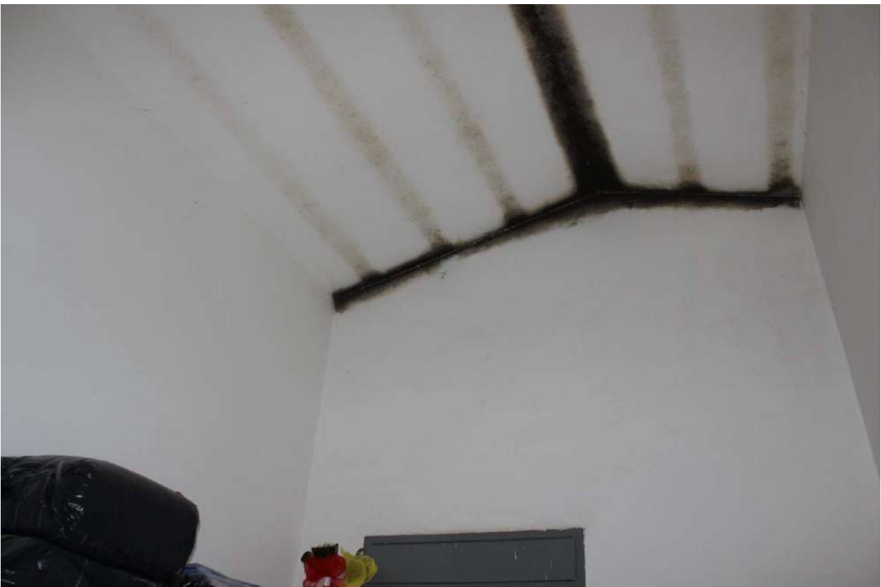
12) Stanza da Letto 3 della casa a civile abitazione (P.lla 124 – Lotto “A”)
