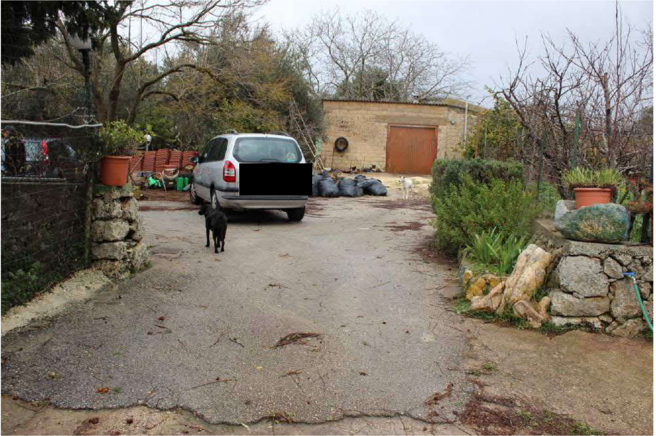
19) Fabbricato rurale adibito a depositi, lato Sud (P.lla 302 sub.1-2-3 – Lotto “B”)
