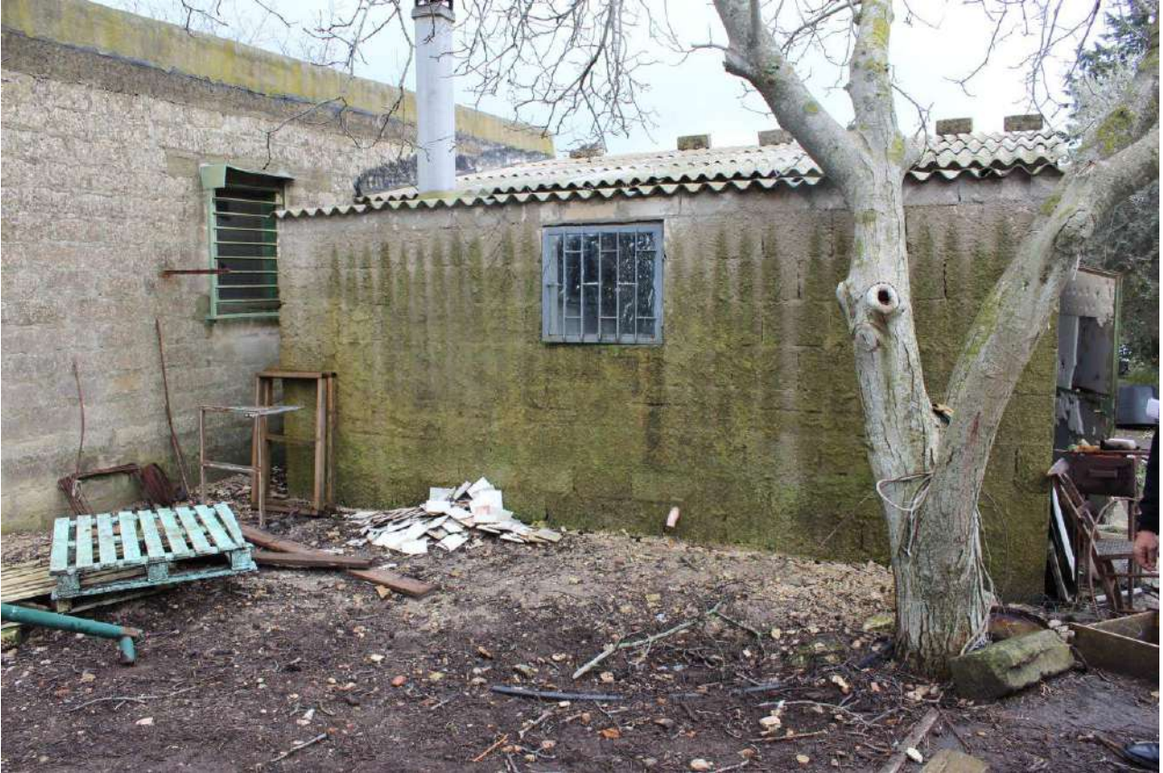
17) Fabbricato rurale adibito a depositi, lato Nord-Ovest (P.lla 302 sub.1-2-3 – Lotto “B”)
