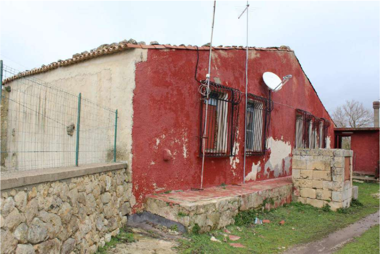
3) Prospetto Sud della casa a civile abitazione (P.lla 124 – Lotto “A”) e vista su area di corte comune dove è ubicato il pozzo comune n.1.
