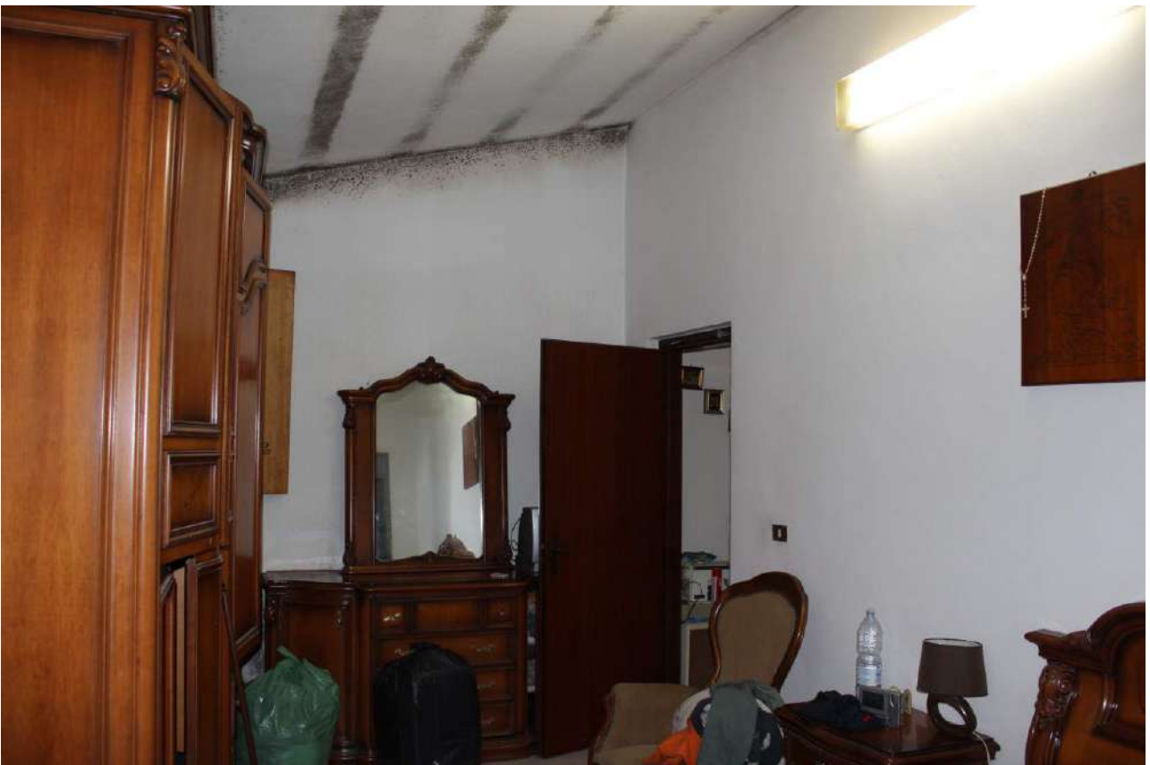
8) Stanza da Letto 1 della casa a civile abitazione (P.lla 124 – Lotto “A”)
