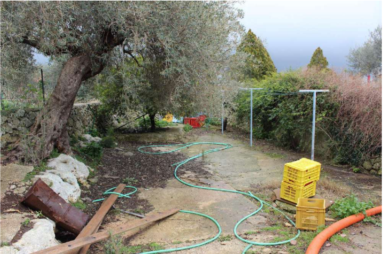
33) Ubicazione della fossa settica tipo imhoff al servizio della civile abitazione. (Punto d'accesso coperto da cassette gialle).
