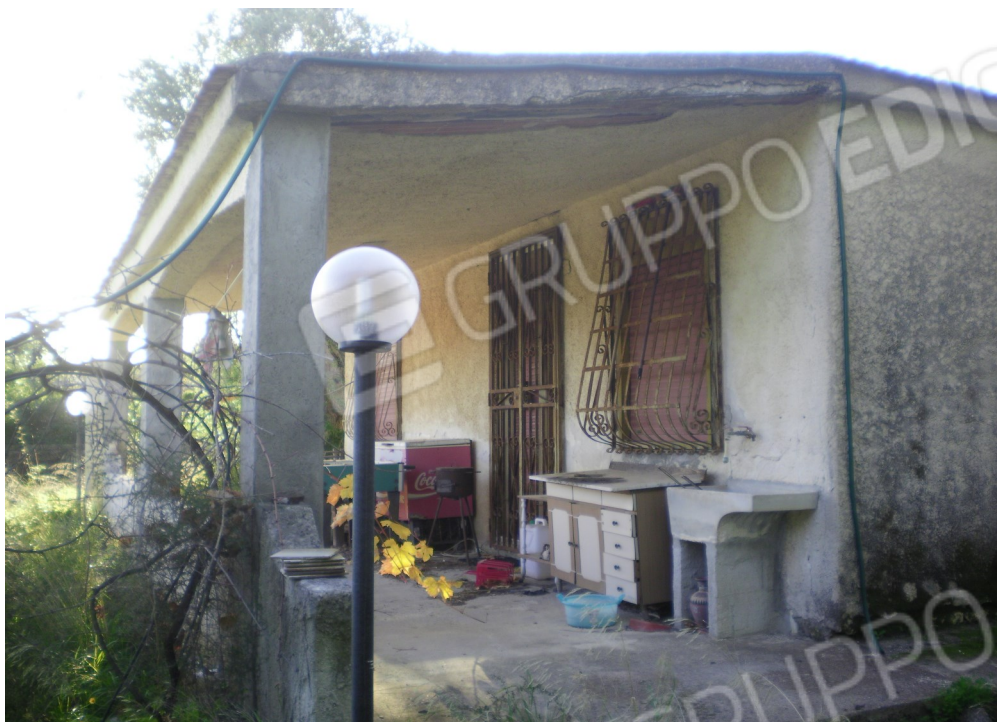
Foto 03: Vista prospetto Est
