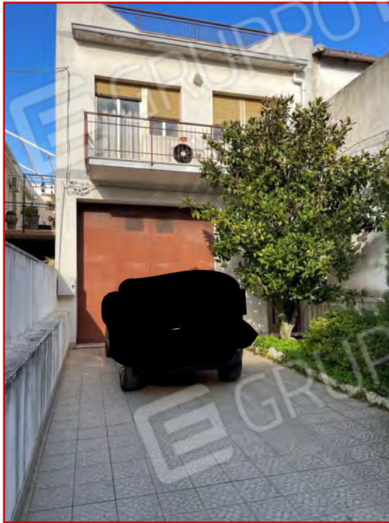
FOTO 3 – strada di accesso e portone di ferro di ingresso
