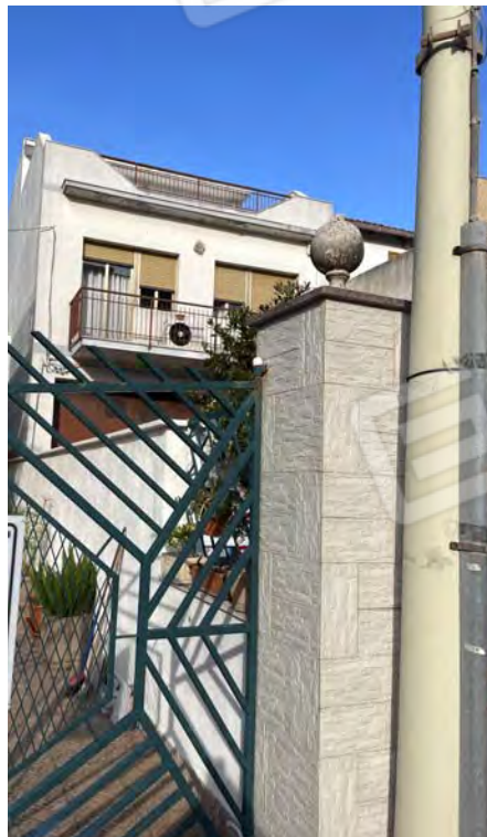
FOTO 2 – prospetto su Via Vittorio Emanuele III
