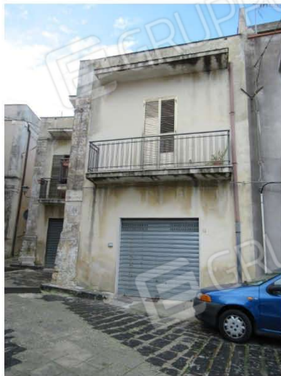
Foto 4_ Prospetto su Via Vittorio Emanuele
