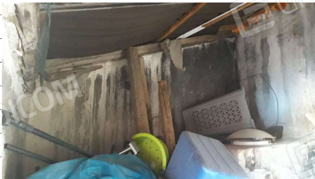
Foto n.28: interna del ripostiglio ubicato al primo terzo dell'immobile sito in via Sassari n.17 a Lentini.
