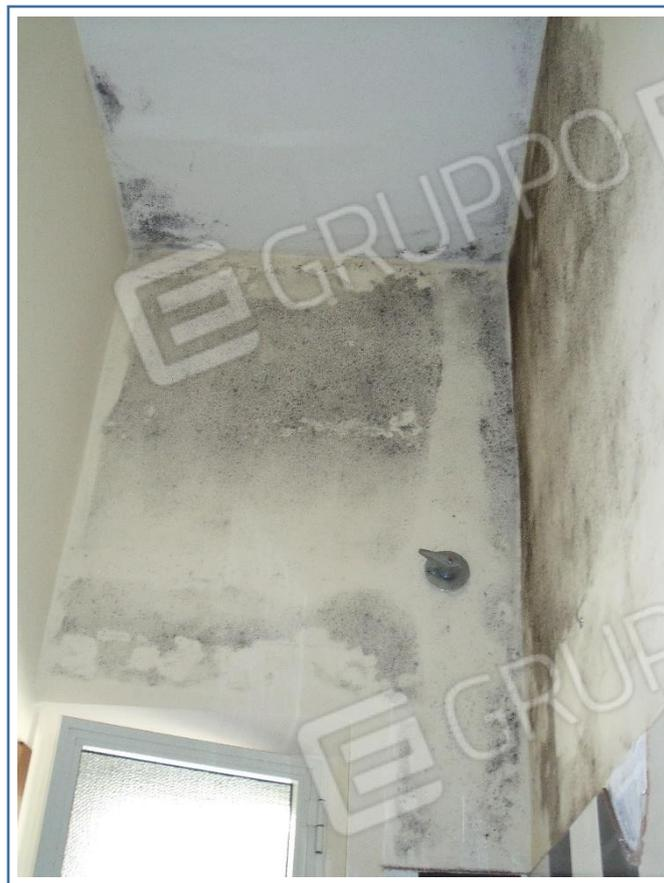
9. Interno del servizio igienico dell'unità immobiliare con vista lato nord-est. In foto evidente stato di degrado dello strato di finitura dell'intonaco.
