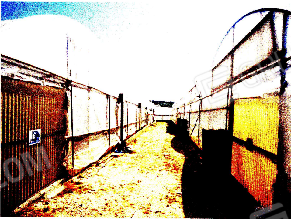
serre con struttura in acciaio
