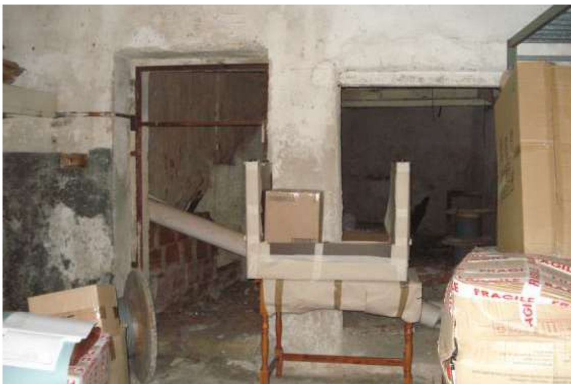
6. A2 | locale 2 , vista verso il locale 3
