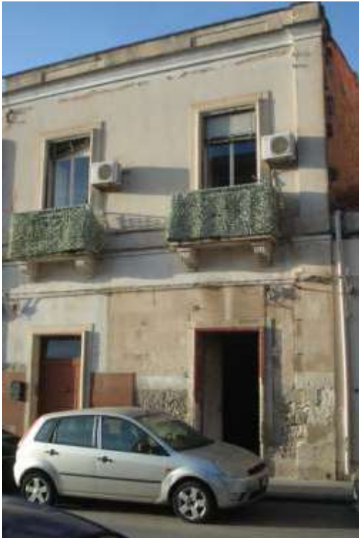
2_l'edificio visto da Via Agatocle
