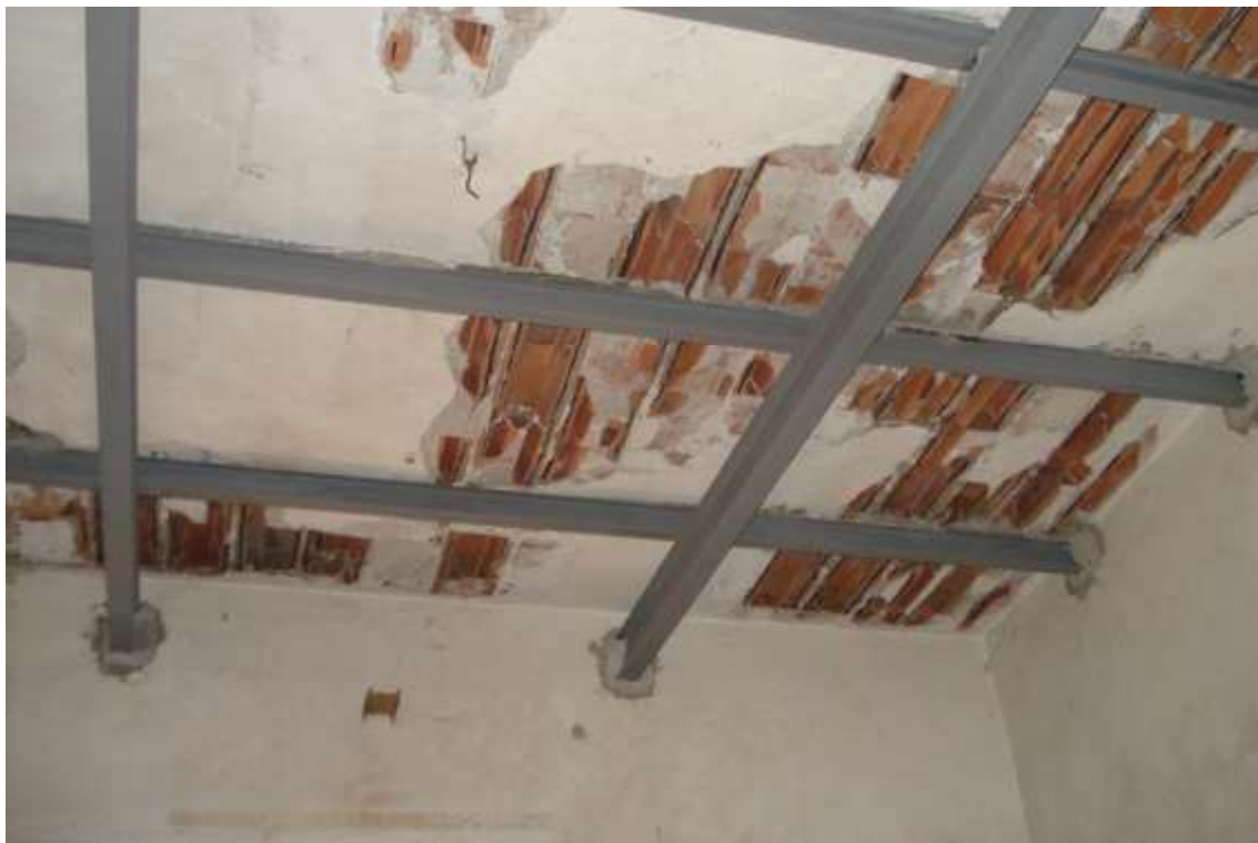
5 A1|locale 1 , il soffitto
