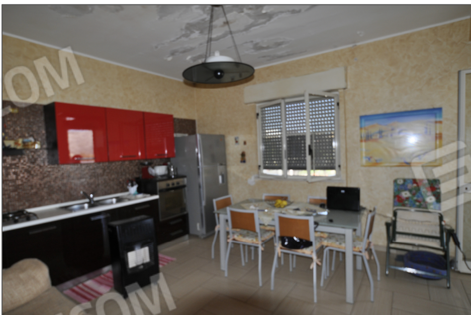
FOTO 6 - Vista interna - Cucina -
