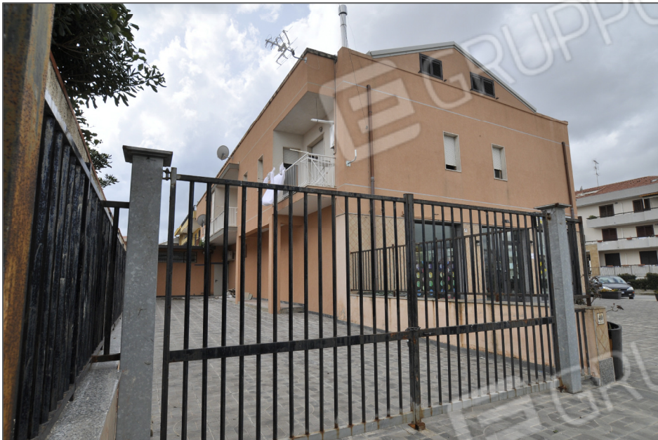
FOTO 2 - Vista esterna Fabbricato -
