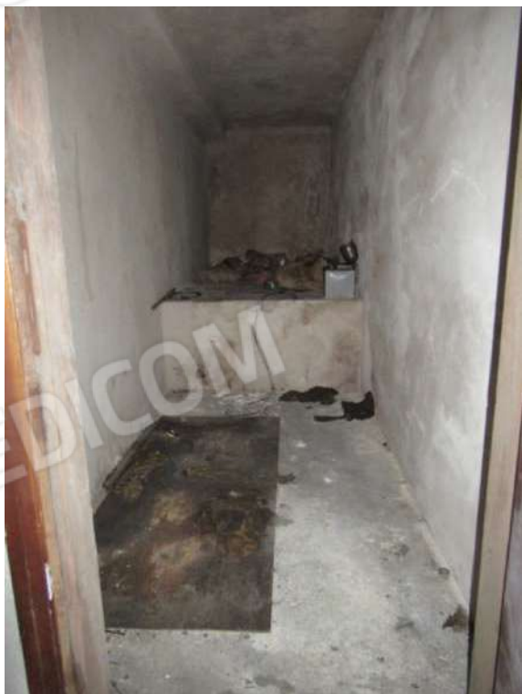
Foto 21_ Ripostiglio su rampa d'accesso
