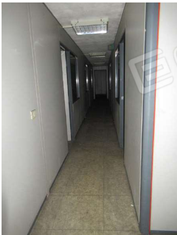
Foto 23_ Locali soprastanti Soppalco
