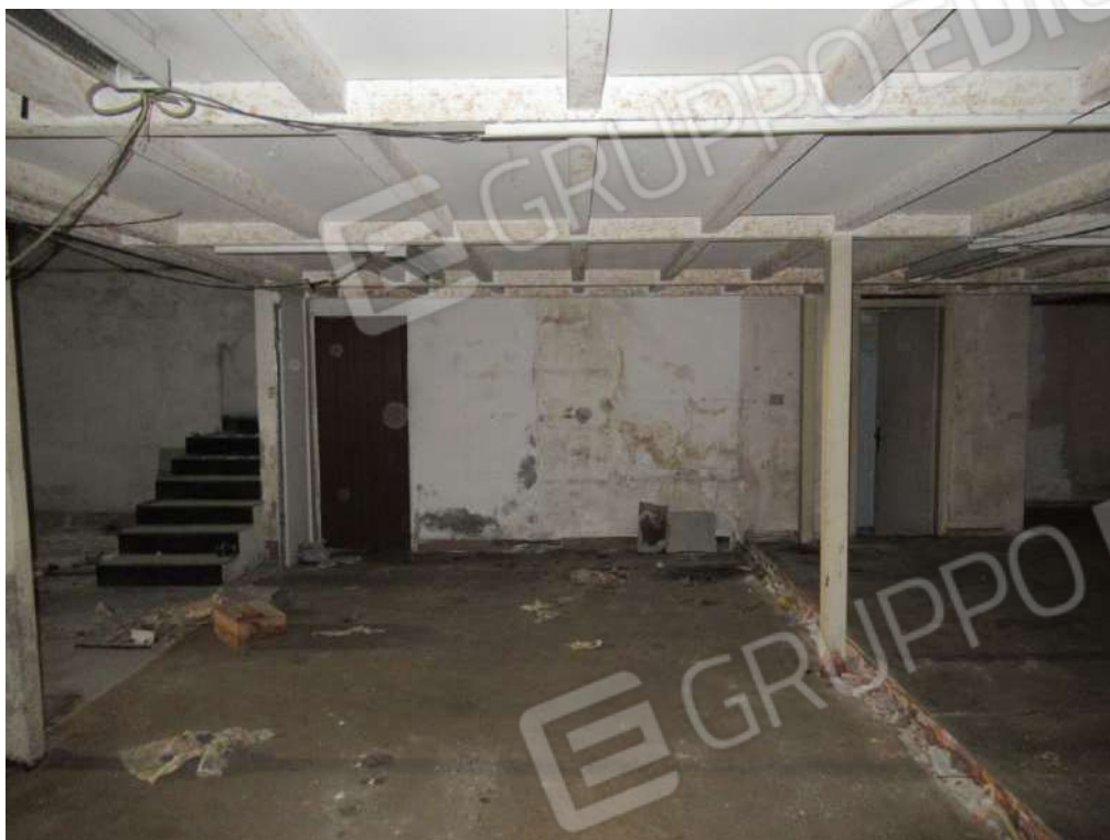
Foto 20_ Area sotto Soppalco
