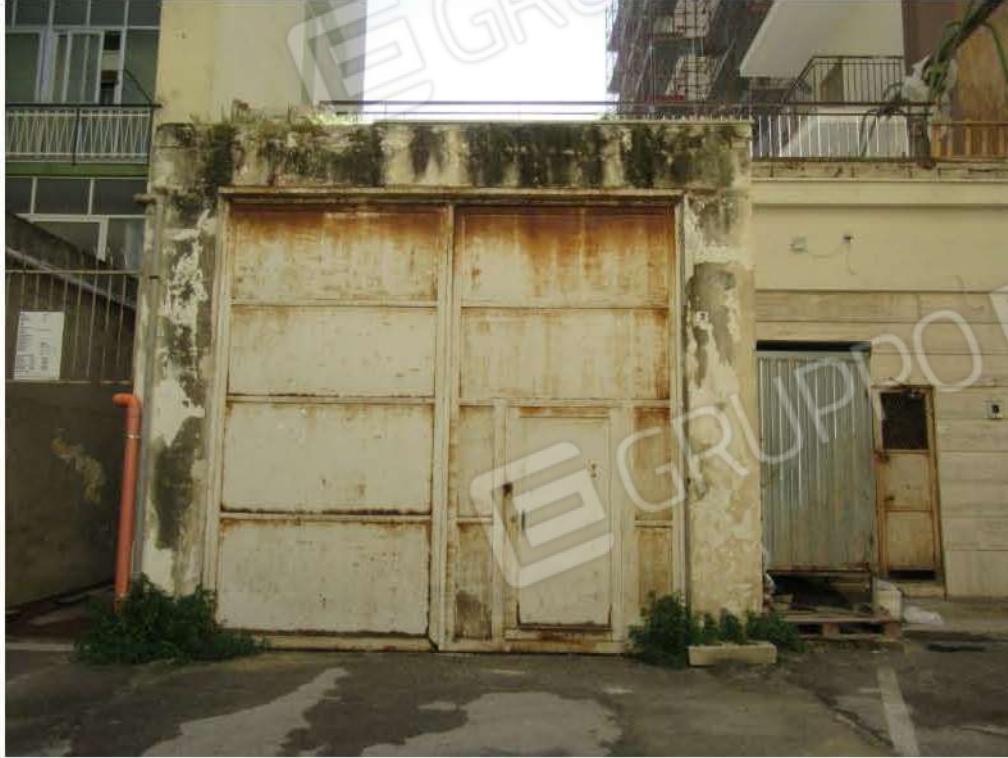
Foto 1_ Prospetto immobile su cortile condominiale
