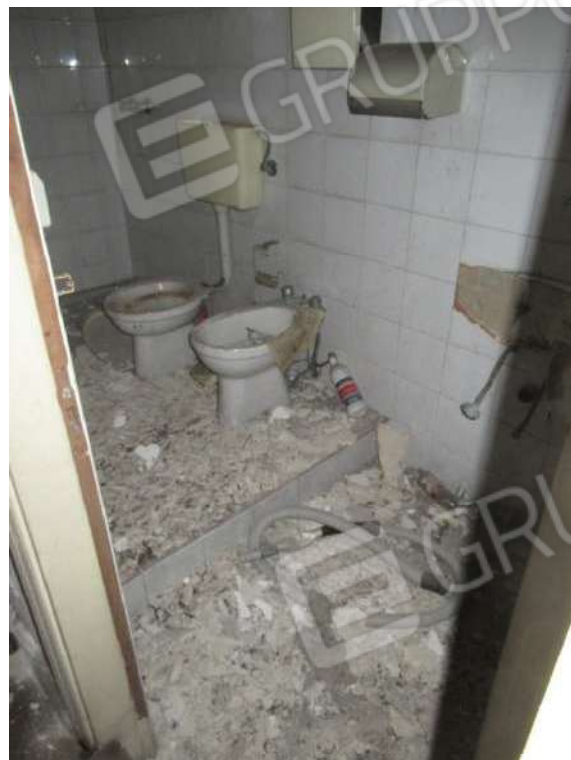
Foto 22_ WC sotto Soppalco
