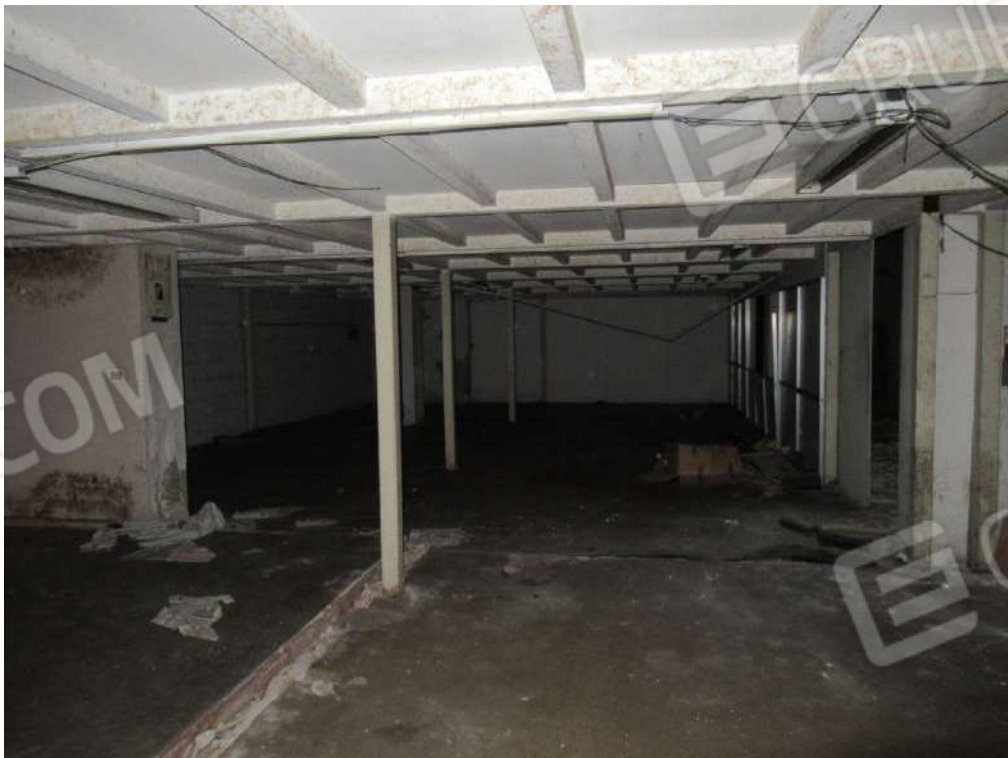
Foto 19_ Area sotto Soppalco
