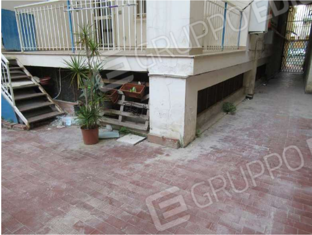
Foto 26_ Terrazzo condominiale piano terra lato ovest
