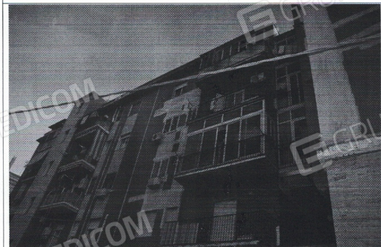
FOTO N.4 – Prospetto lato nord della palazzina A
