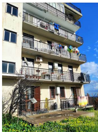
Foto 2,3,4. Fabbricato in cui è sito l'immobile
