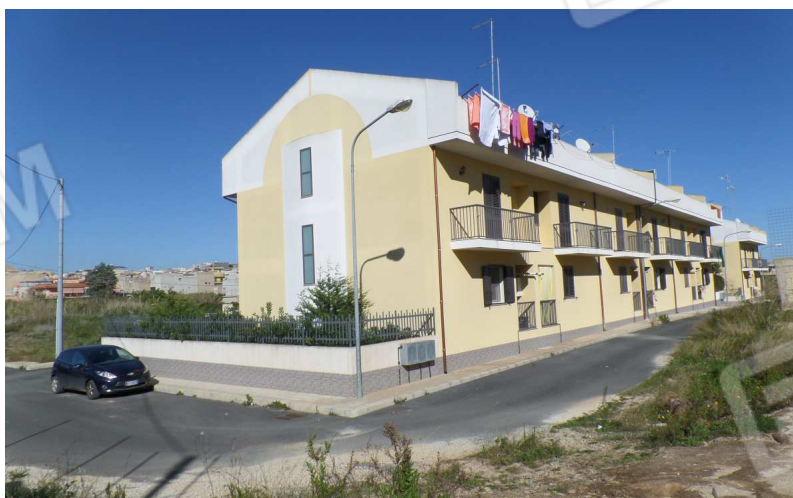
Foto n° 3. Pachino: Lotto "A45" oggetto di Perizia
