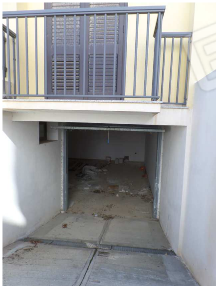
Foto n° 1.1. Garage: rampa d'accesso
