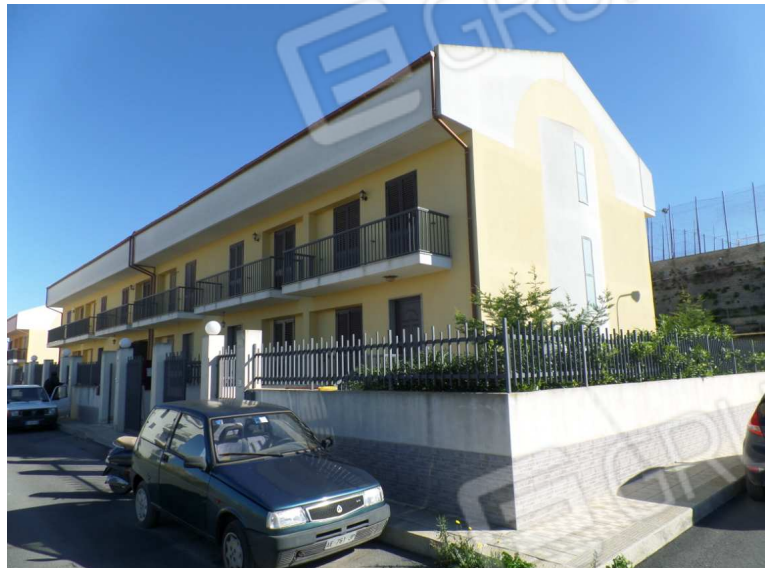
Foto n° 4.4. Prospetto su Via Concetto Olindo e prospetto laterale
