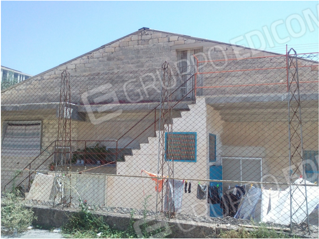
Foto 03. Tetto a due falde.
