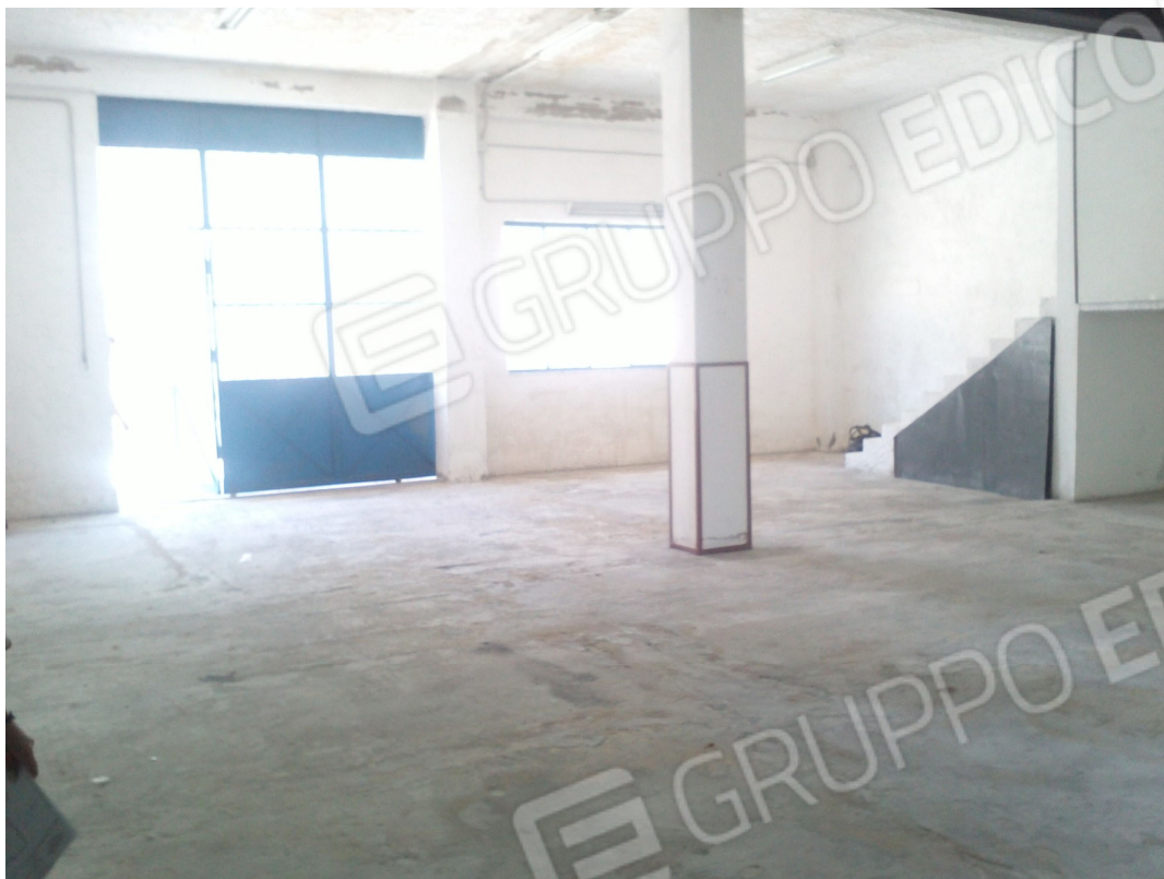
Foto 05. Scala presente all'interno del locale identificato al catasto al foglio 37 part. 13 sub 5.
