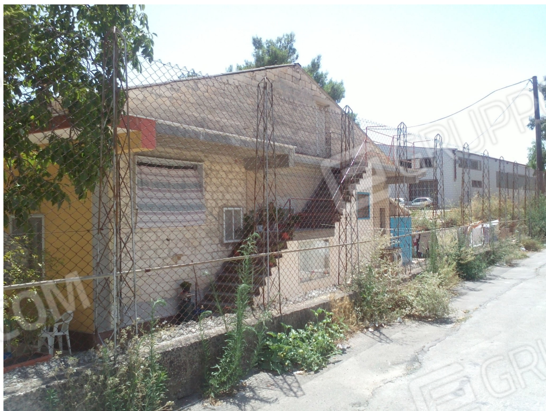
Foto 10. Muratura esterna senza intonaco al sub 8
