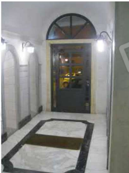
N. 3 - ANDRONE CONDOMINIALE
