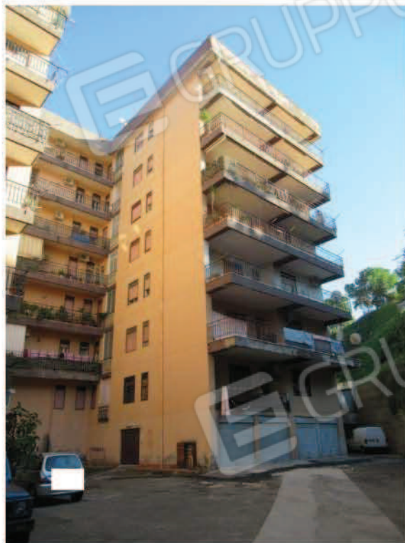
Foto 4_ Vista Ovest fabbricato
