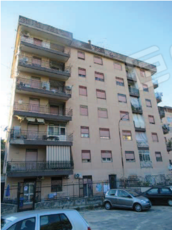
Foto 5_ Prospetto principale fabbricato
