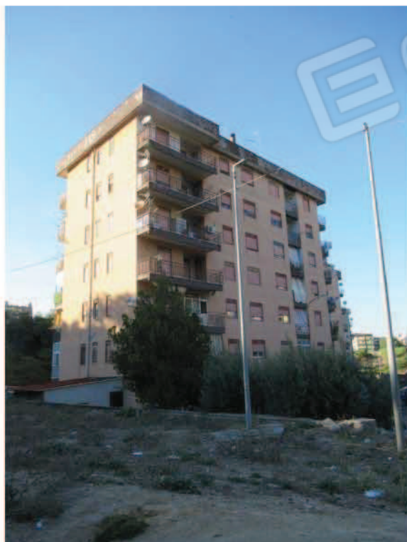
Foto 1_ Vista Est fabbricato
