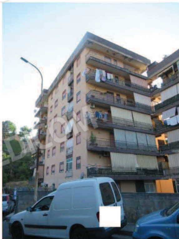
Foto 3_ Vista Nord fabbricato
