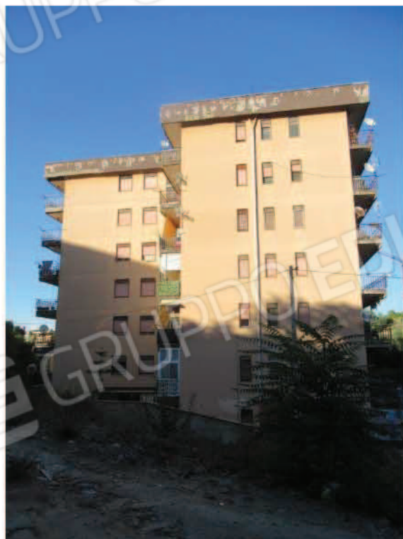
Foto 2_ Vista Sud fabbricato
