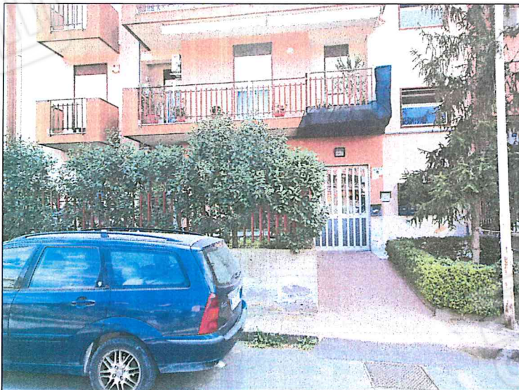
Foto 6-7 - Foto del primo piano con ingresso pedonale dalla scala B. La facciata è rivestita e rifinita ad intonaco. Gli infissi sono in alluminio con persiane avvolgibili. I balconi sono in discreto stato manutentivo. Si accede all'abitazione mediante ascensore e scala condominiale.
