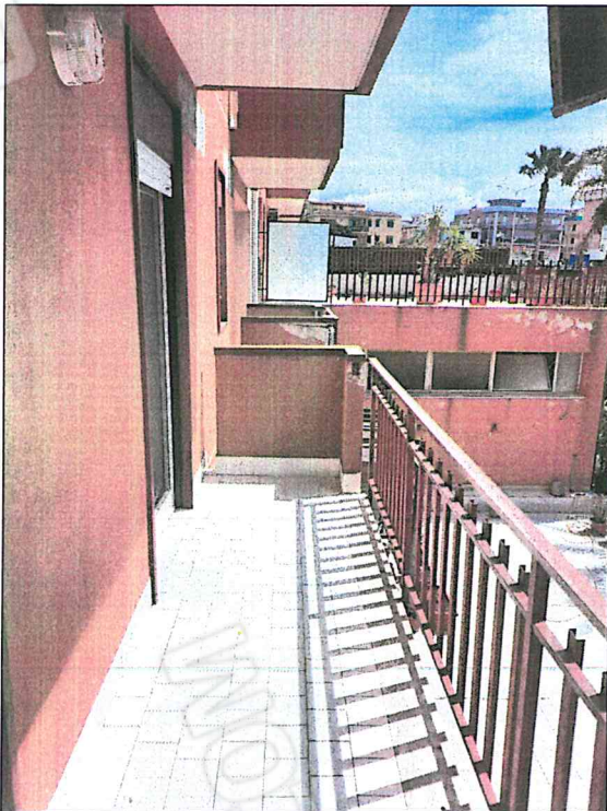
Foto 14-15 - Foto dei balconi rispettivamente lato soggiorno e lato cucina. I balconi sono pavimentati, il parapetto costituito da ringhiera in ferro e muretto e le solette dei ballatoi necessitano di manutenzione.
