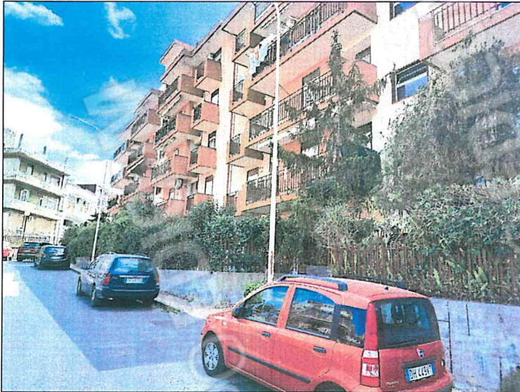
Foto 4-5 - Vista dei prospetti con affacci su via Falcone e su area privata a verde. Le facciate si trovano in buono stato conservativo, ad eccezione dei balconi e del cornicione (con lieve degrado) che necessitano di manutenzione.
