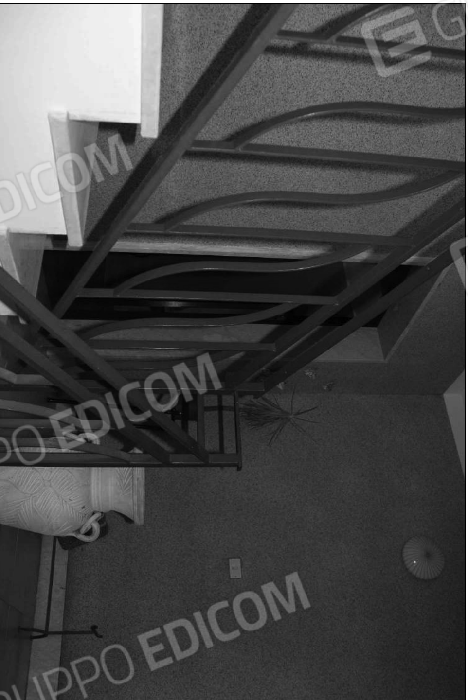
N.24 Vano Scala
