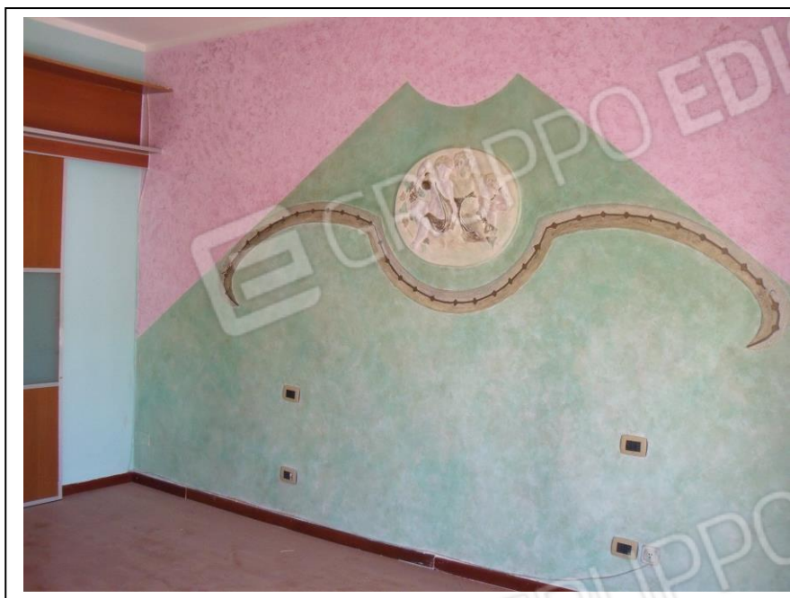
28. Interno u. i. con vista verso lato nord-est. Sulla sinistra porta scorrevole di accesso al vano adiacente.
