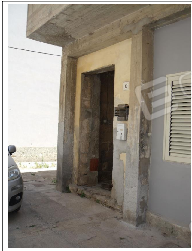
03. Vista prospettica della costruzione con prospetto laterale su stradella di accesso, piano terra. Ingresso a n. civico 10.
