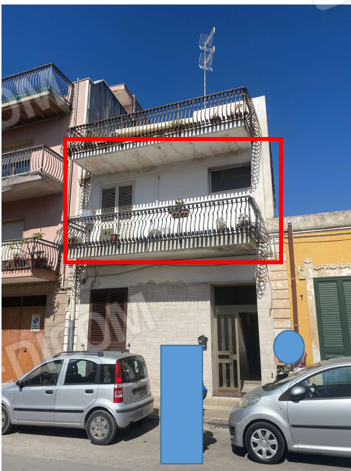
Foto 2: Vista del fabbricato di cui fa parte l'appartamento pignorato. Il riquadro in rosso indica la porzione di appartamento prospiciente su Viale V. Veneto, oggetto di pignoramento.
