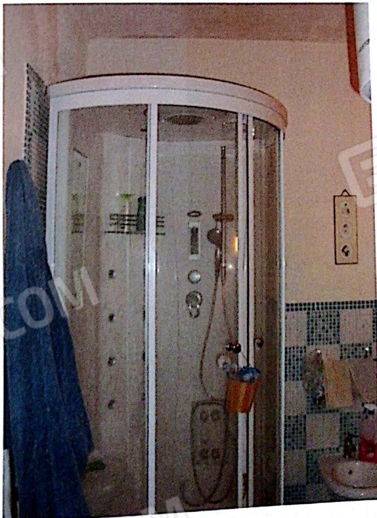
VISTA 6 – Bagno LOTTO 1
