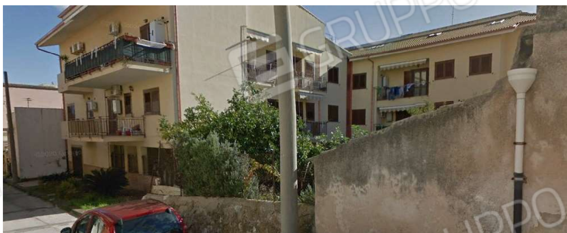
Foto n. 16: Lotti B1-B2-B3-B4-B5-B6-B7 – Ingresso condominio da via Bologna
