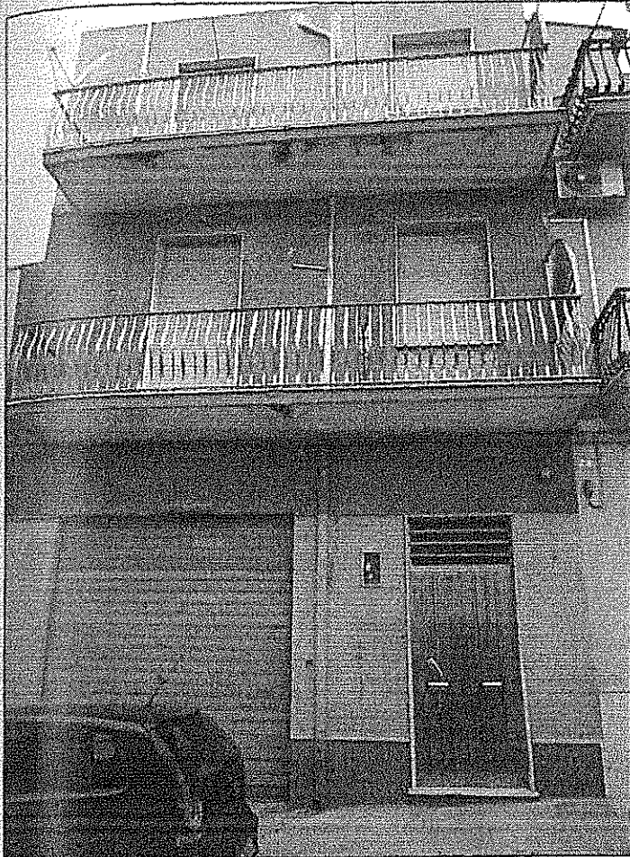
Foto1: Prospetto principale dell'immobile sito in via Gioberti n°85-87 P.T.-1°-2°.
