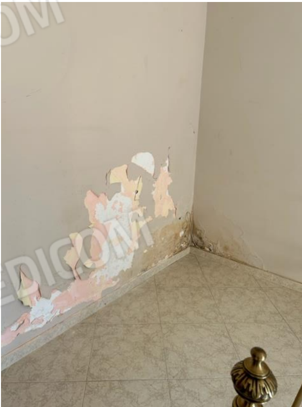
VISTA 11_Camera matrimoniale/Infiltrazione Wc VISTA 12_Camera P.1.
