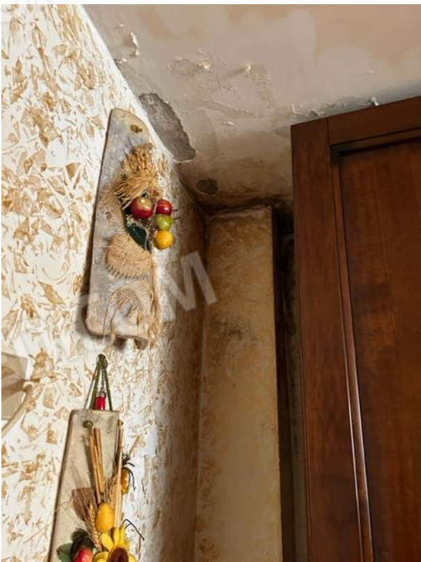
VISTA 7_Cucina P.T./ Infiltrazioni colonna wc
