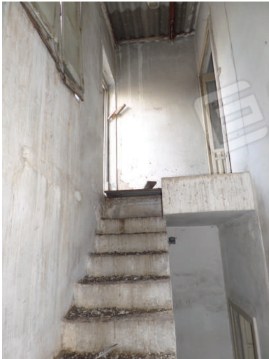
Foto n° 1.13. Scala Piano Primo - Piano Secondo
