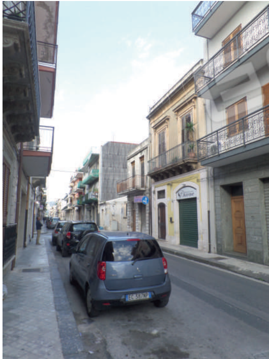
Foto n° 1.1. Via Archimede: vista sud
