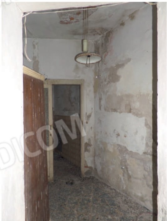
Foto n° 1.11. Piano primo: Camera
