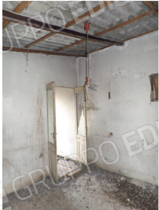
Foto n° 1.14. Piano Secondo: Lavanderia
