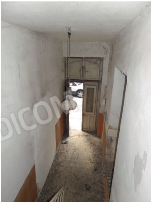
Foto n° 1.7. Piano Terra: ingresso
