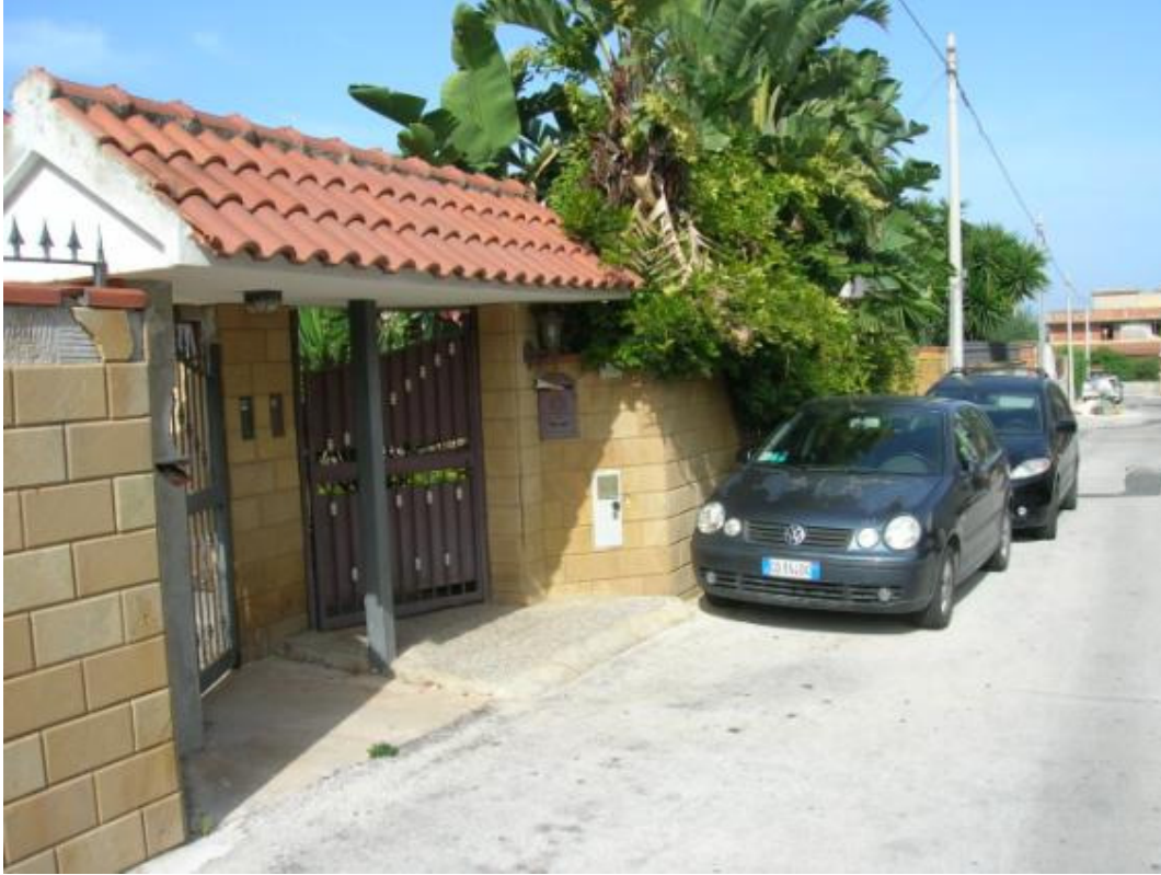
FOTO N.1 – Cancello d'ingresso al lotto
