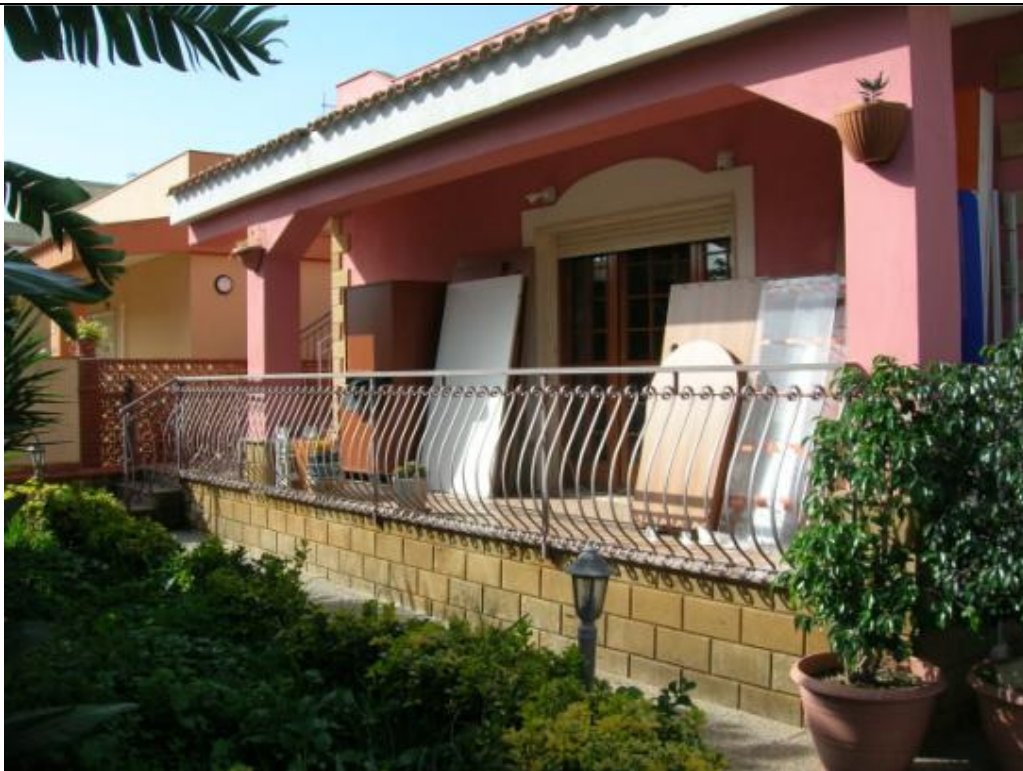
FOTO N.2 – Prospetto lato est
