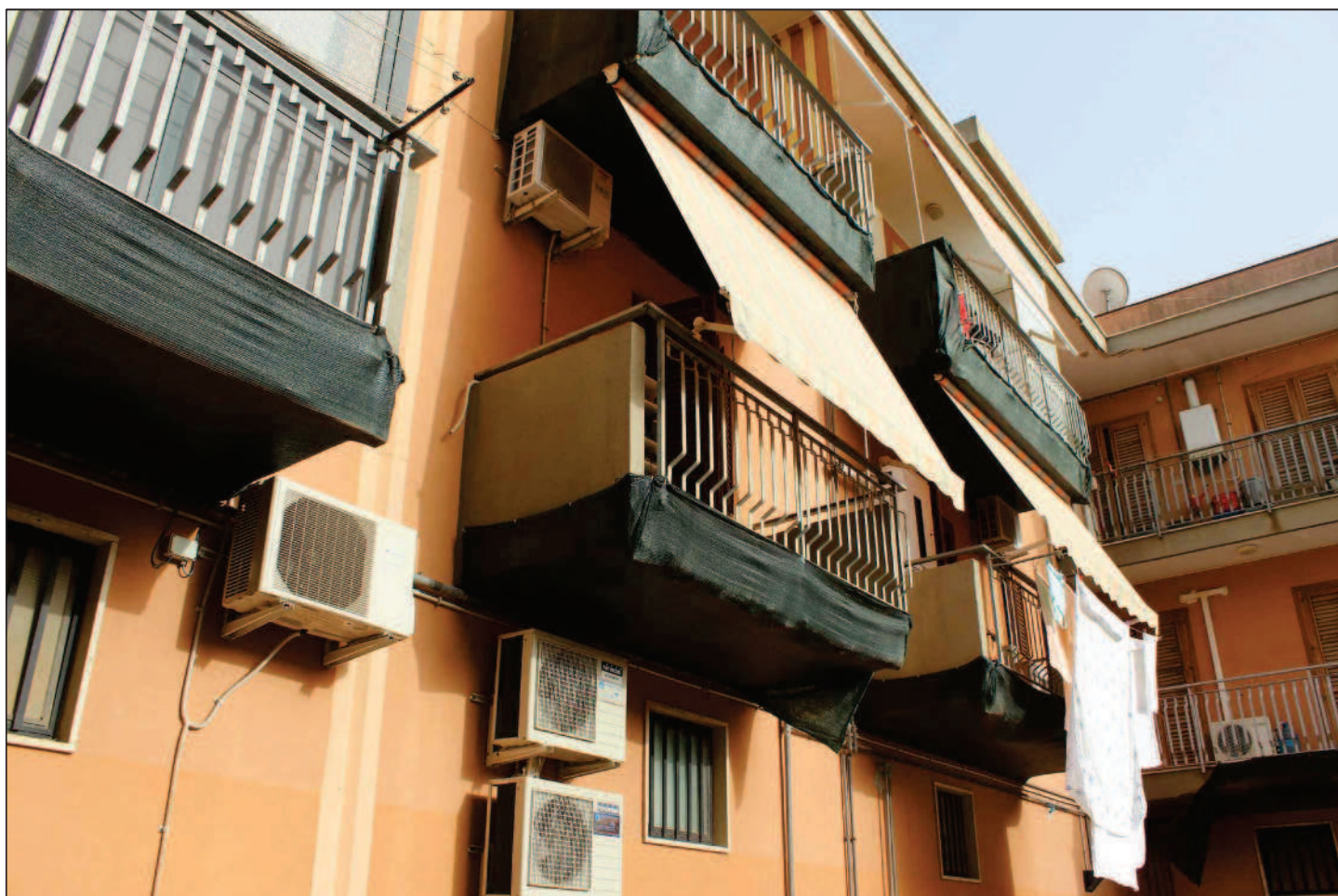
N.4 Vista da cortile condominiale interno
