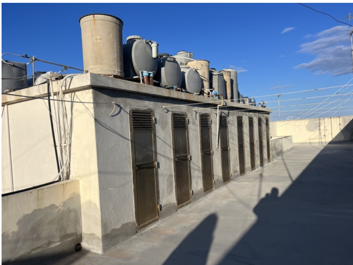
FOTO 14 -Vista esterna del locale ripostiglio collocato al piano terrazza condominiale.
