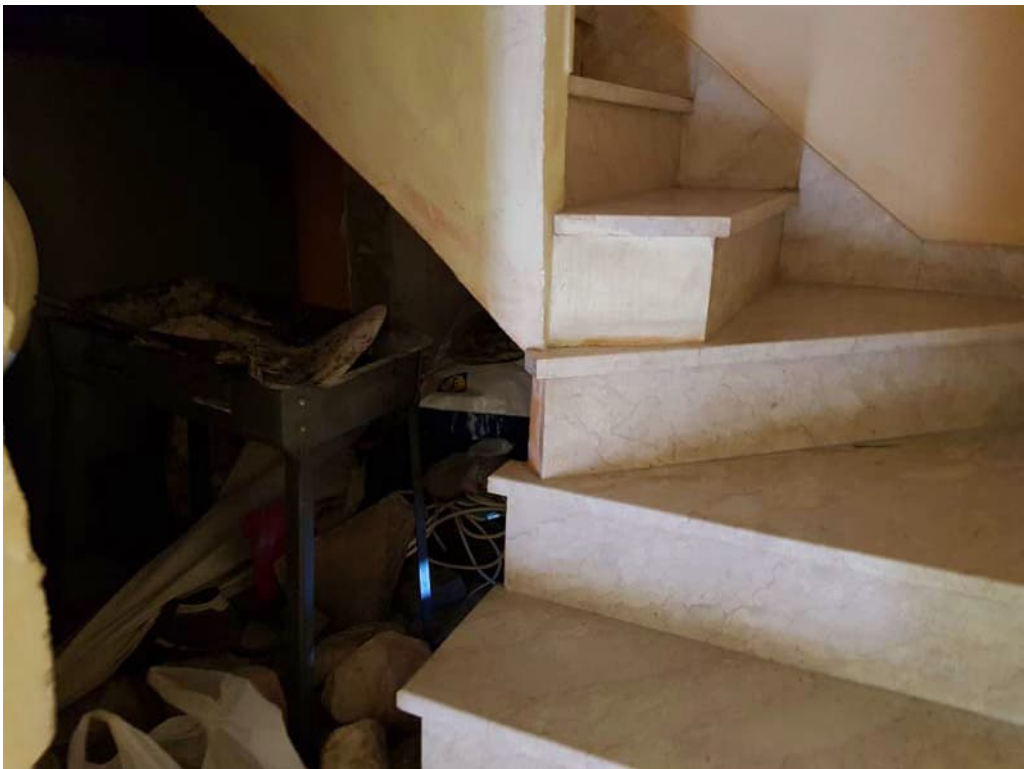
Vista del vano sottopalcato contenente scaldabagno e serbatoio dell'acqua
