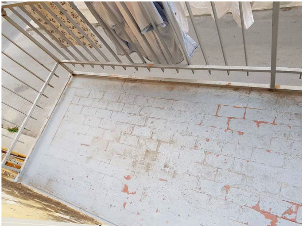
Vista del balcone B della camera da letto L1
