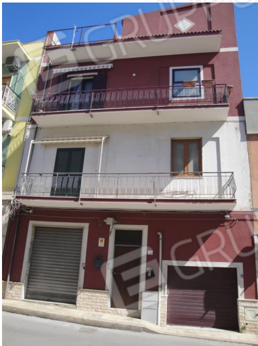
foto 1_ veduta del prospetto su via Palestro
