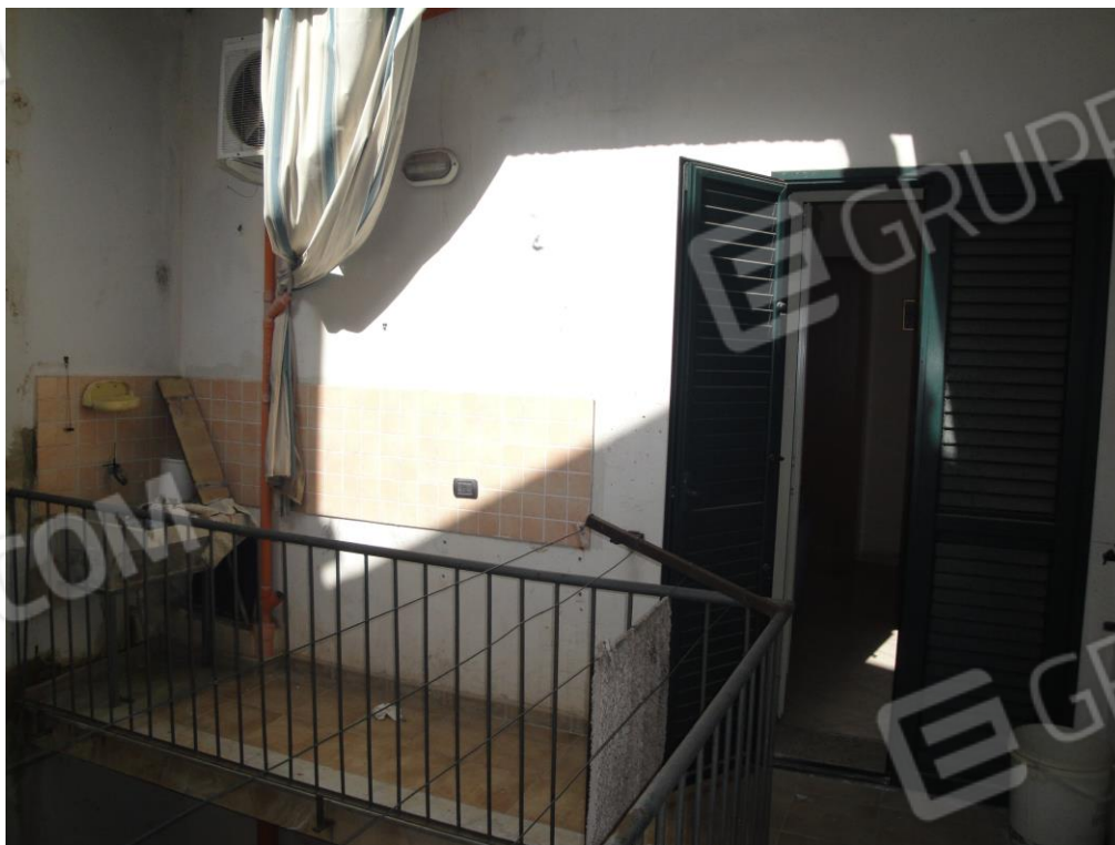
foto 6_ veduta del cavedio interno
