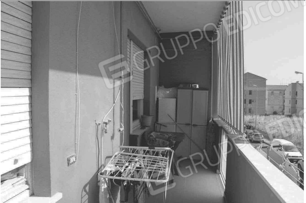
Foto n. 05 – Vista Ballatoio esterno
