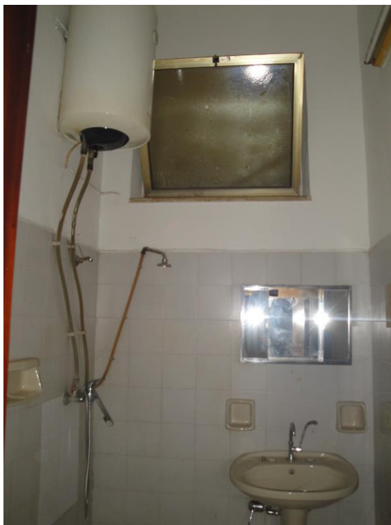
foto 6_ vista del bagno
