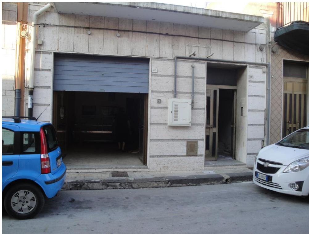
foto 1_ prospetto principale su via Ariosto, 117
