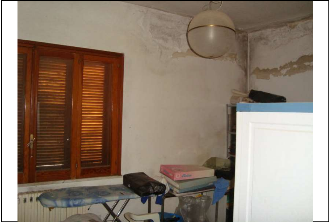
Foto n° 35. – Camera 3 – via per Canicattini n.18
