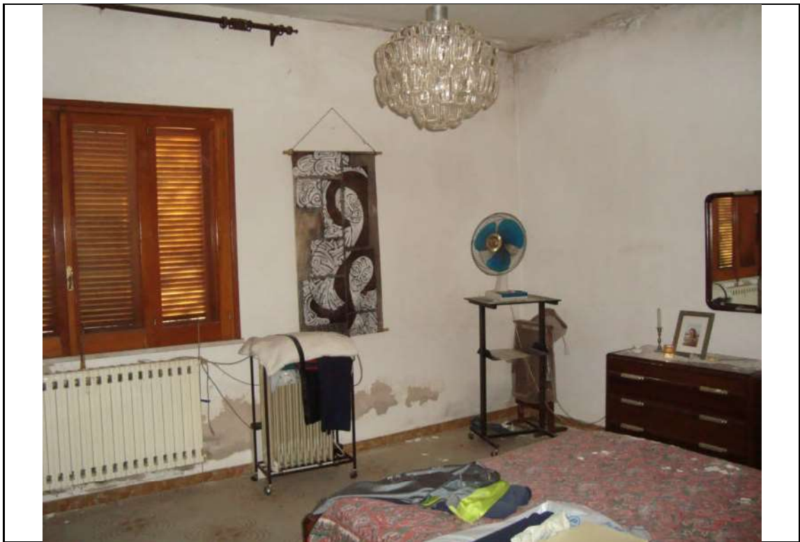
Foto n° 34. – Camera 2 – via per Canicattini n.18
