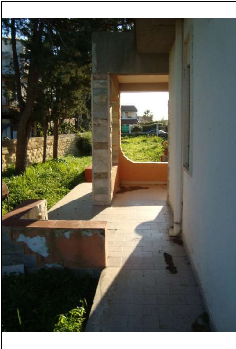
Foto n° 6. – Portico – via Lago Ampollino snc
