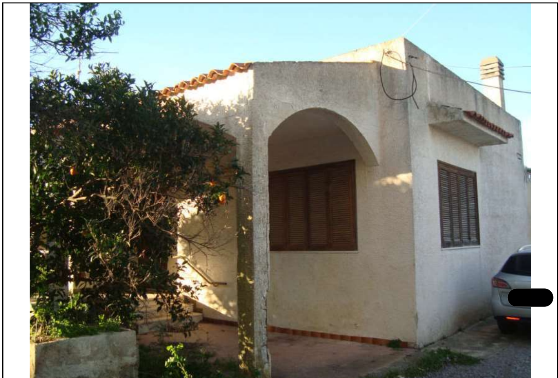
Foto n° 25. – Facciata – via per Canicattini n.18
