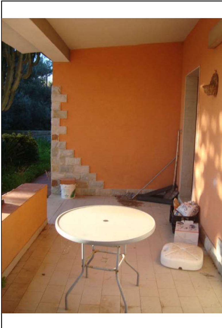
Foto n° 5. – Portico – via Lago Ampollino snc
