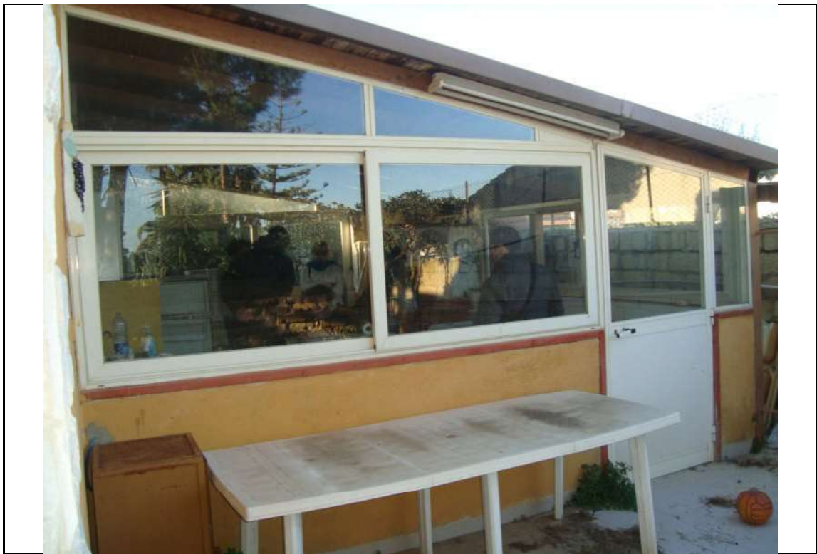
Foto n° 10. – Facciata – via Lago Ampollino snc
