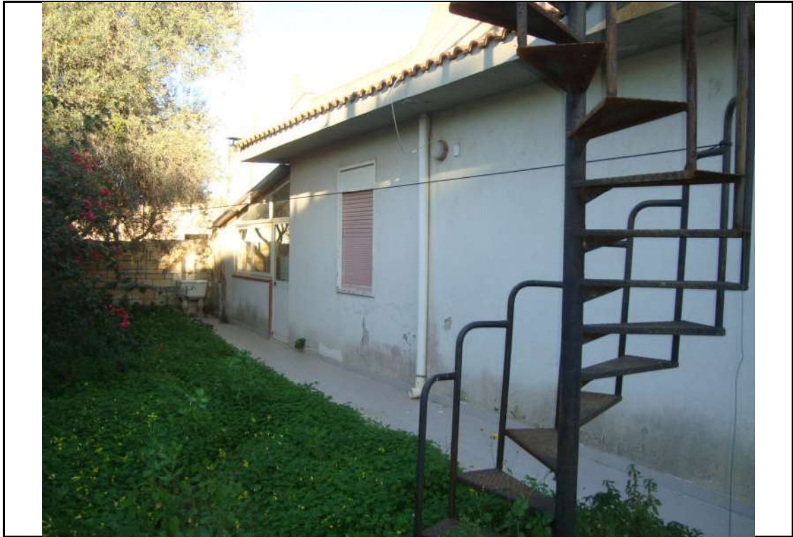
Foto n° 9. – Facciata – via Lago Ampollino snc
