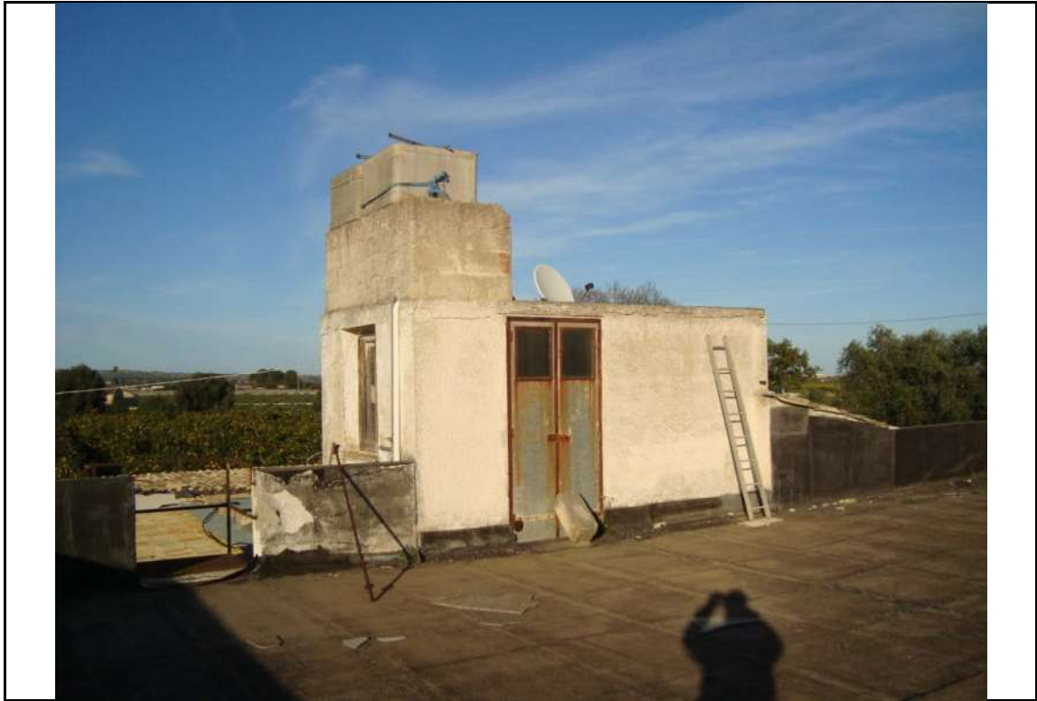
Foto n° 38. – Locale di sgombero – via per Canicattini n.18
