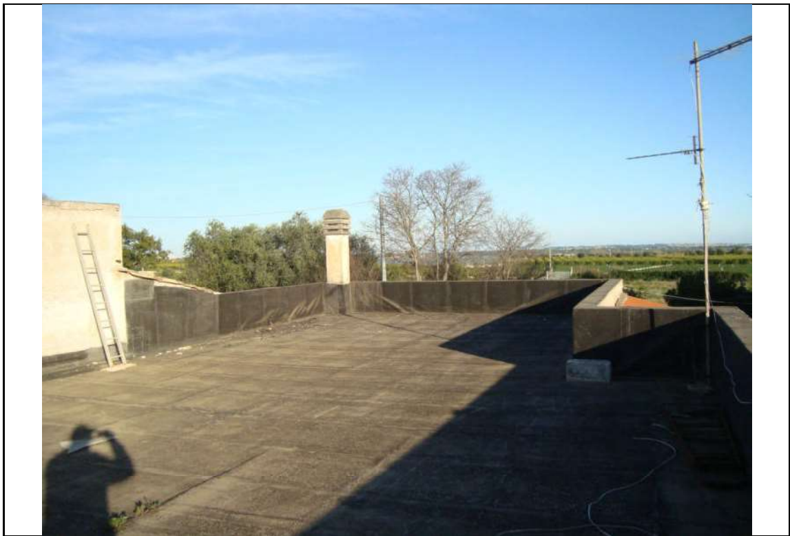
Foto n° 39. – Lastrico solare – via per Canicattini n.18
