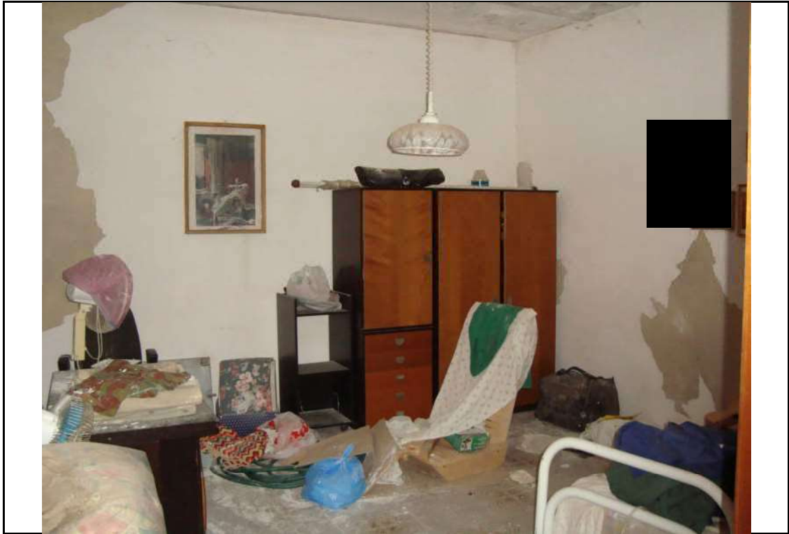
Foto n° 33. – Camera 1 – via per Canicattini n.18
