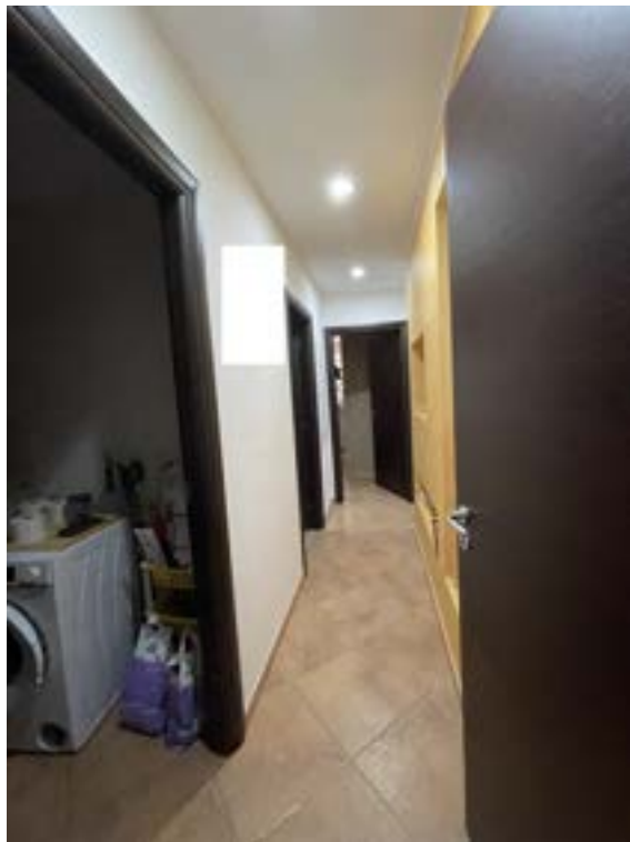
Fotografia D.24 - Piano terra: corridoio-locale abusivo
