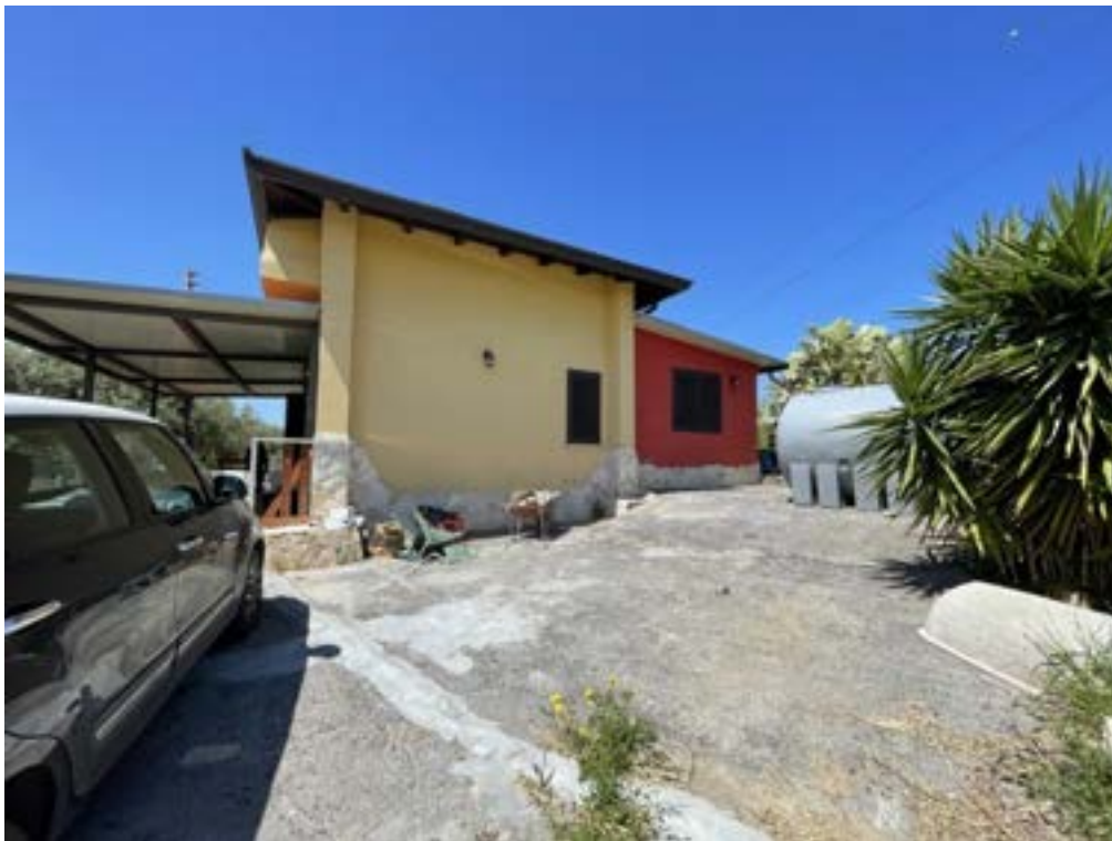
Fotografia D.6 - Prospetto sud-est: locale colore giallo regolare-locale rosso abusivo
