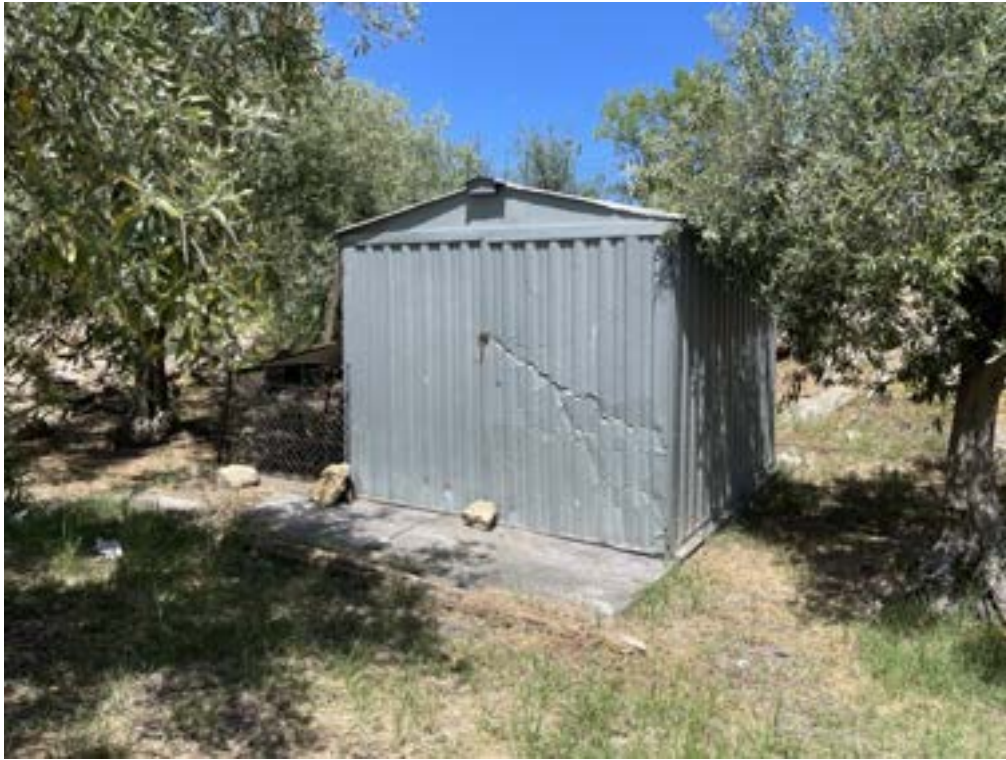
Fotografia D.27 - Casotto con pareti in lamiera zincata: p.lla 90
