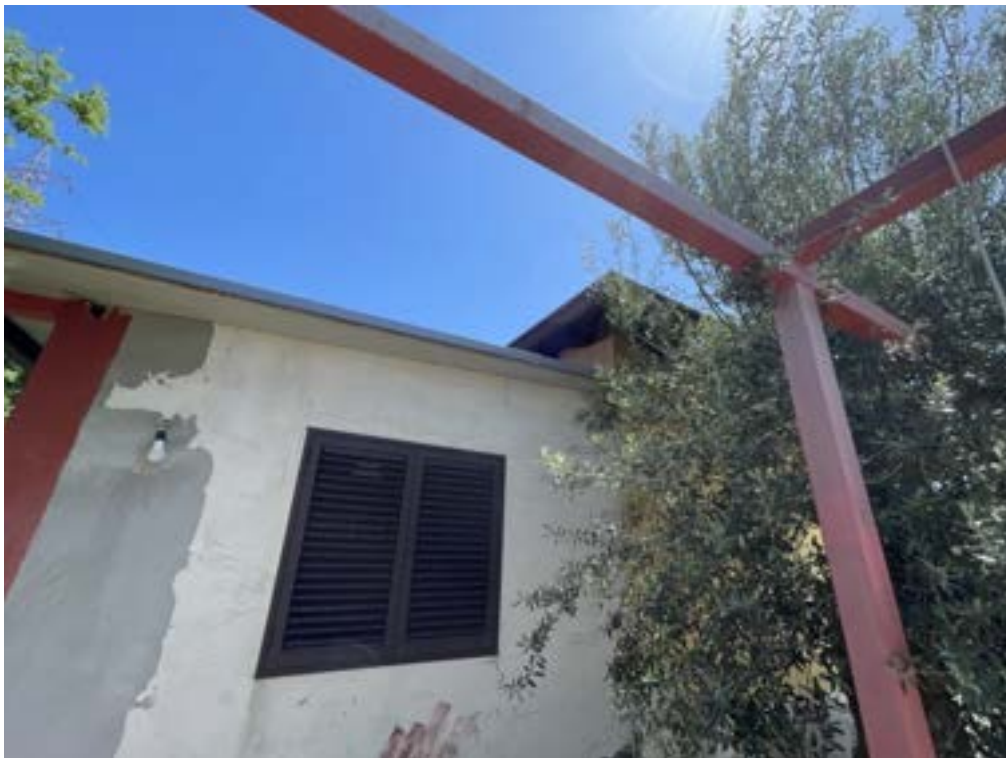
Fotografia D.10 - Parete nord-ovest
